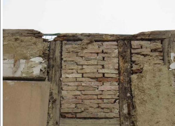
Fachwerkfassade Südseite, Fachwerkschäden im Obergeschoss, beispielhaft
