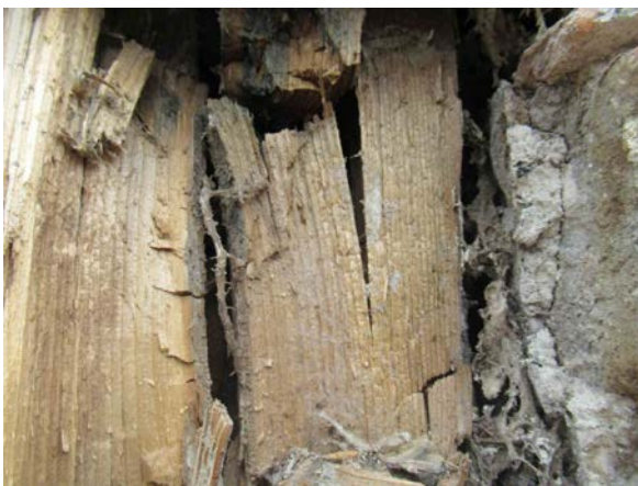
Fachwerkfassade Westgiebel, Rähm im Obergeschoss zerstört, Befall Echter Hausschwamm am Rähm und am Stiel
