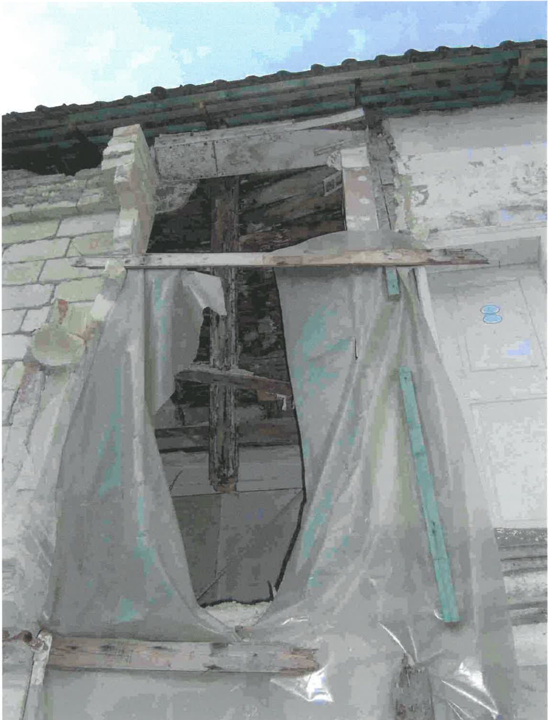
EINGESTÜRZTE DACHDECKE
