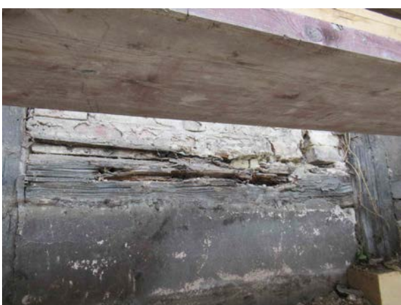
Fachwerkfassade Westgiebel Riegel zerstört
