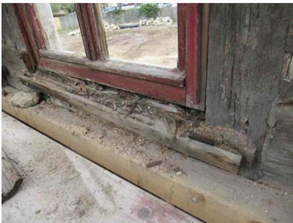
Fachwerkfassade Westgiebel Brüstung Fenster im OG Riegel zerstört
