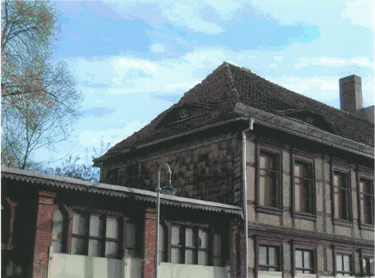
WESTGIEBEL HAUS 1.1 GIEBELBEKLEIDUNG DACHPFANNEN , GEFASST MIT SCHIEFER WALMDACH MIT FLEDERMAUSGAUBEN STRASSENFRONT HAUS 5.1
