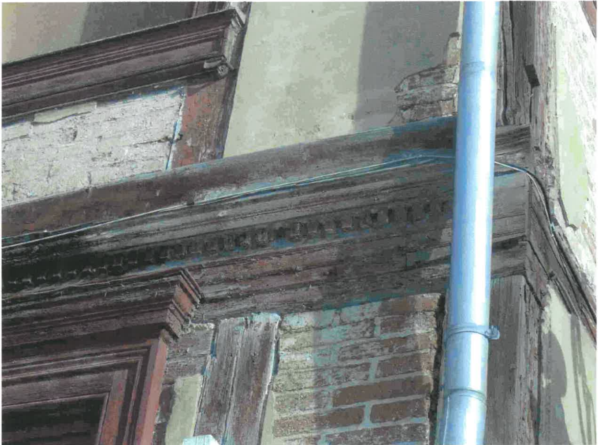
ECKE SÜDSEITE / OSTSEITE PROFILIERTES GURTGESIMS MIT ZAHNLEISTE
