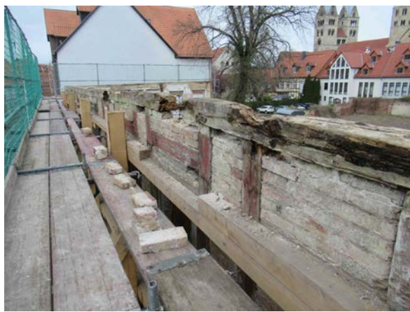
Fachwerkfassade Südseite, Rähm im Obergeschoss zerstört
