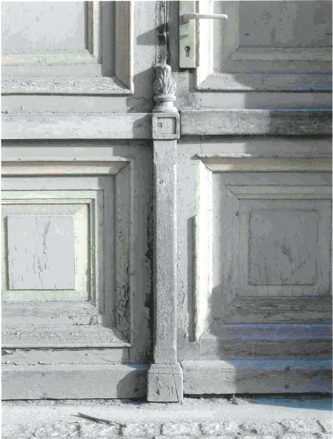
HAUSEINGANGSTÜR UNTERER QUERFRIES SCHLAGLEISTE FÜLLUNGEN
