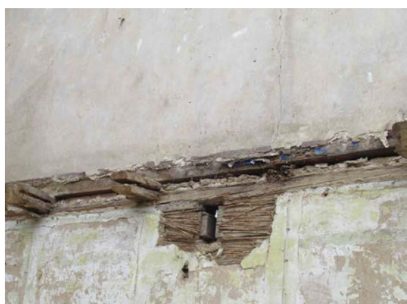
Fachwerkfassade Westgiebel Schwelle und Rähm zerstört Fachwerk flächig verputzt
