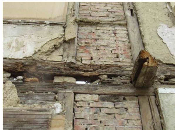
Fachwerkfassade Südseite, Fachwerkschäden beispielhaft
