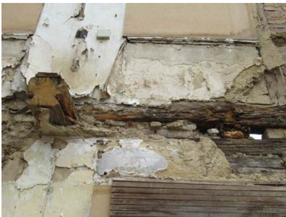
Fachwerkfassade Südseite, Fachwerkschäden beispielhaft
