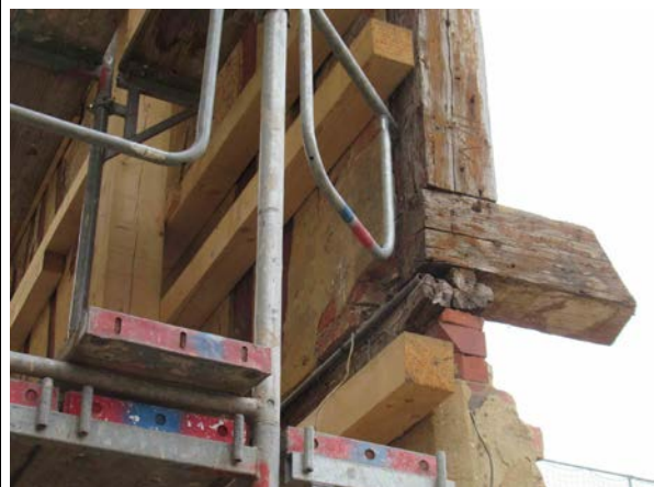
Fachwerkfassade Ostgiebel, Eckstiel und Schwelle zerstört
