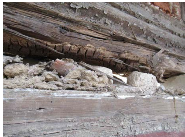
Fachwerkfassade Südseite, Fruchtkörper vom Hausporling an der Schwelle im Obergeschoss
