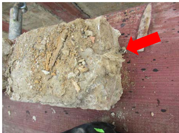
Fachwerkfassade Südseite, Teilbereich mit Befall Echter Hausschwamm, Myzel EH am Mauerwerk
