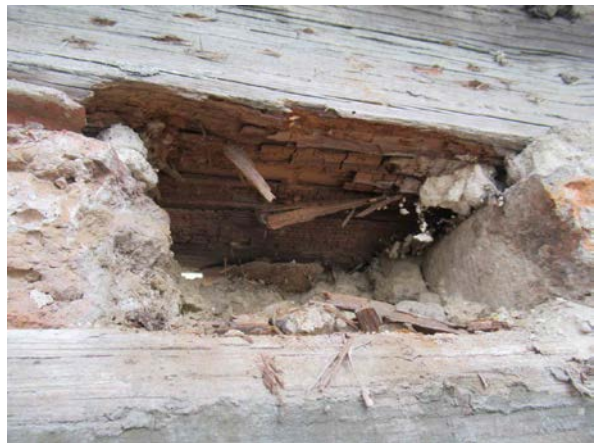
Fachwerkfassade Westgiebel Schwelle zerstört, beispielhaft
