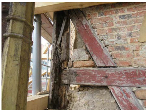
Fachwerkfassade Ostgiebel Eckstiel und Riegel zerstört
