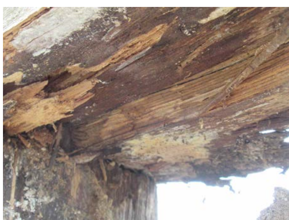
Fachwerkfassade Südseite, Rähm im Obergeschoss, Teilbereich durch Weißfäule zerstört, Fruchtkörper vom Hausporling
