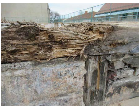
Fachwerkfassade Westgiebel, Rähm im Obergeschoss zur Weißfäule zerstört
