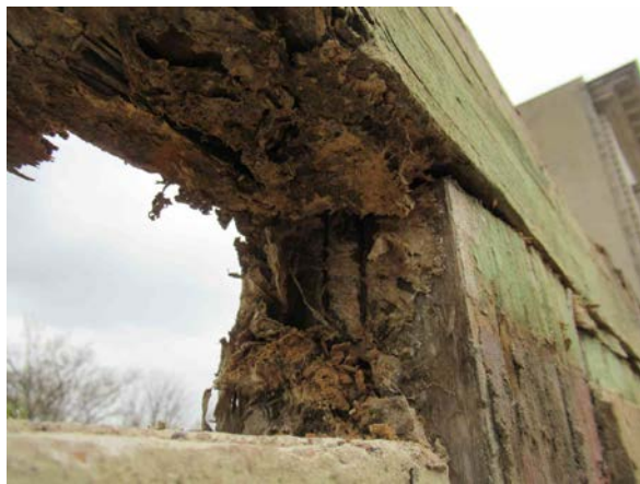
Fachwerkfassade Südseite, Teilbereich mit Befall Echter Hausschwamm, Rähm und Stiel zerstört
