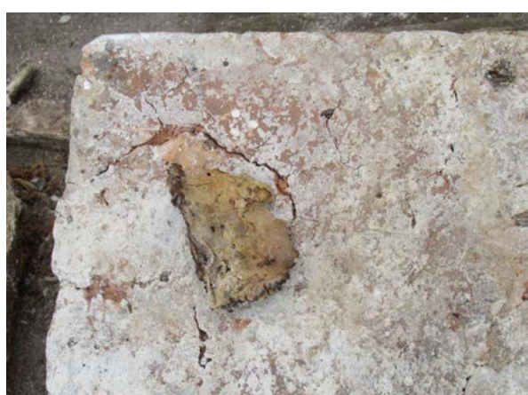
Fachwerkfassade Südseite, Rähm im Obergeschoss, Teilbereich durch Weißfäule zerstört, Fruchtkörper vom Hausporling
