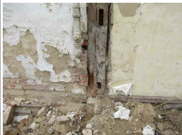
Fachwerkfassade Ostgiebel Stiel und Schwelle im Sockelbereich zerstört
