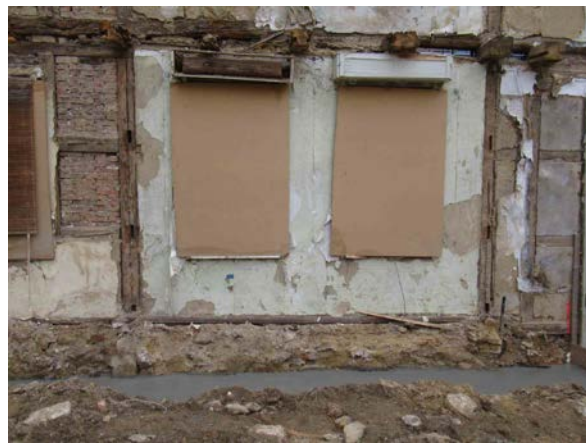
Fachwerkfassade Südseite, Fachwerkschwelle im EG nicht einsehbar bzw. mit Erdkontakt Fachwerk verputzt und nicht einsehbar
