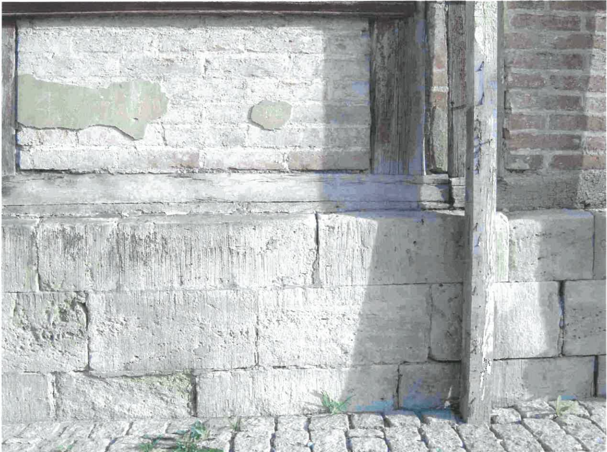
SANDSTEINSOCKEL SCHWELLE GEPUTZTE AUSFACHUNGEN
