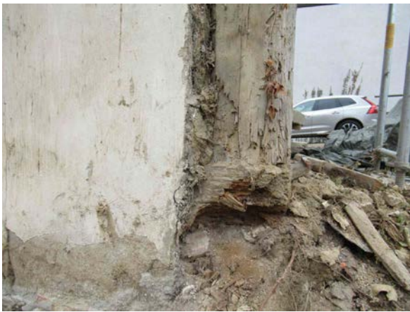
Fachwerkfassade Westgiebel Schwelle im EG zerstört, beispielhaft
