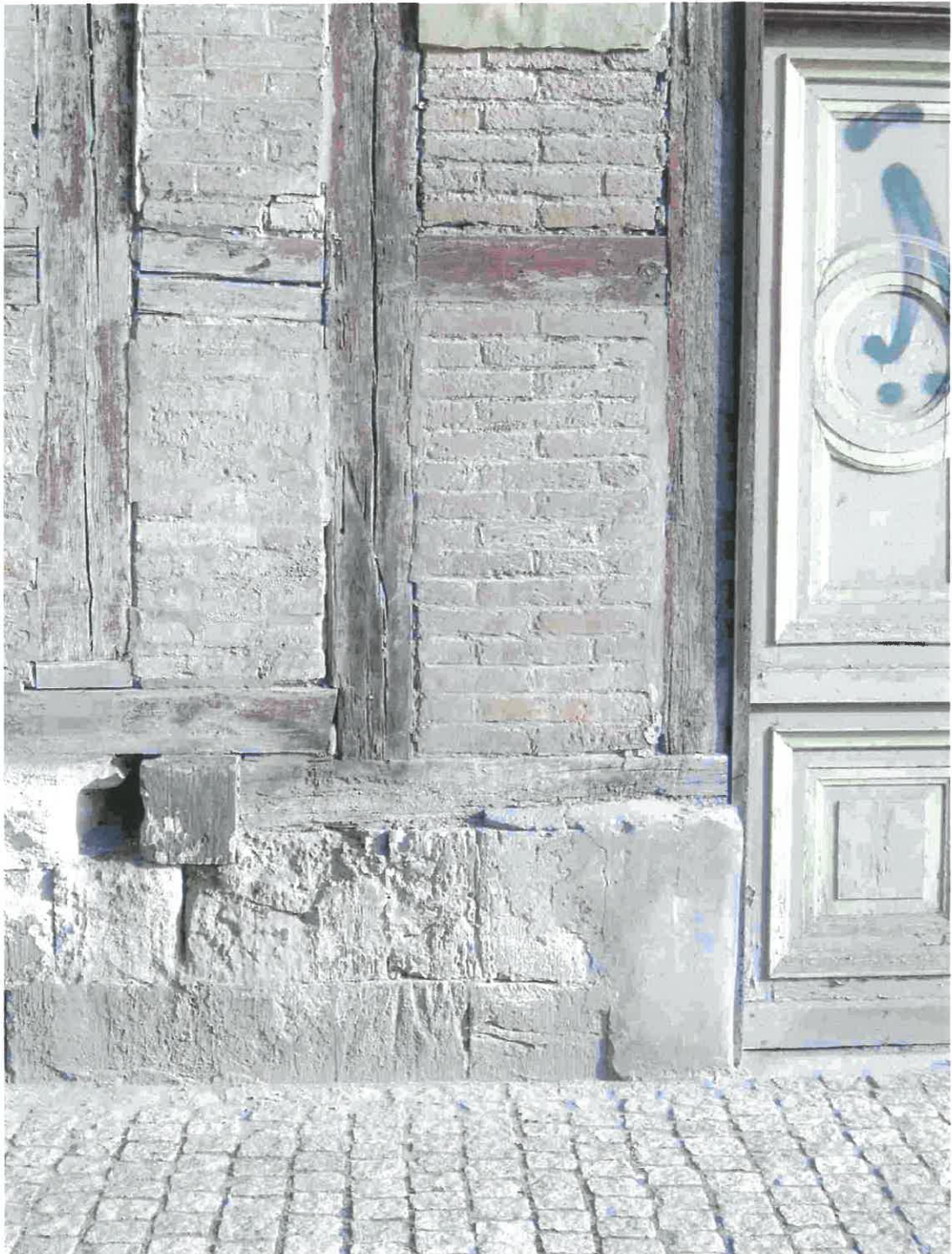
SANDSTEINSOCKEL IM EINGANGSBEREICH MIT ABGESETZTER SCHWELLE
