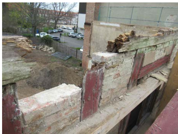
Fachwerkfassade Südseite, Rähm im Obergeschoss zerstört
