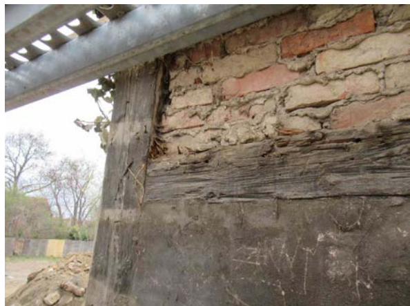
Fachwerkfassade Westgiebel Riegel und Eckstiel zerstört
