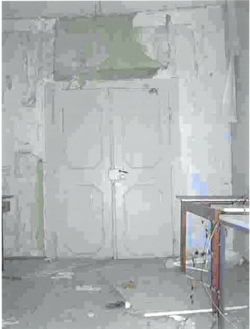
ZWEIFLÜGLIGE INNENTÜR ZUM HAUSFLUR ERDGESCHOSS FÜLLUNGSTÜR KASTENSCHLOSS STÜTZKLOBEN MIT SCHIPPENBÄNDERN
