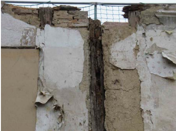
Fachwerkfassade Südseite, Fachwerkschäden im Obergeschoss, beispielhaft
