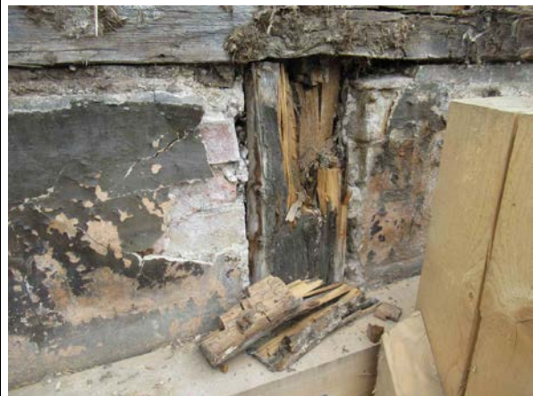
Fachwerkfassade Westgiebel, Rähm im Obergeschoss zerstört, Befall Echter Hausschwamm am Rähm und am Stiel
