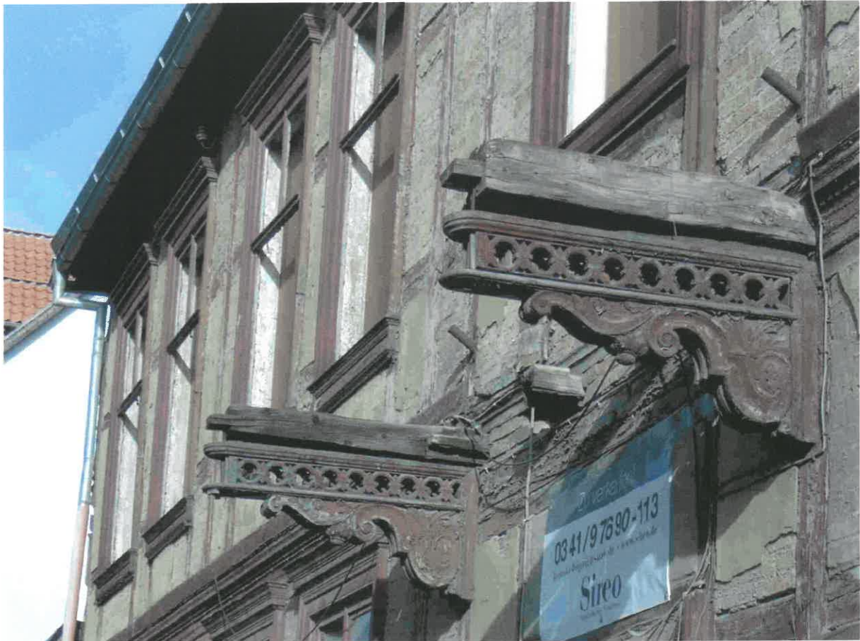
KONSOLEN UND AUSKRAGUNGEN DES EHEMALIGEN BALKONS
