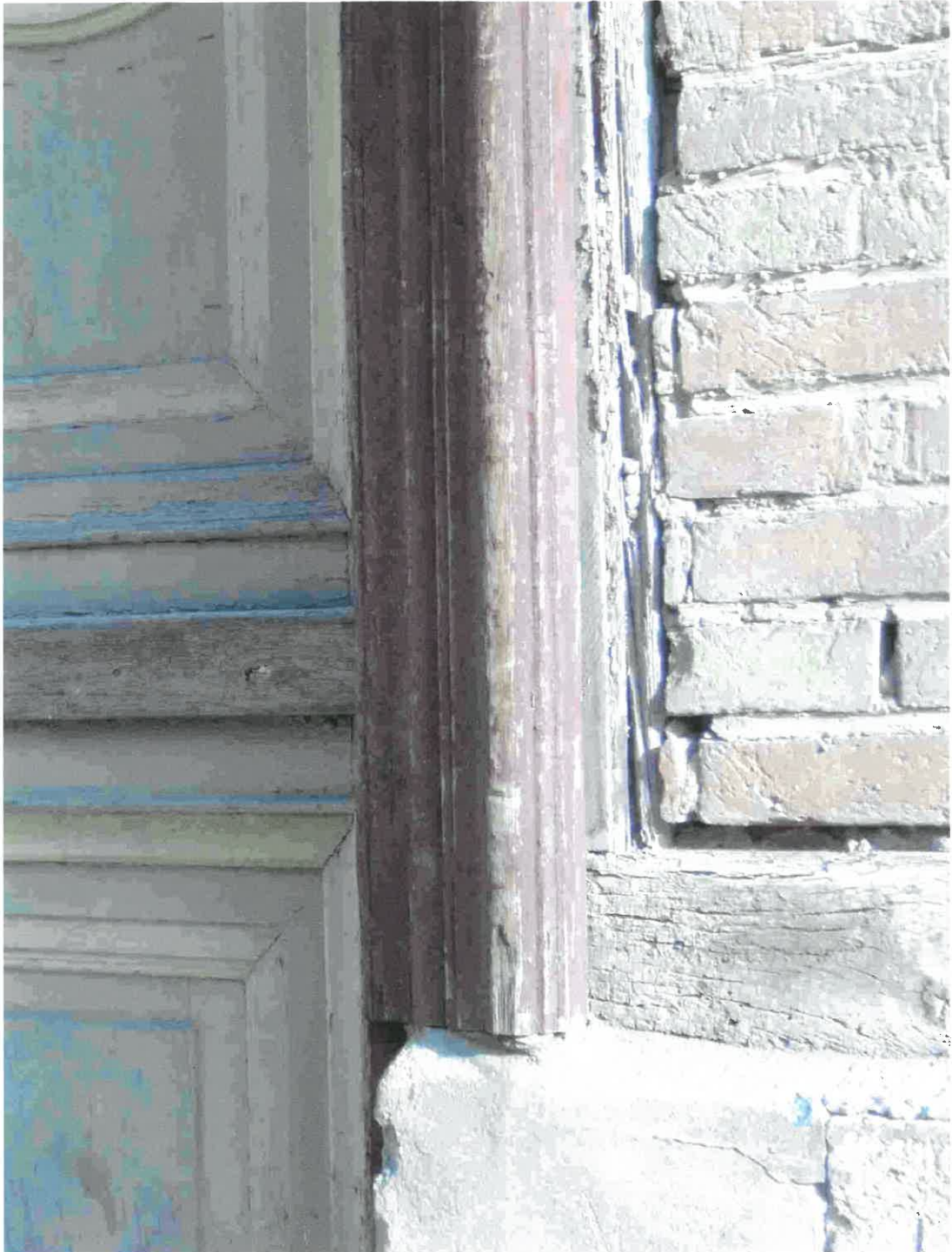
HAUSTÜRBEKLEIDUNG ENDET AUF SANDSTEINSOCKEL
