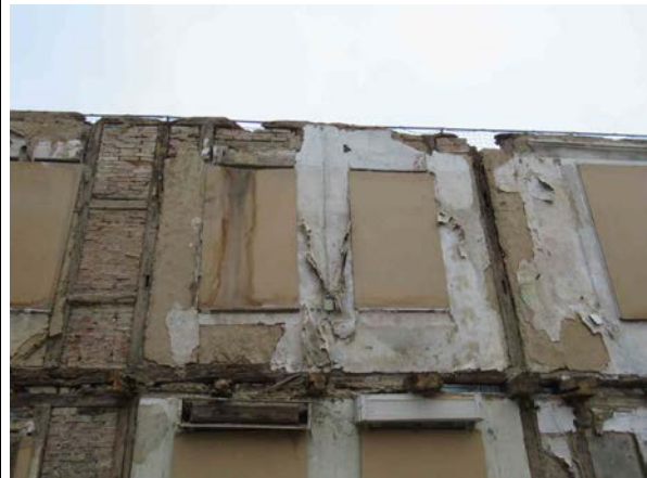
Fachwerkfassade Südseite, Schwelle und Rähm im Obergeschoss zerstört
