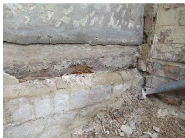
Fachwerkfassade Westgiebel Schwelle im Erdgeschoss unterseitig zerstört
