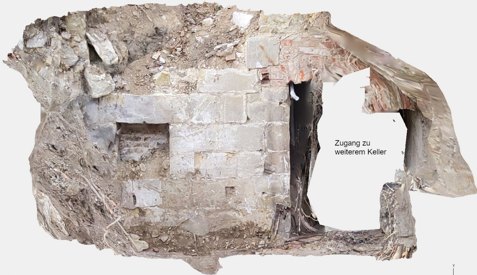
Kleiner Keller Nord: Westwand, Länge 3,95m, entzerrtes Fotogrammetriebild
