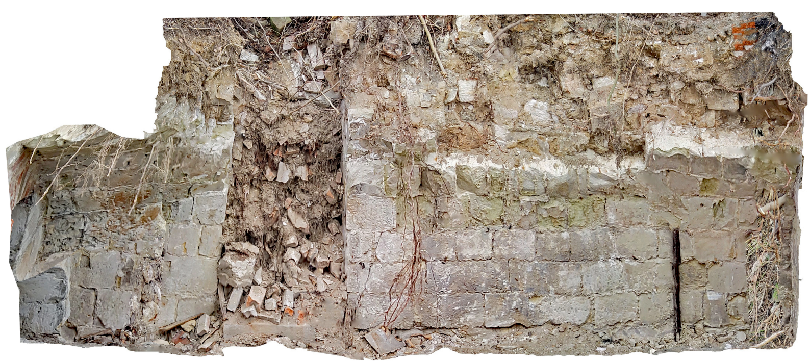
Kleiner Keller Nord: Nordwand mit verfülltem Kellerabgang, Länge 6,71m, entzerrtes Fotogrammetriebild
