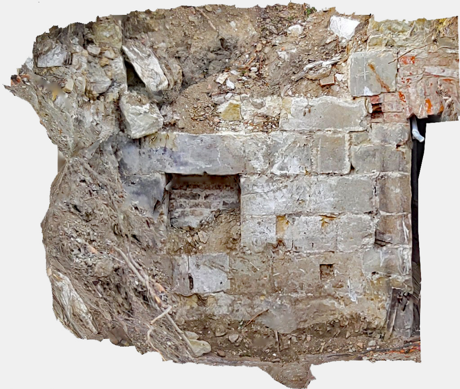
Kleiner Keller Nord: Westwand Detail Wandnische, Länge 2,56m, entzerrtes Fotogrammetriebild
