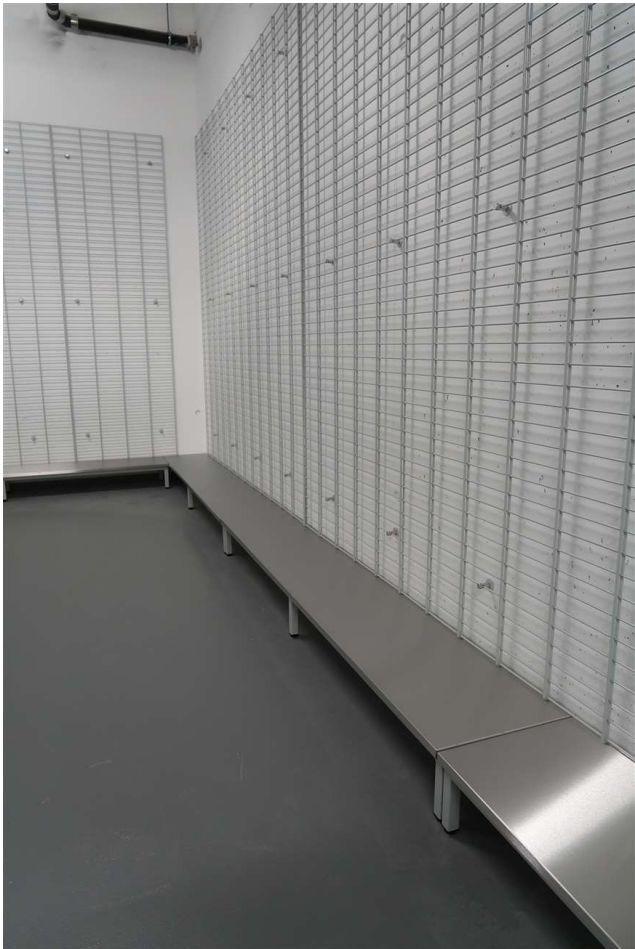
Foto 1: Ausführungsbeispiel einer Festgitterwand mit Sockel
