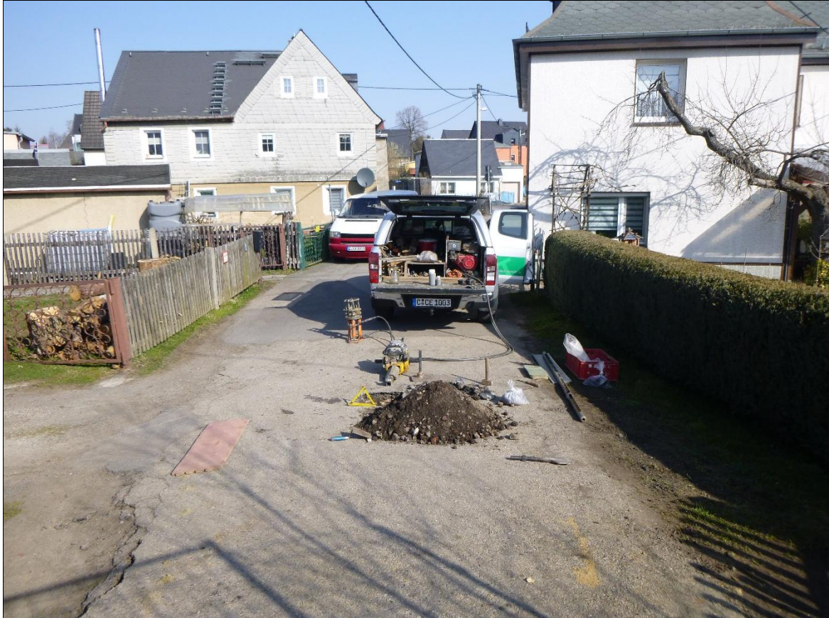
Aufbruch und Rammkernsondierung (A/RKS) 3 – Ansatzpunkt
