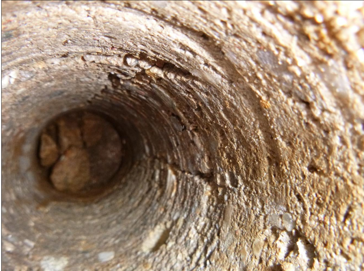
Diamantkernbohrungen (DKB) III – Innenansicht Bohrloch
