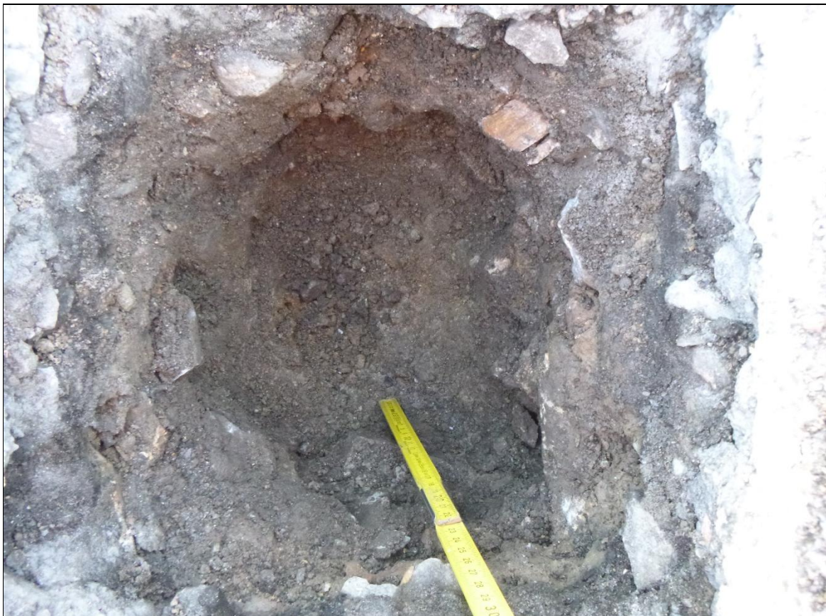
Aufbruch (A) 6 – Innenansicht Aufbruch
