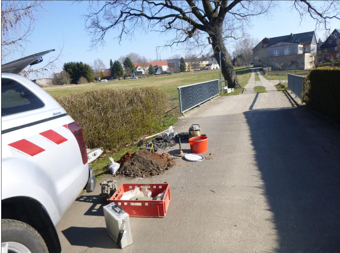
Aufbruch und Rammkernsondierung (A/RKS) 10 – Ansatzpunkt
