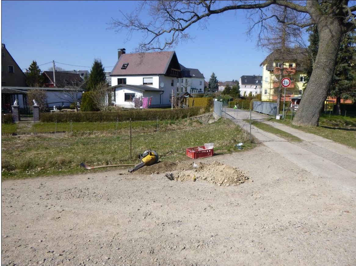
Aufbruch und Rammkernsondierung (A/RKS) 8 – Ansatzpunkt
