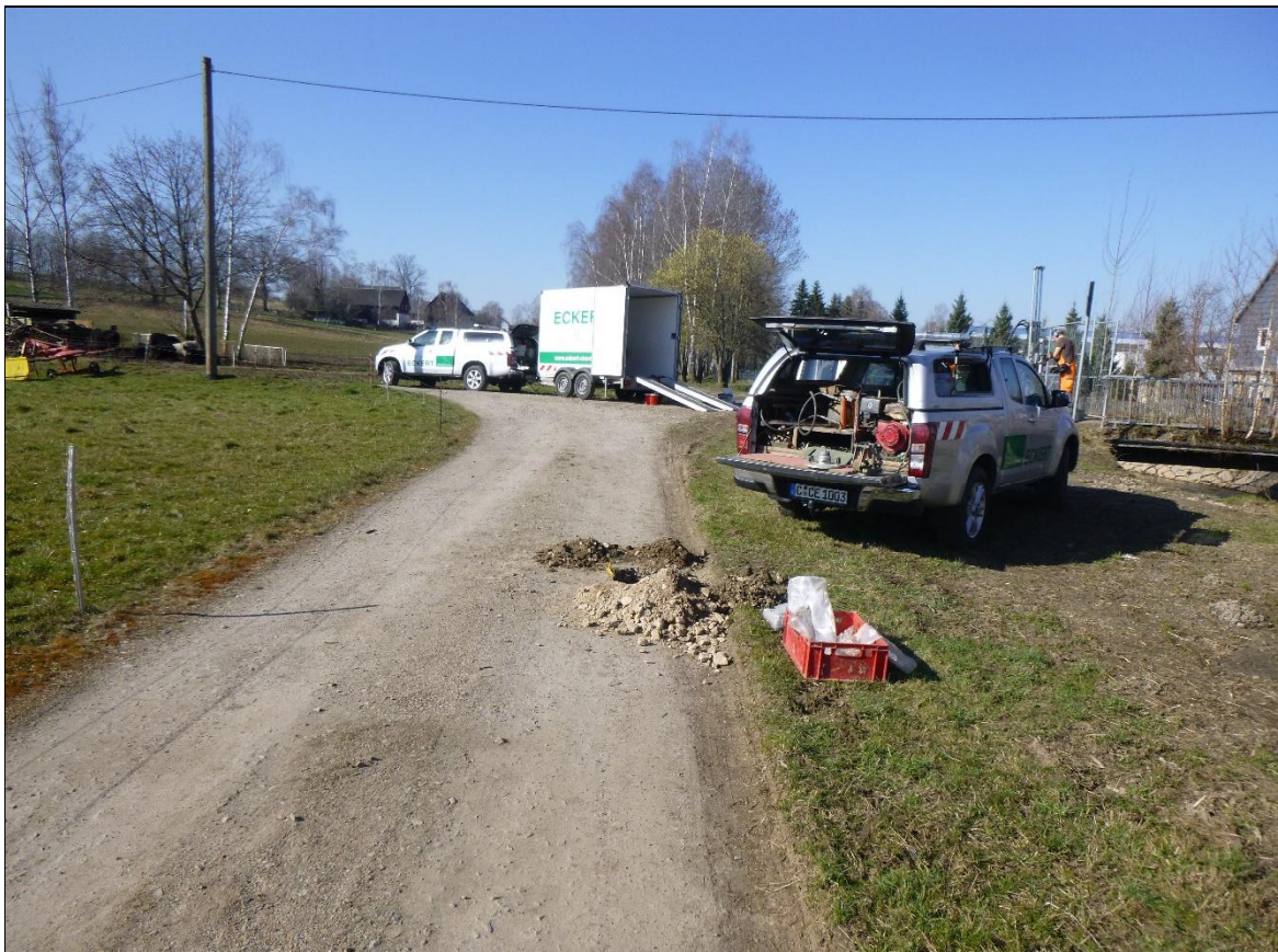
Aufbruch und Rammkernsondierung (A/RKS) 7 – Ansatzpunkt
