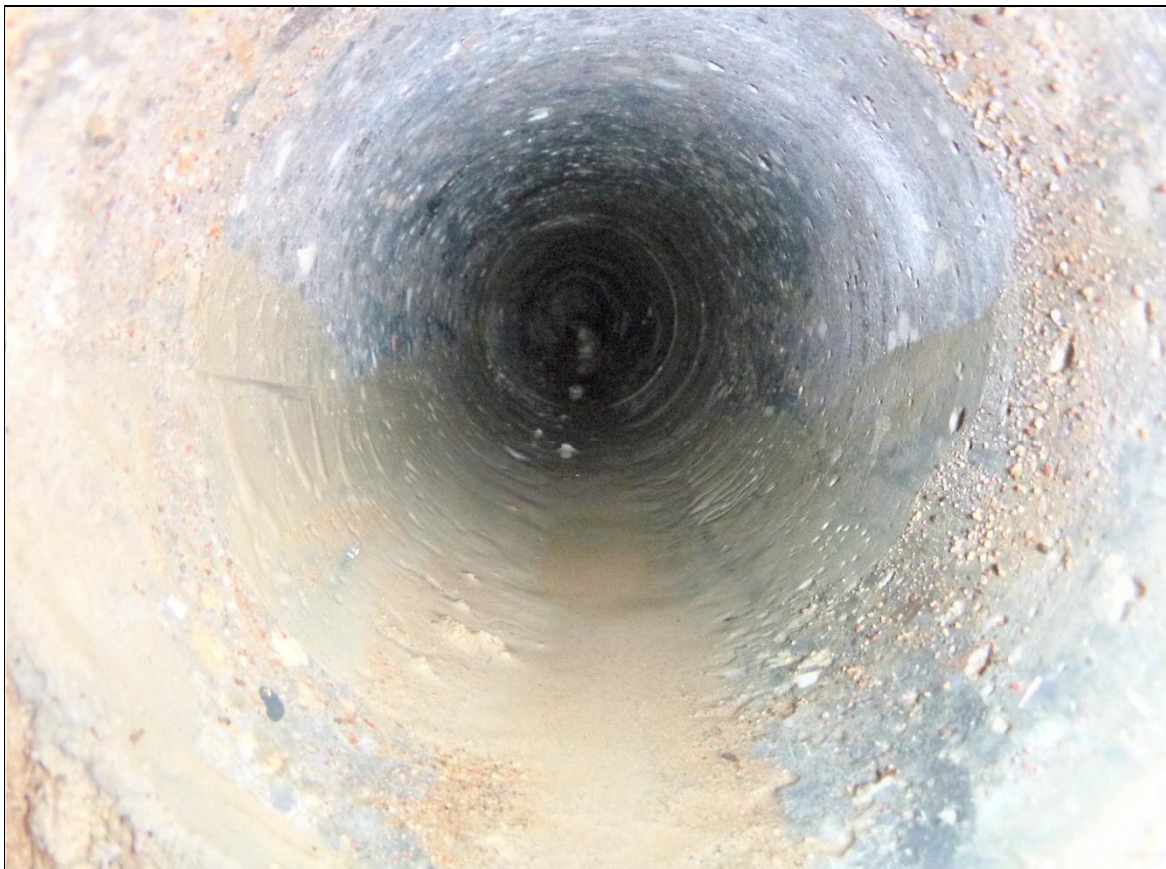
Diamantkernbohrungen (DKB) IV – Innenansicht Bohrloch
