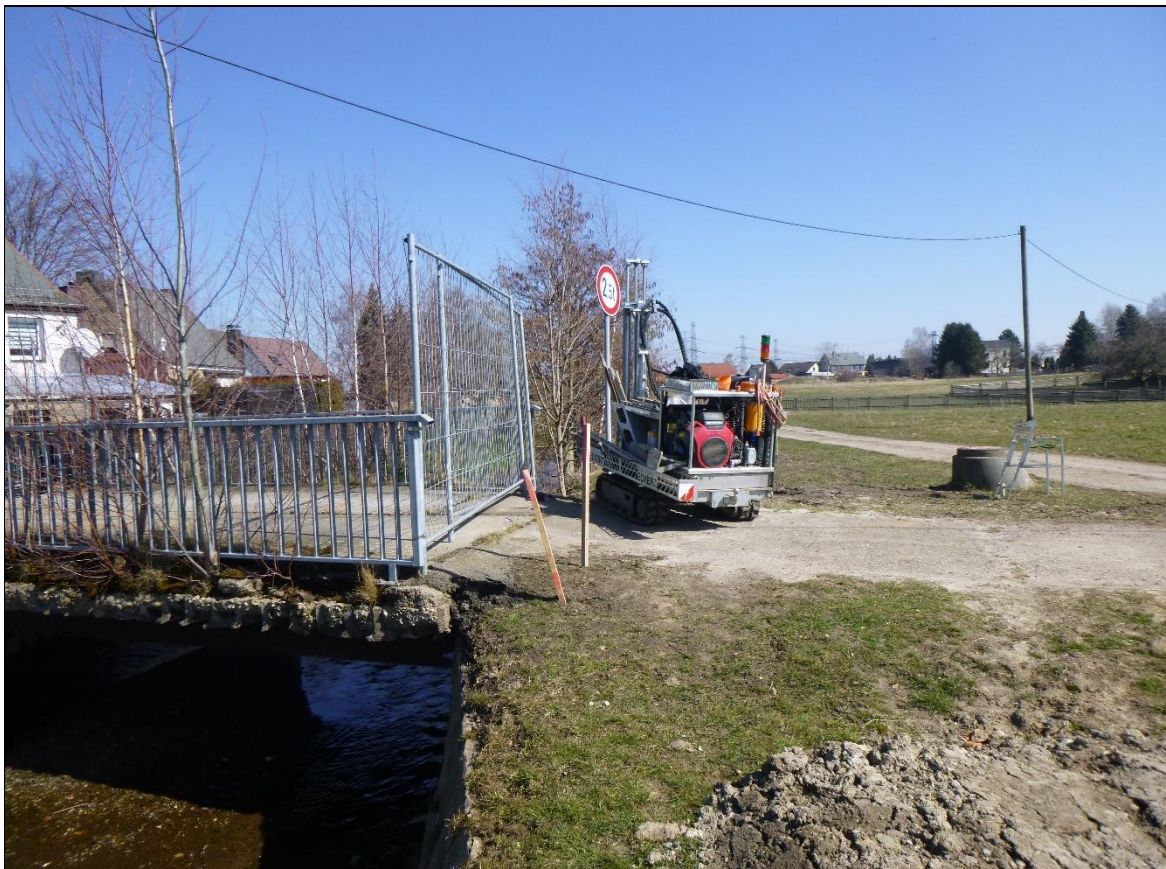
Schwere Rammsondierung + Rammkernsondierung (DPH + RKS) 2– Ansatzpunkte (v.l.n.r)
