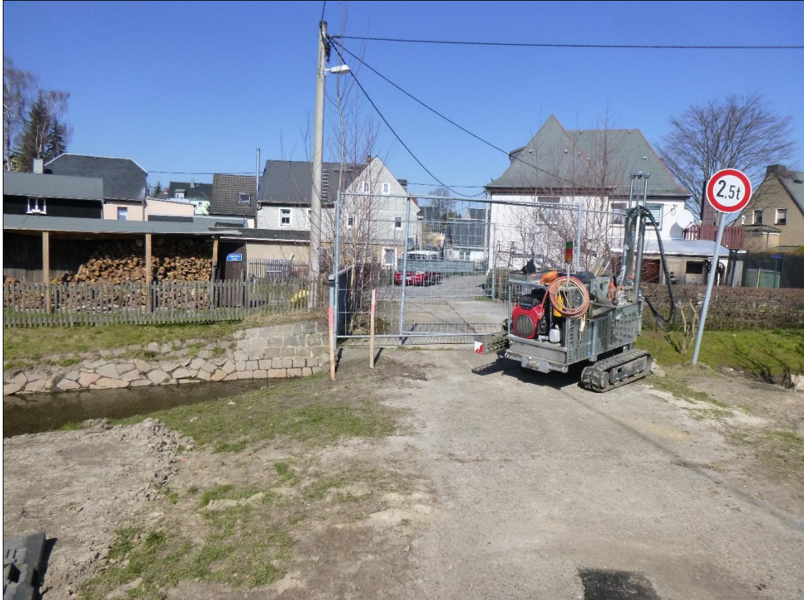
Schwere Rammsondierung + Rammkernsondierung (DPH + RKS) 2 – Ansatzpunkte (v.l.n.r)
