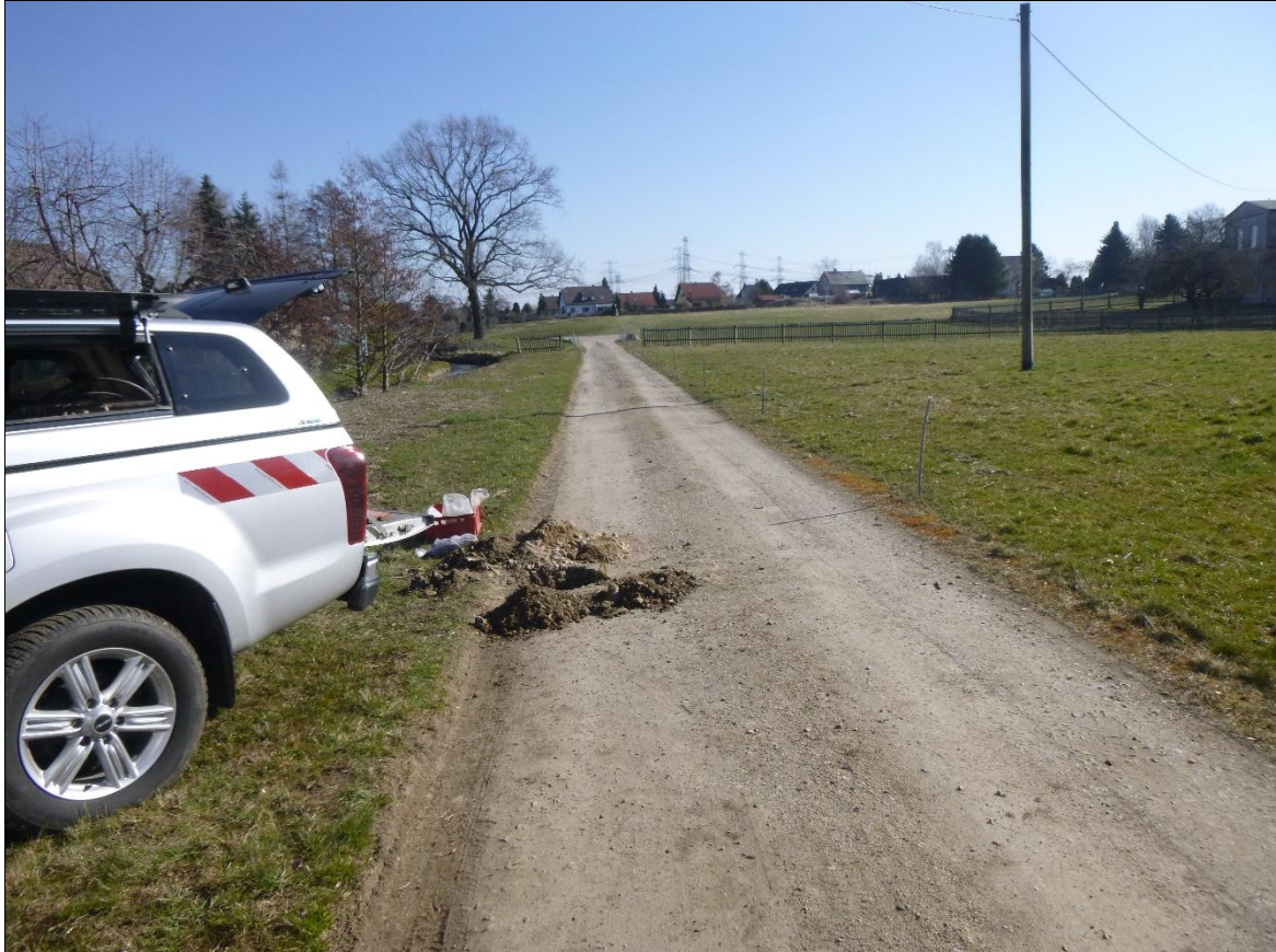
Aufbruch und Rammkernsondierung (A/RKS) 7 – Ansatzpunkt
