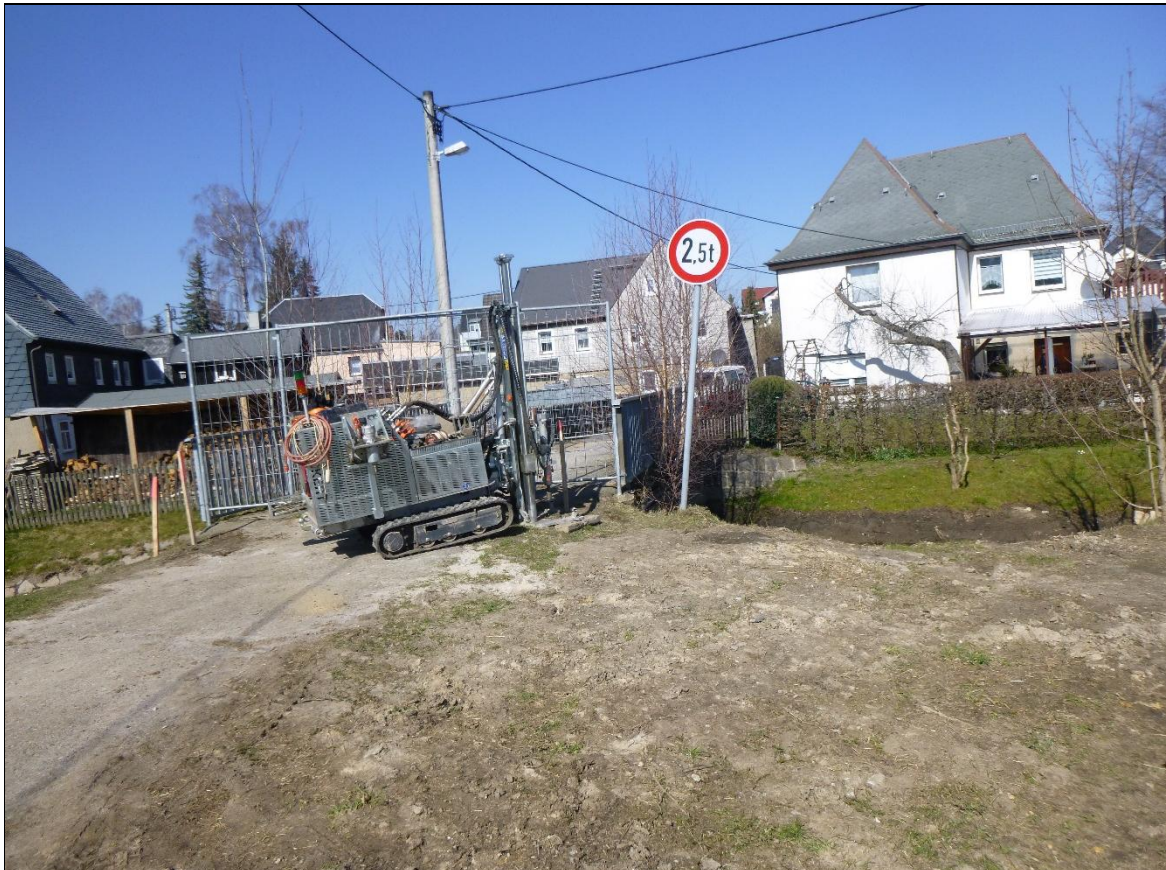
Rammkernsondierung (RKS) 5 – Ansatzpunkt
