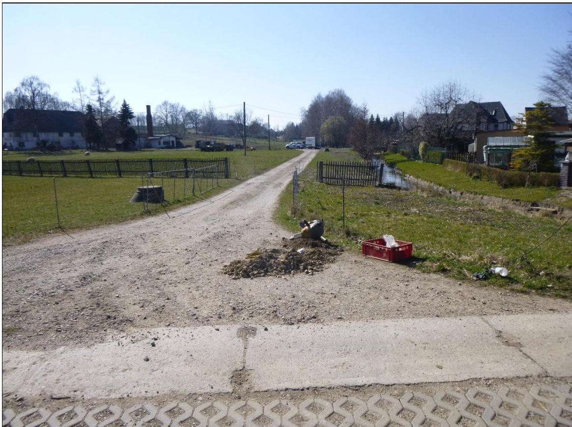
Aufbruch und Rammkernsondierung (A/RKS) 8 – Ansatzpunkt
