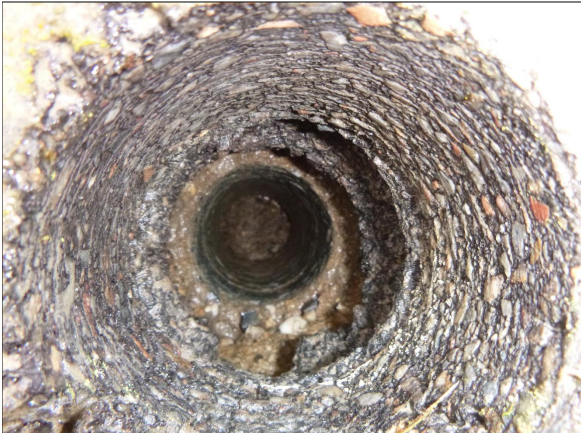
Diamantkernbohrungen (DKB) II – Innenansicht Bohrloch
