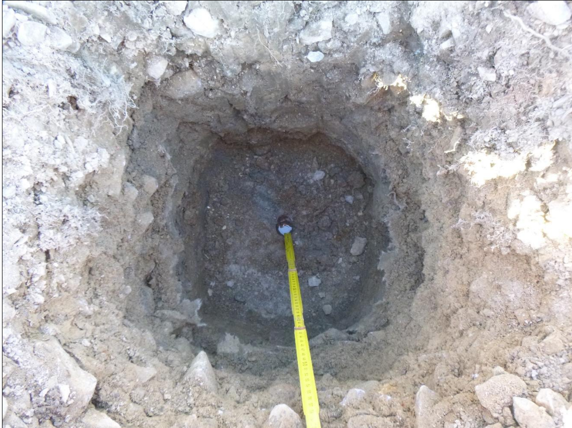
Aufbruch und Rammkernsondierung (A/RKS) 7 – Innenansicht Aufbruch
