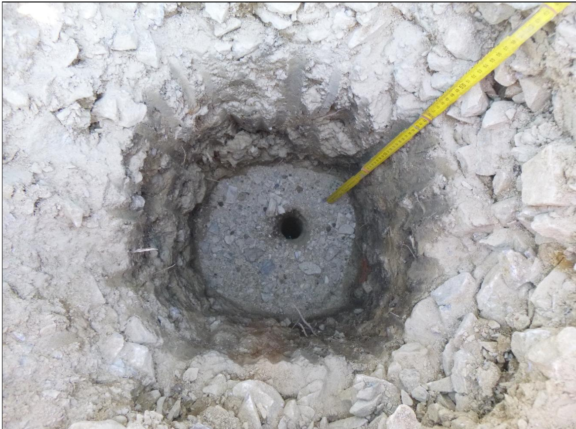
Aufbruch und Rammkernsondierung (A/RKS) 8 – Innenansicht Aufbruch
