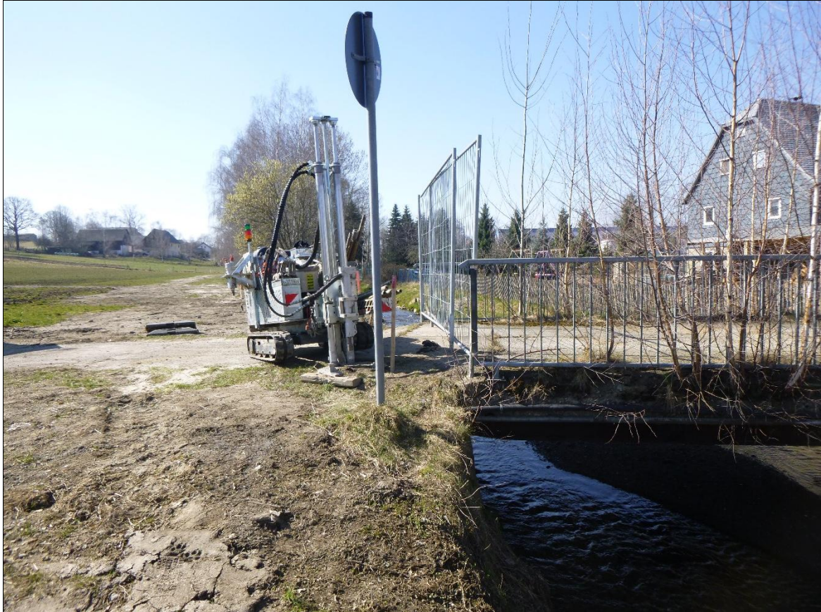
Rammkernsondierung (RKS) 5 – Ansatzpunkt
