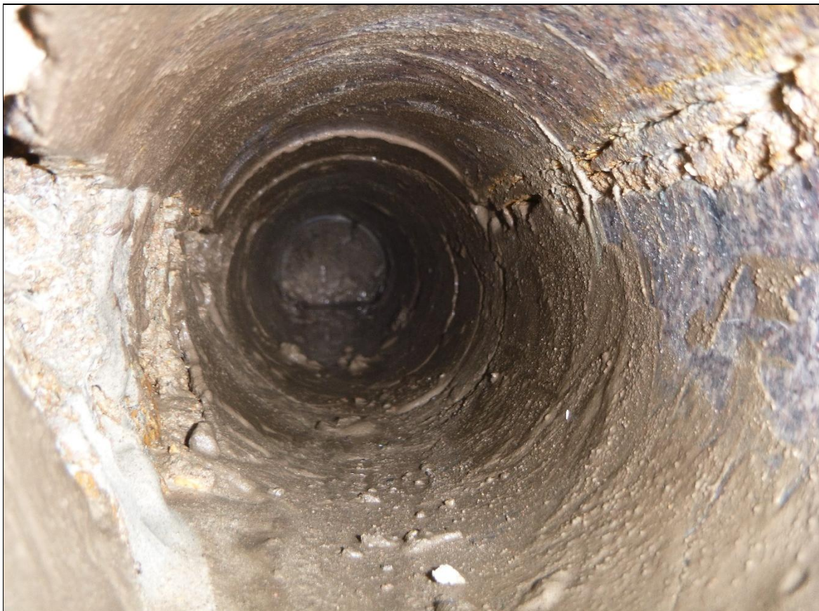
Diamantkernbohrungen (DKB) I – Innenansicht Bohrloch
