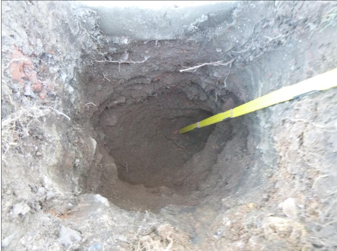
Aufbruch (A) 9 – Innenansicht Aufbruch
