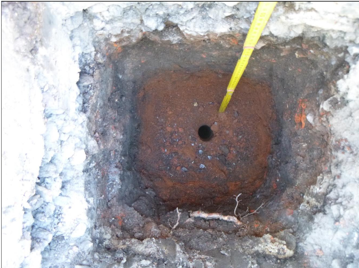
Aufbruch und Rammkernsondierung (A/RKS) 10 – Innenansicht Aufbruch
