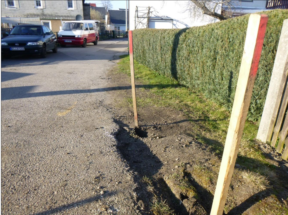
Schwere Rammsondierung + Rammkernsondierung (DPH + RKS) 1 – Ansatzpunkte (v.r.n.l)
