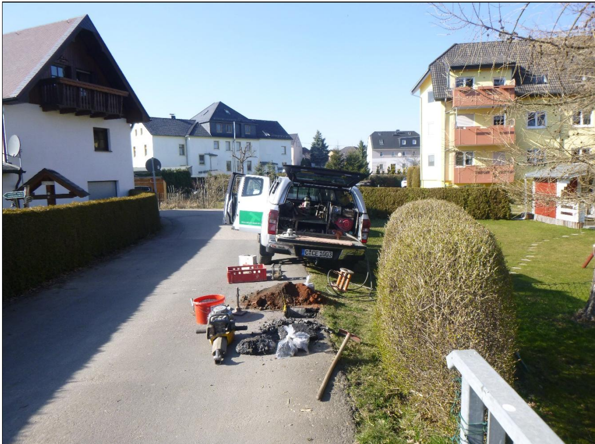
Aufbruch und Rammkernsondierung (A/RKS) 10 – Ansatzpunkt
