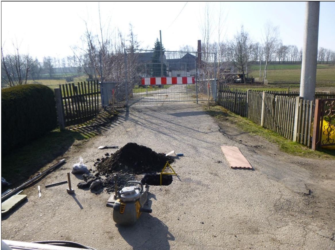
Aufbruch und Rammkernsondierung (A/RKS) 3 – Ansatzpunkt
