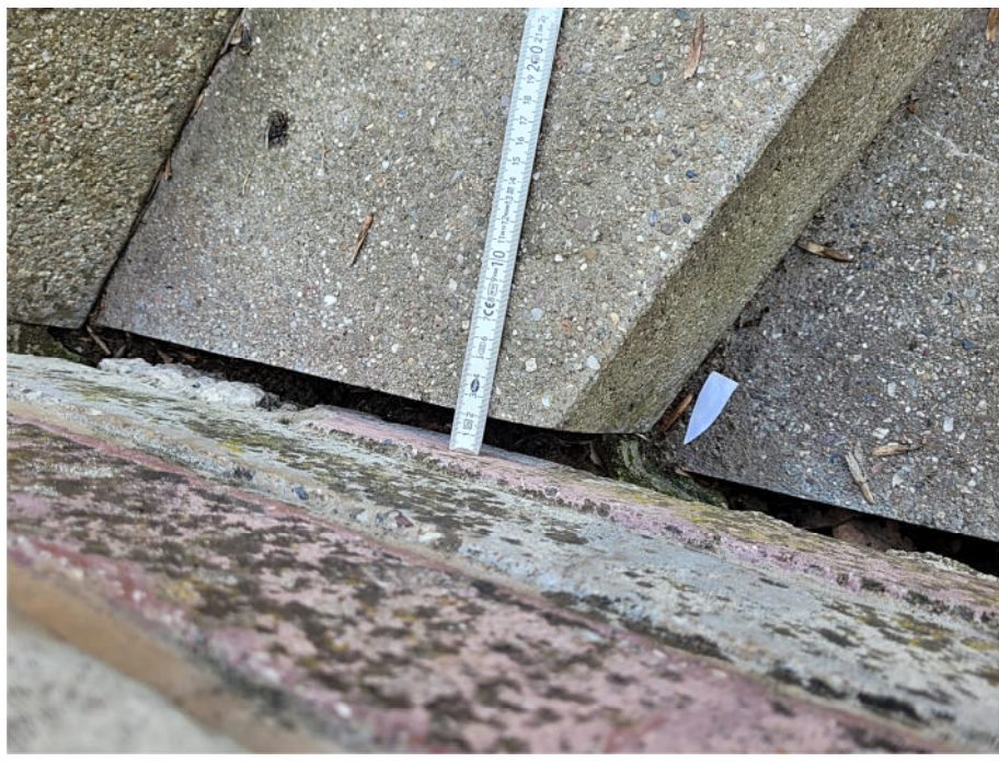
Treppenanlage Nord unterhalb der Aula - Fugenverschluss wiederherstellen
