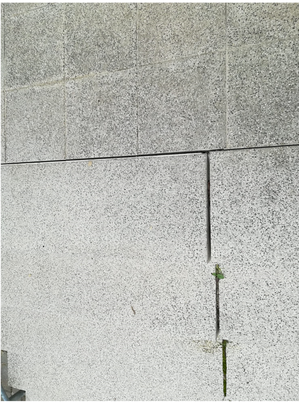
Treppe Seiteneingang Hauptgebäude - Fugenverschluss herstellen
