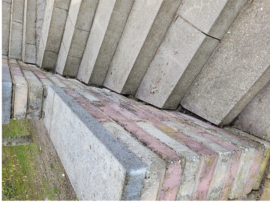
Treppenanlage Nord unterhalb der Aula - Fugenverschluss wiederherstellen
