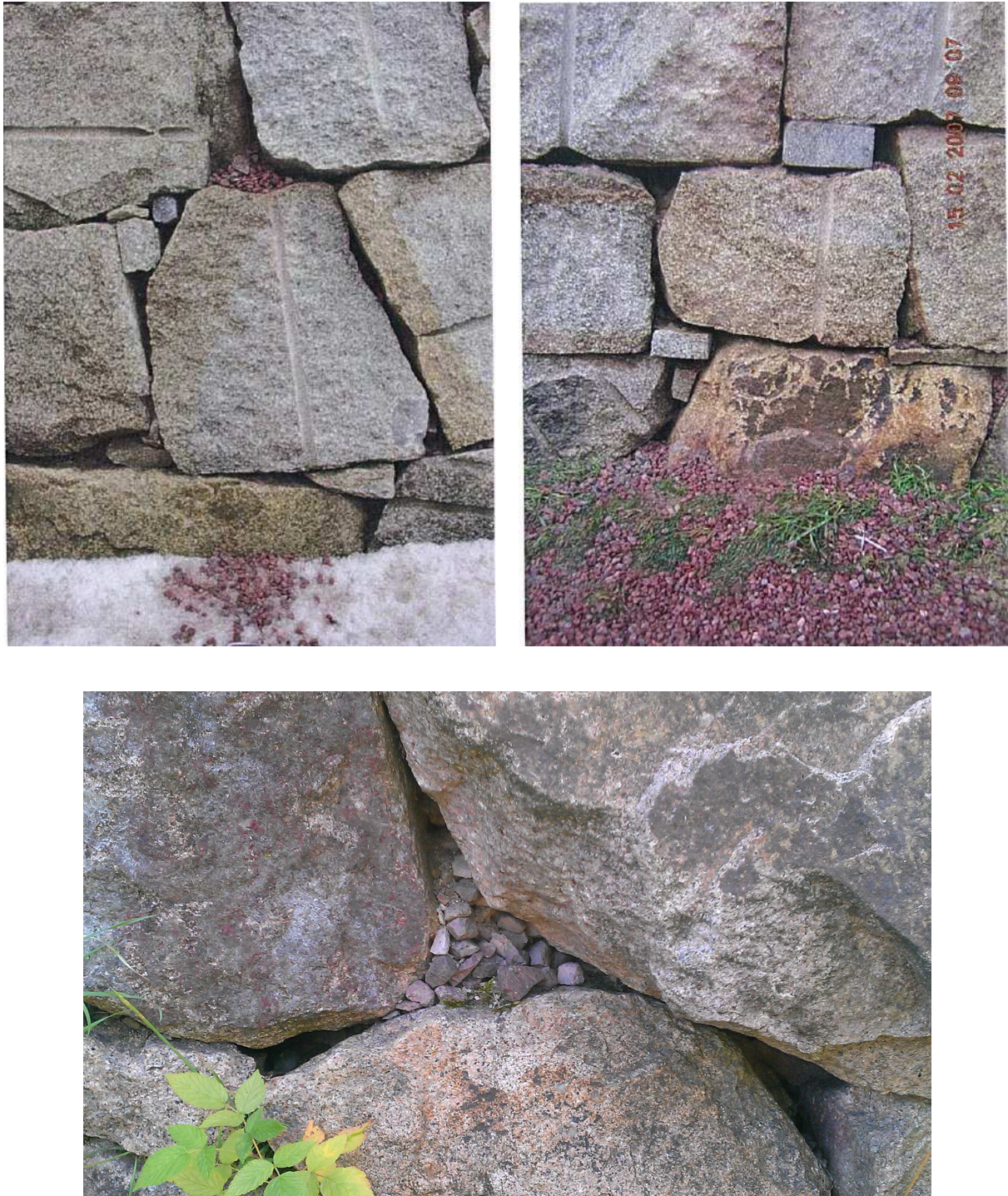
Abbildung 61: Heraustretende Hinterfüllung
