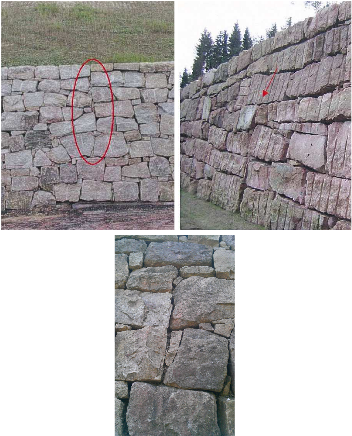
Abbildung 66: Durchgehende Stoßfuge
