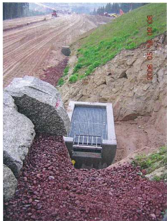
Abbildung 20: Sandfang mit Anschluss an die Fahrbahntwässerung nach [8]
