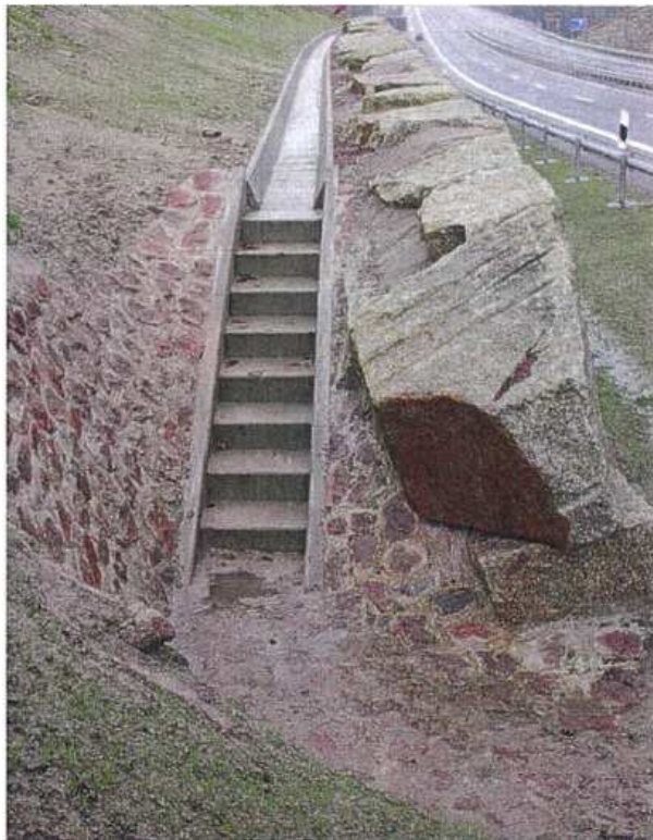
Abbildung 17: Entwässerung über Kaskaden in Mulde nach [8]
