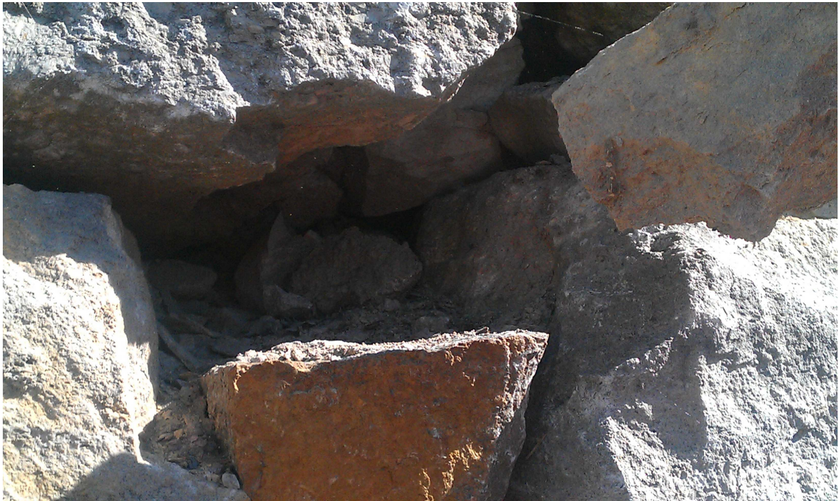
Abbildung 27: Fehlerhafter Einsatz von Zwickelsteinen - lose Zwickelsteine
