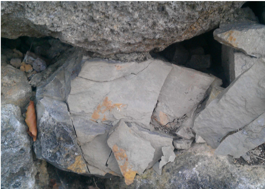
Abbildung 28: schadhafte Zwickelsteine
