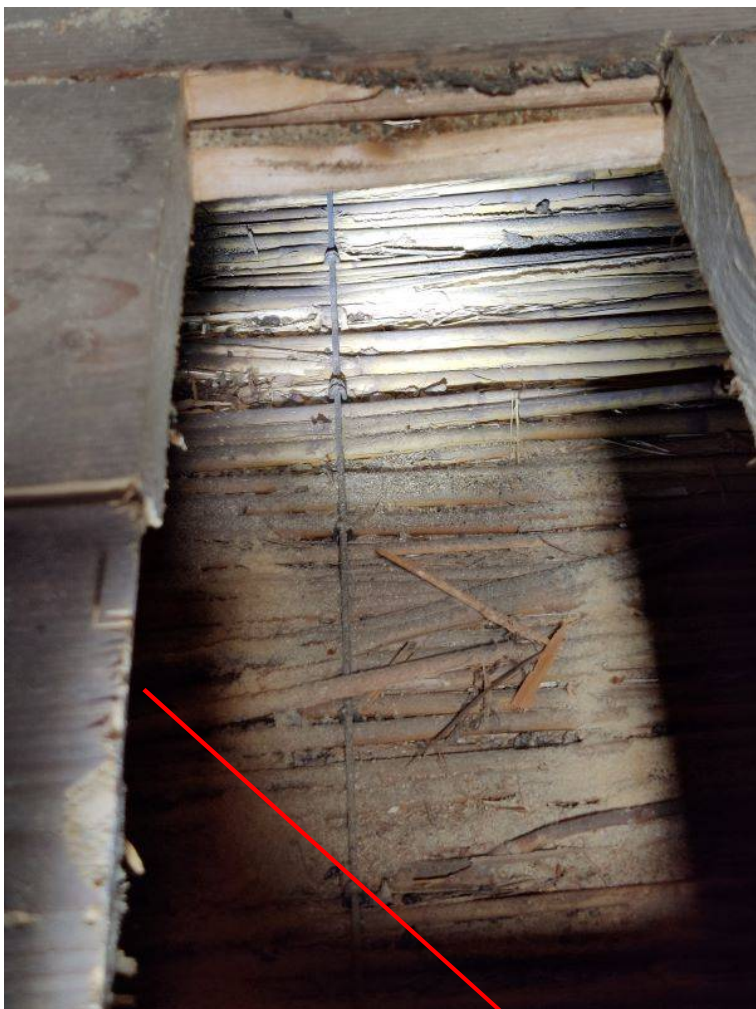
Bodenansicht, Strohputzdecke über dem 1. Obergeschoss
