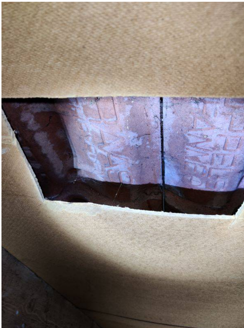
Dachverkleidung: organische Faserplatte
