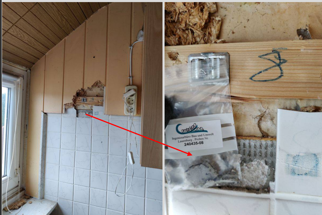
Bild 4+5: Küche, asbesthaltiger Dünnbettmörtel
