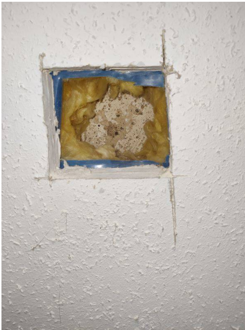
Mineralwolle hinter Vorsatzschale Außenwand
