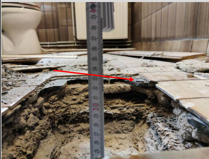
Bild 12: Bad, 1. Obergeschoss: Bodenaufbau mit asbesthaltigem Dünnbettmörtel
