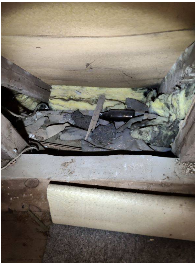
Mineralwollgedämmung ab Decke über dem 1. Obergeschoss
