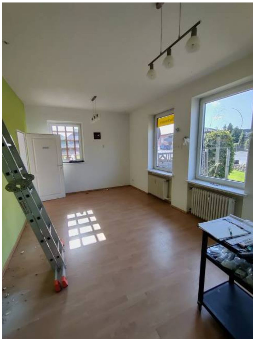
Ansicht Raum 1 EG, Gliederradiatoren mit asbesthaltigen Dichtungen zwischen den Gliedern
