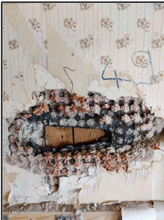
Bild 1: Küche, PAK-haltige Feuchteschutzpappe Dachständerwerk
