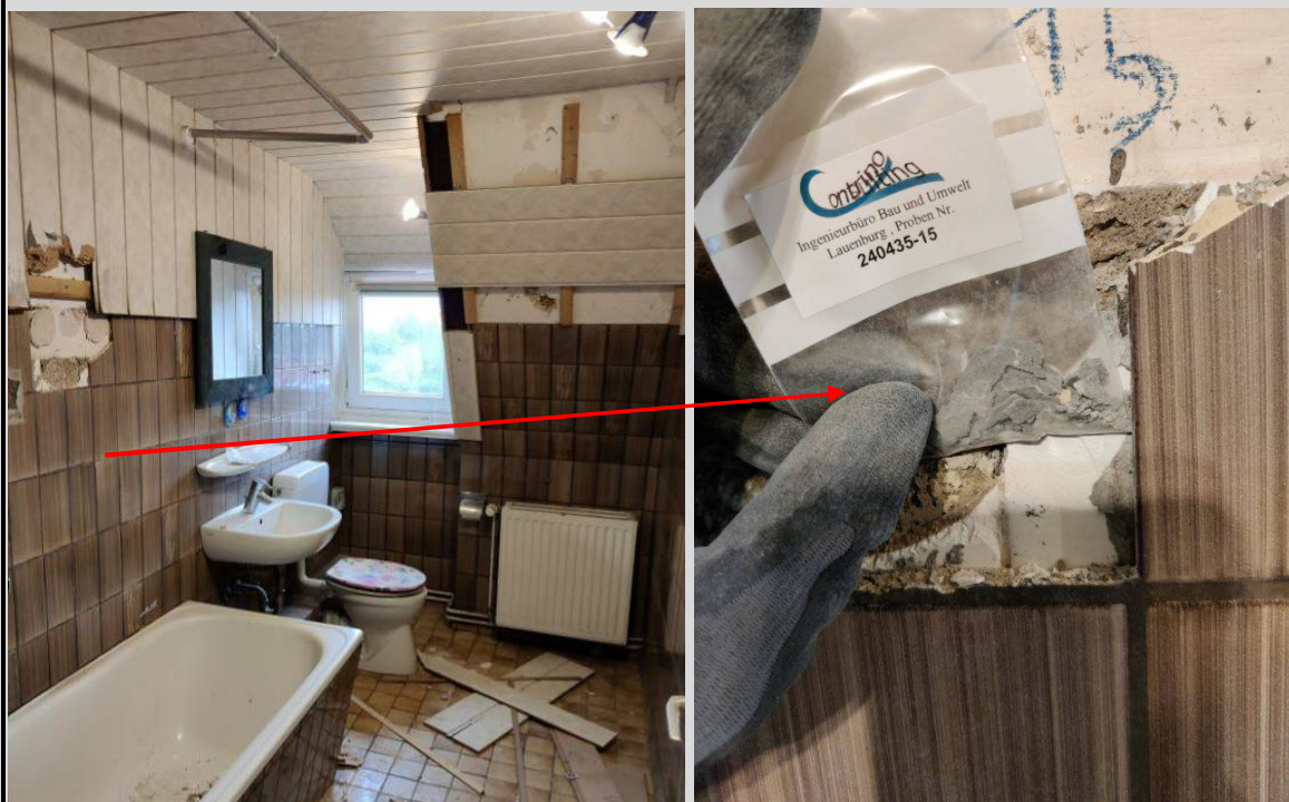
Bild 2+3: Bad, Wandfliesen mit asbesthaltigem Dünnbettmörtel
