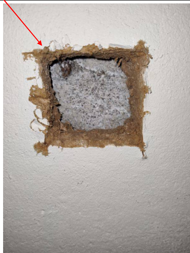
Organische Faserplatte verklebt auf Betondecke
