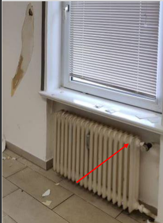
Bild 13: Gliederradiator mit Asbestdichtung
