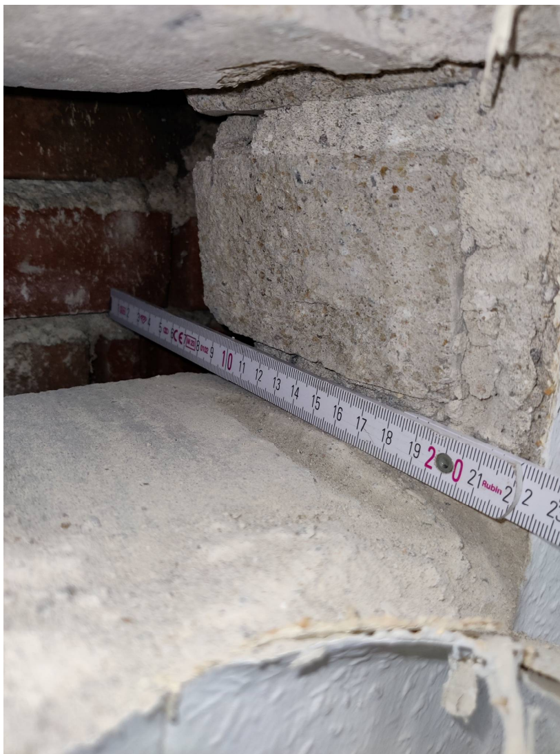
Erdgeschoss, Außenwandaufbau: Kalksandstein, Luft, Ziegelstein
