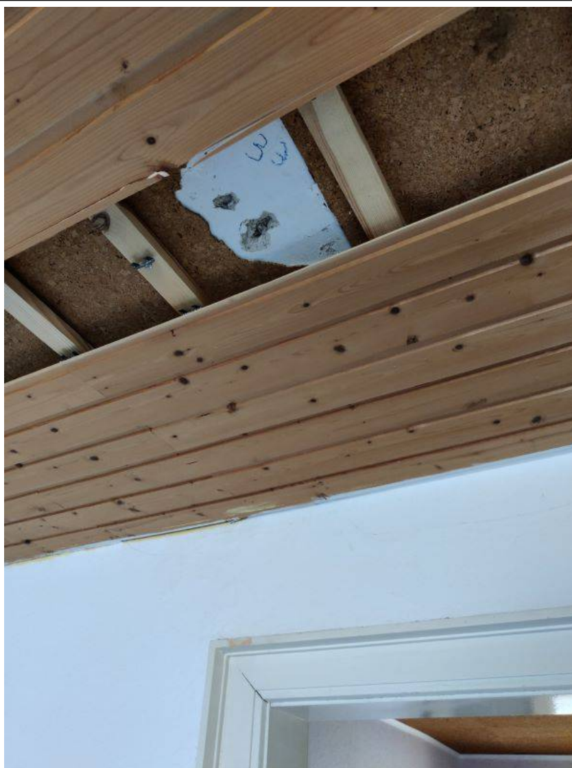
Raum 3, Nut- und Federbretter, Korkverkleidung verklebt auf Deckenputz
