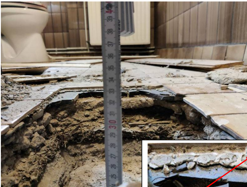
Bad, Bodenaufbau
