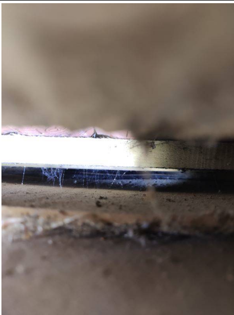
Blick hinter Dachverkleidung, keine Mineralwolle im Dachboden erkennbar
