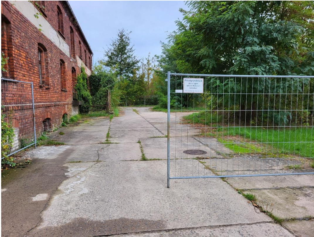
Bild 6: Einfahrt Bituplast-Gelände mit Bauzaun, Blickrichtung Südwest
