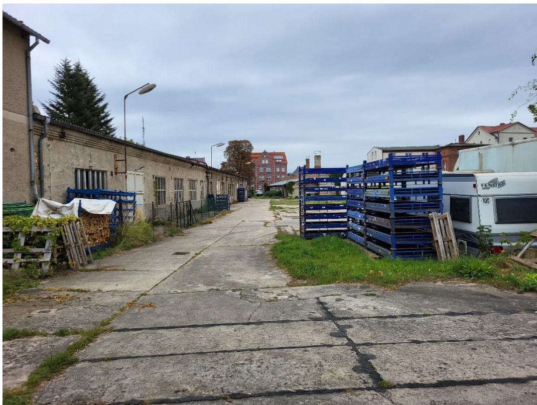
Bild 12: Betonplattenweg innerhalb Bituplast-Gelände Foto 4, Blickrichtung Ost
