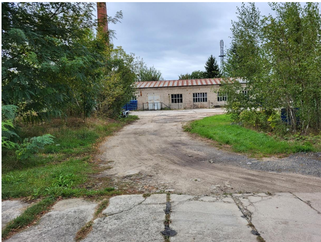
Bild 8: Zufahrt Garagen innerhalb Bituplast-Gelände, Blickrichtung Norden
