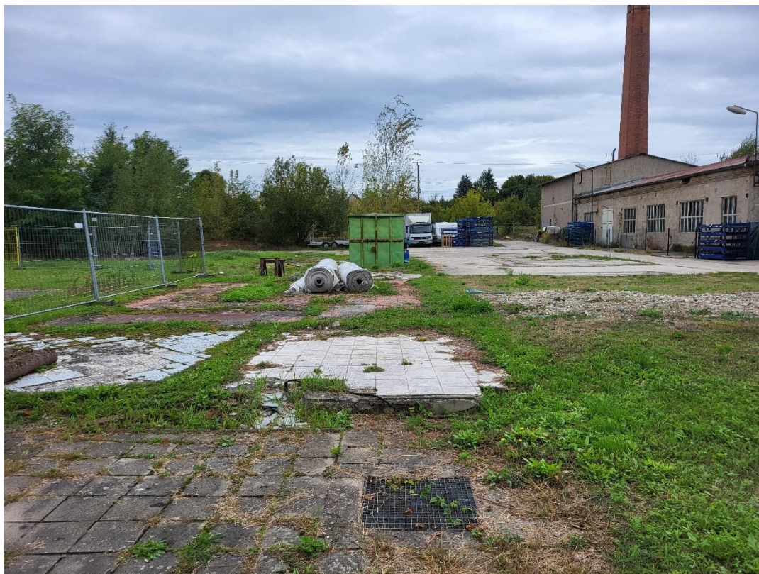
Bild 14: Gebäudereste innerhalb Bituplast-Gelände, Blickrichtung Südwest
