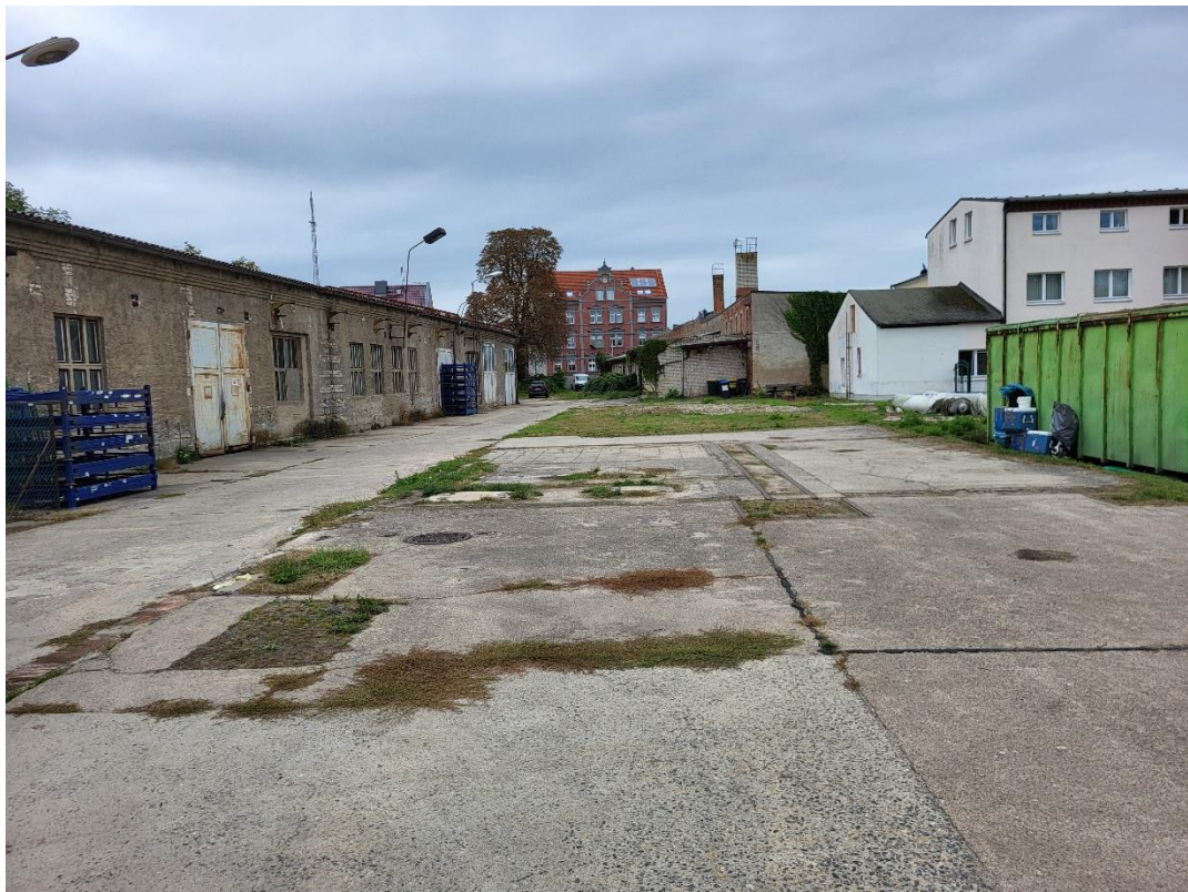
Bild 13: Betonplattenweg innerhalb Bituplast-Gelände Foto 5, Blickrichtung Ost
