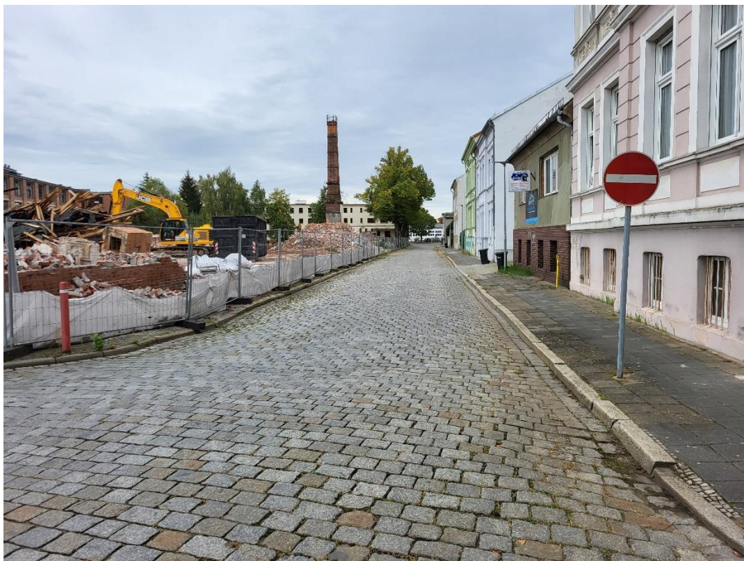
Bild 3: Kreuzung Feldstraße und Straupitzstraße, Blickrichtung nach Südost entlang der Feldstraße
