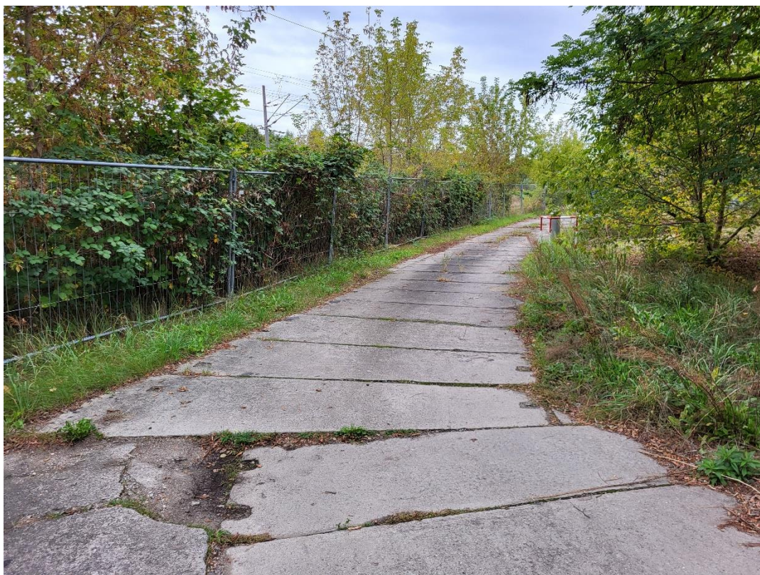
Bild 9: Betonplattenweg innerhalb Bituplast-Gelände Foto 1, Blickrichtung Nordwest
