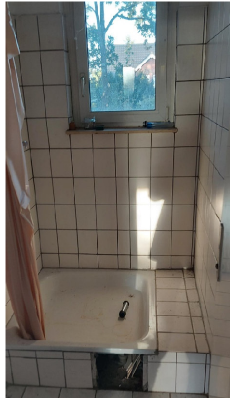
16. Lichtbild: Innenansicht DU, Haus 3 A, im Obergeschoss.
