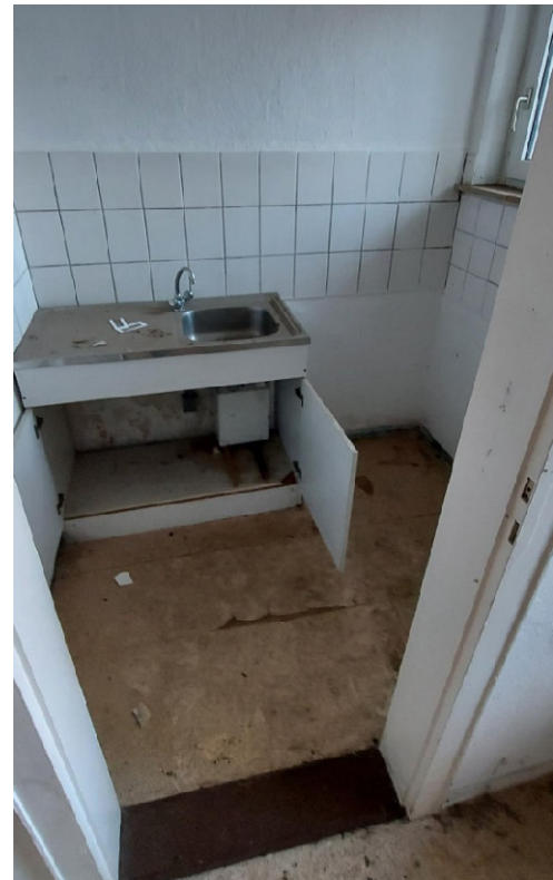
24. Lichtbild: Innenansicht Küche, im Obergeschoss, Haus 4
