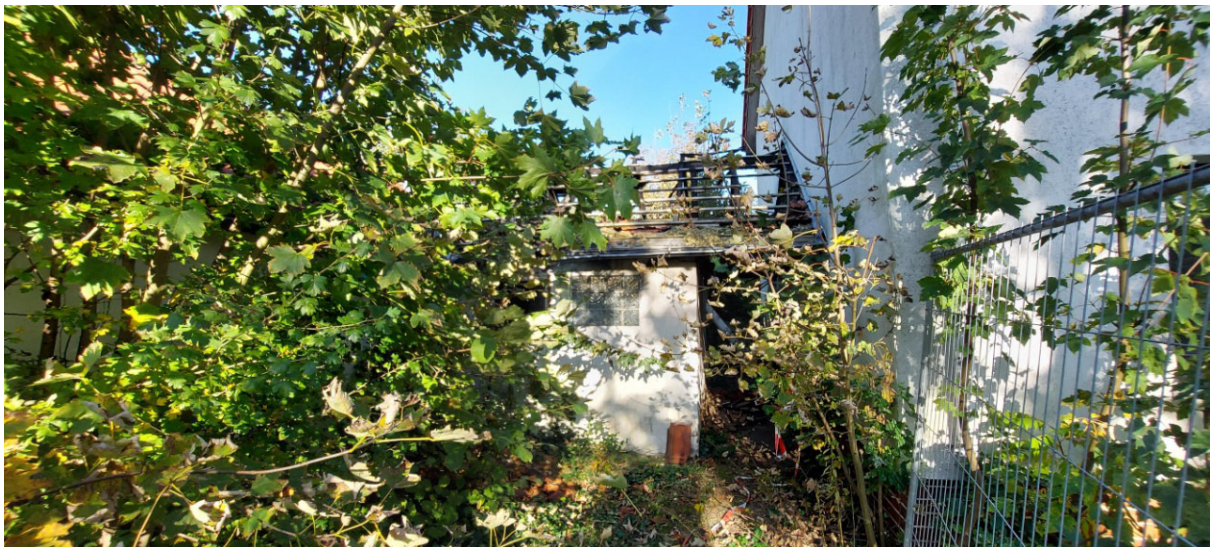
4. Lichtbild: Hofseitige Traufansicht des Nebengebäudes 1, angrenzend an das Wohnhaus.
