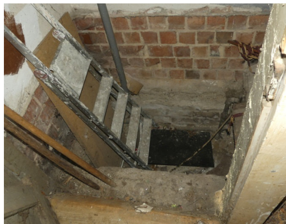
30. Lichtbild Teilunterkellerung im Treppenhaus, Haus 4.
