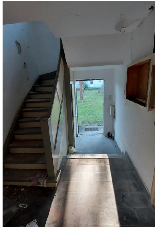
20. Lichtbild: Innenansicht Treppenhaus, Haus 3
