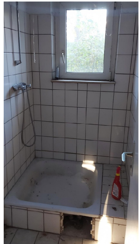
14. Lichtbild: Innenansicht DU, Haus 3 A, im Erdgeschoss.
