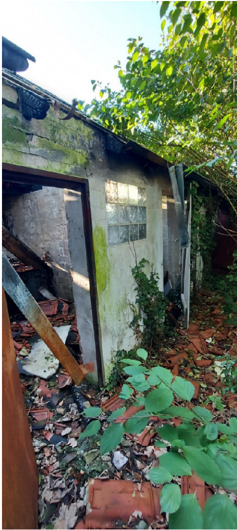
5. Lichtbild: Rückseitige Traufansicht des Nebengebäudes 1.
