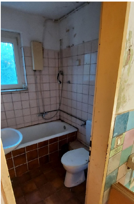
17. Lichtbild: Innenansicht Bad, Haus 4, im Erdgeschoss.
