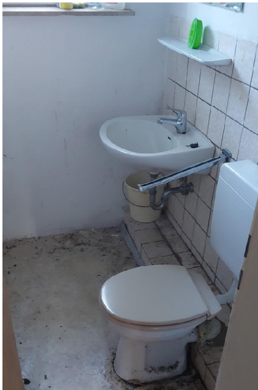
13. Lichtbild: Innenansicht WC, Haus 3 A, im Erdgeschoss.
