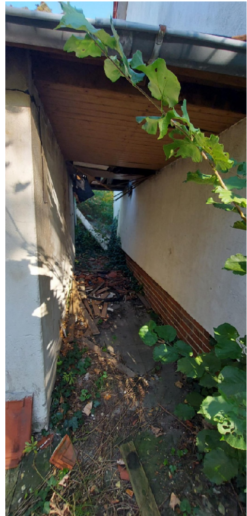
6. Lichtbild: Durchgang zwischen Wohngebäude und Nebengebäude 1.
