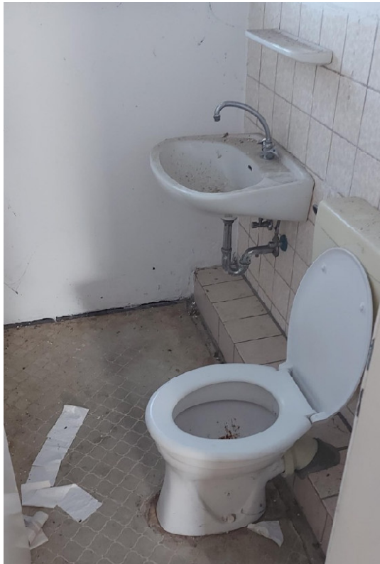
15. Lichtbild: Innenansicht WC, Haus 3 A, im Obergeschoss.
