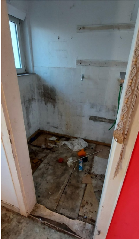
23. Lichtbild: Innenansicht Küche, im Obergeschoss, Haus 3.
