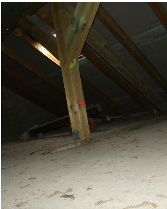
29. Lichtbild Holzkonstruktion im Spitzboden, Haus 4.
