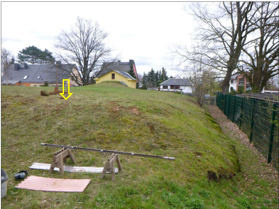
Rammkernsondierung (RKS) 3 – Ansatzpunkt
