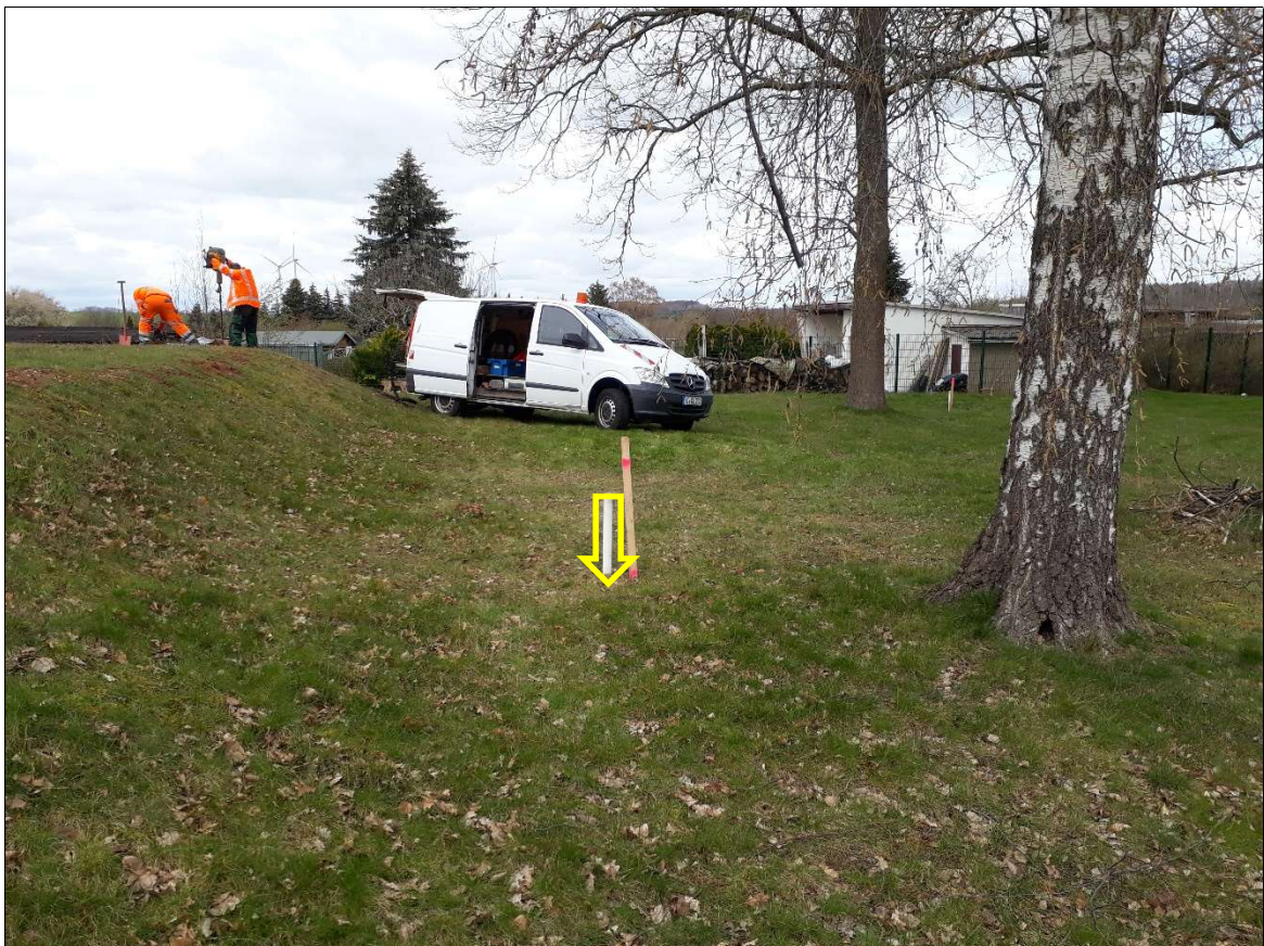
Rammkernsondierung Radonsonde (RA) II – Ansatzpunkt
