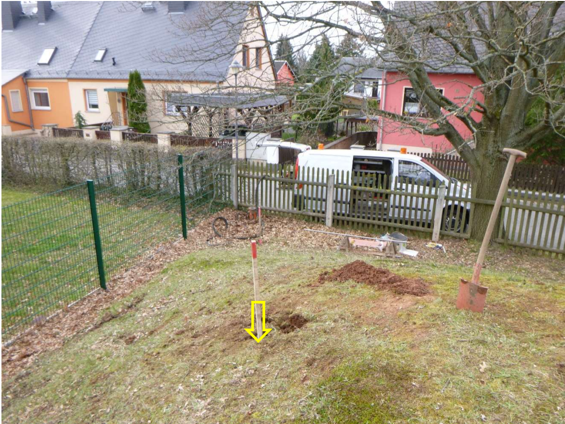
Rammkernsondierung (RKS) 2 – Ansatzpunkt
