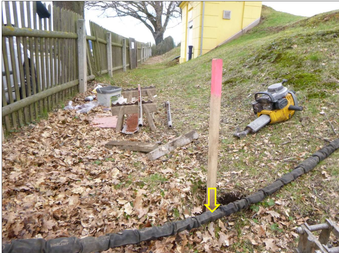
Rammkernsondierung (RKS) 1 – Ansatzpunkt
