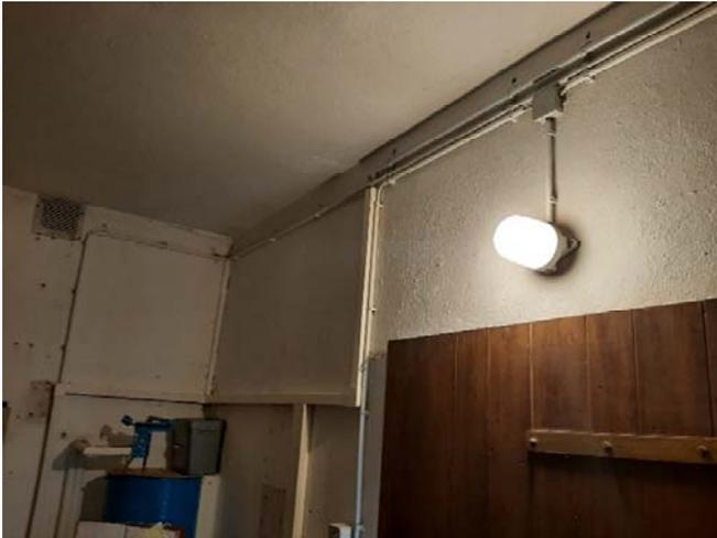
Die Objektinstallation besteht aus Leuchten, Schaltern und Steckdosen.
