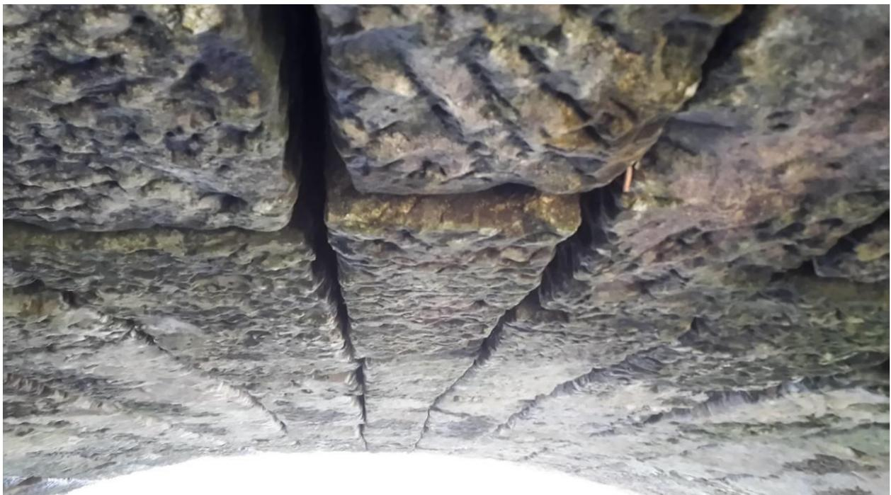
Abb. 10: Blick auf die kontrollierten Spalten am Gewölbe der Hüttenhofbrücke von unten längs (19.03.2024)
