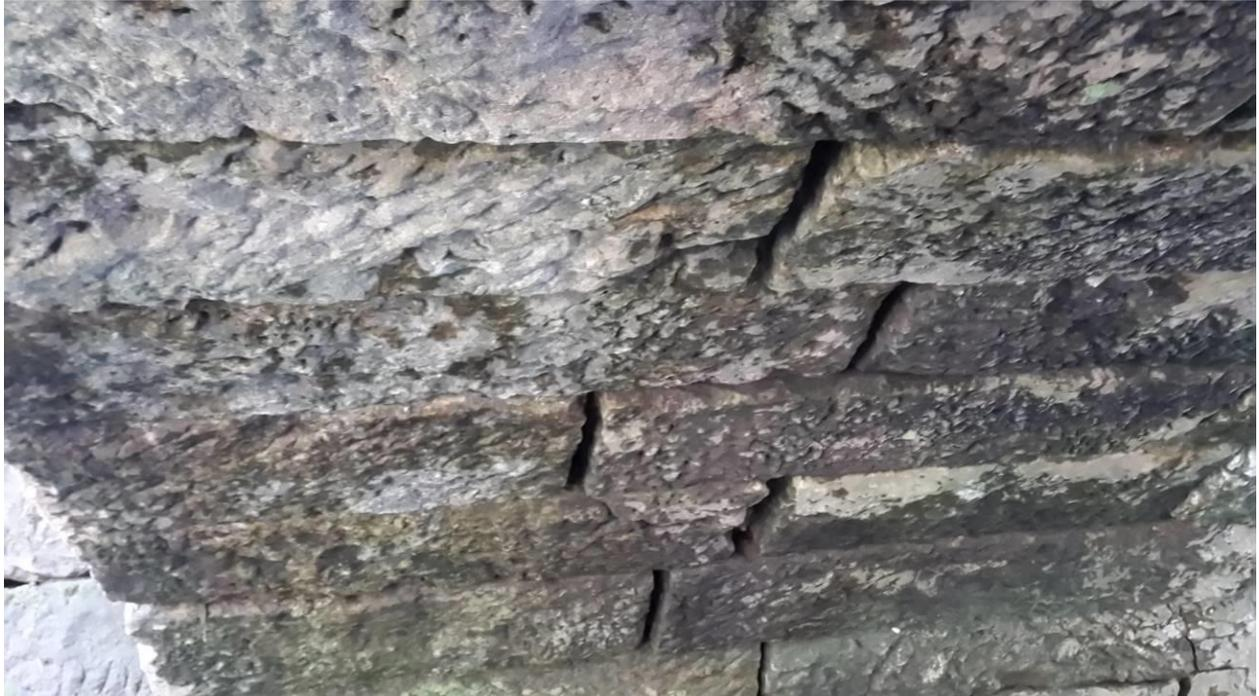
Abb. 11: Blick auf die kontrollierten Spalten am Gewölbe der Hüttenhofbrücke von unten seitlich (19.03.2024)
