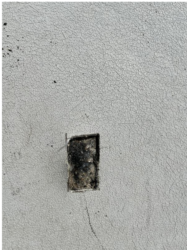
Telmannstraße: Kunststoffolie (1 Lage) , darunter Beton mit Anstrich/Kleber
