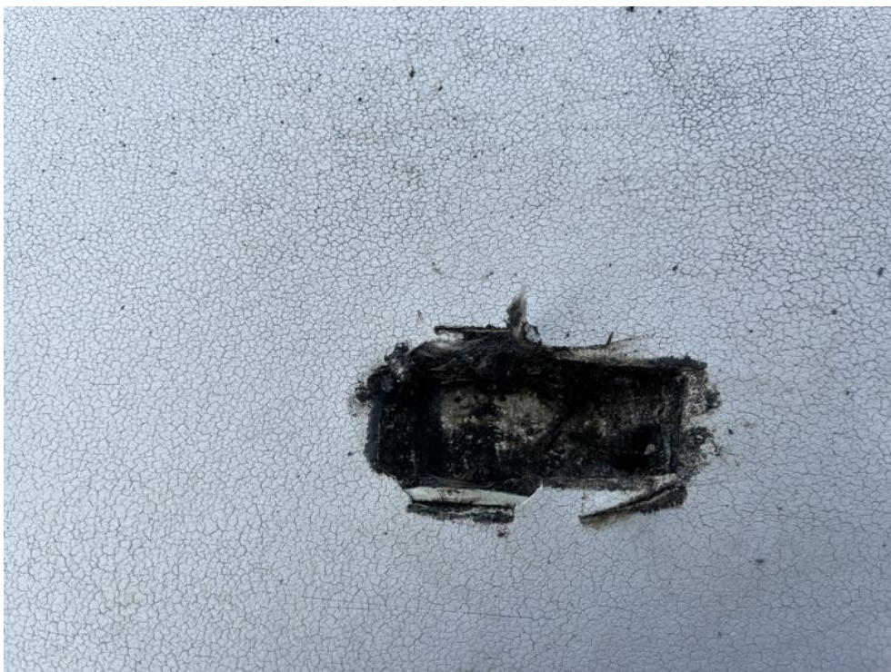
Haydnstraße: Aufbau Dacheindeckung: Dachpappe, Kunststoffolie (von unten nach oben)
