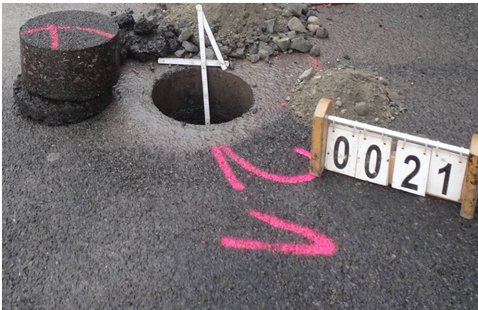
Bild 68: Entnahmestelle 21, Schurf S9 – FB Umstrukturierung Trinkwasserleitung Thallwitz – Lossatal 2. BA, Bereich Fahrbahn Material der einzelnen Schichten ausgebaut
