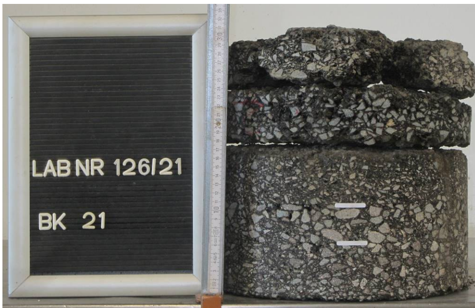
Bild 70: Entnahmestelle 21 Umstrukturierung Trinkwasserleitung Thallwitz – Lossatal 2. BA, Bereich Fahrbahn Detail Bohrkern Entnahmestelle 21, Ø 300 mm
