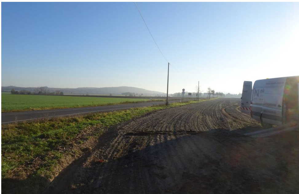
Bild 50: Entnahmestelle 16, Rammkernsondierung RKS 12 Umstrukturierung Trinkwasserleitung Thallwitz – Lossatal 1. BA, Bereich Feld Übersicht
