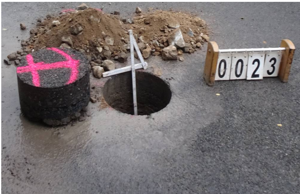
Bild 76: Entnahmestelle 23, Schurf S11 – FB Umstrukturierung Trinkwasserleitung Thallwitz – Lossatal 2. BA, Bereich Fahrbahn Material der einzelnen Schichten ausgebaut
