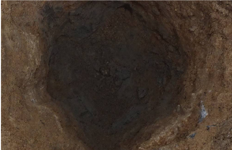
Bild 61: Entnahmestelle 19, Schurf S7 – FB Umstrukturierung Trinkwasserleitung Thallwitz – Lossatal 1. BA, Bereich Fahrbahn Blick in Schurf
