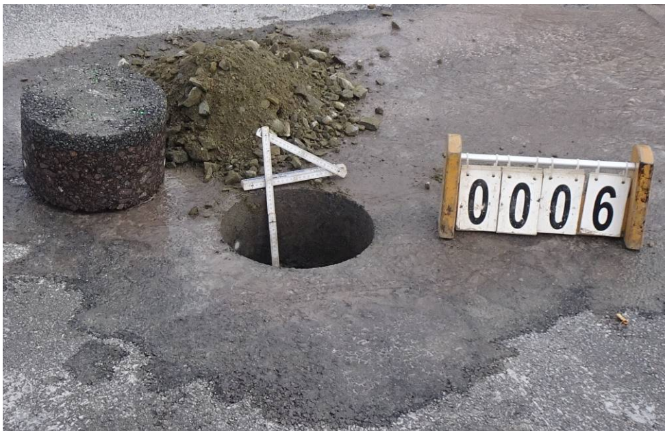
Bild 18: Entnahmestelle 6, Schurf S3 – FB Umstrukturierung Trinkwasserleitung Thallwitz – Lossatal 1. BA, Bereich Fahrbahn Material der einzelnen Schichten ausgebaut
