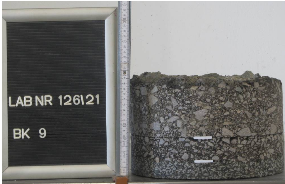
Bild 31: Entnahmestelle 9 Umstrukturierung Trinkwasserleitung Thallwitz – Lossatal 1. BA, Bereich Fahrbahn Detail Bohrkern Entnahmestelle 9, \varnothing 300 mm
