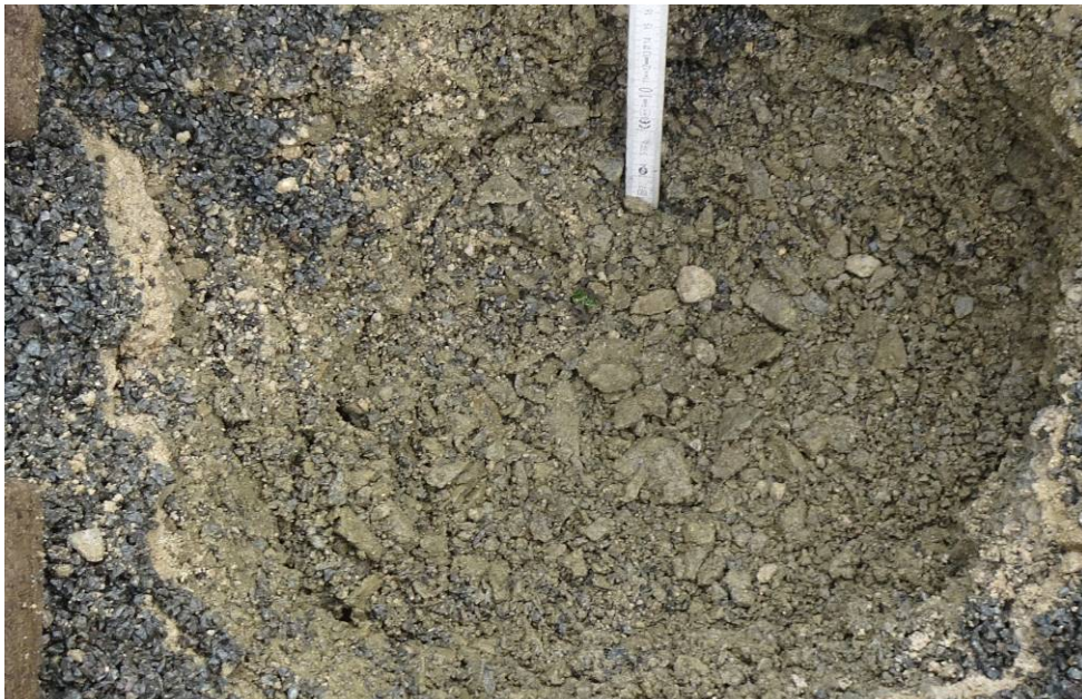
Bild 16: Entnahmestelle 5, Schurf S2 – GW Umstrukturierung Trinkwasserleitung Thallwitz – Lossatal 1. BA, Bereich Gehweg Blick in Schurf
