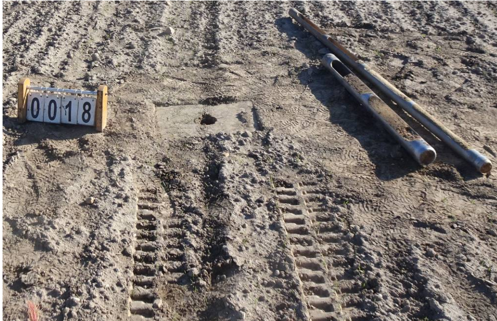
Bild 57: Entnahmestelle 18, Rammkernsondierung RKS 14 Umstrukturierung Trinkwasserleitung Thallwitz – Lossatal 1. BA, Bereich Feld Material der einzelnen Schichten ausgebaut
