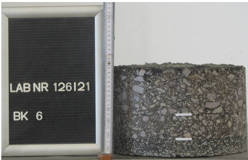
Bild 20: Entnahmestelle 6 Umstrukturierung Trinkwasserleitung Thallwitz – Lossatal 1. BA, Bereich Fahrbahn Detail Bohrkern Entnahmestelle 6, Ø 300 mm
