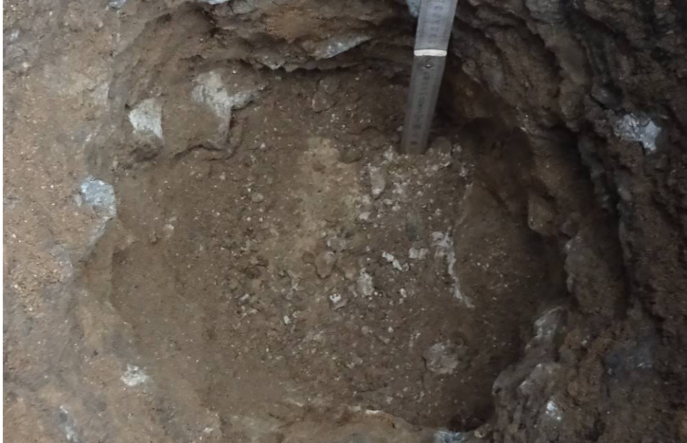
Bild 77: Entnahmestelle 23, Schurf S11 – FB Umstrukturierung Trinkwasserleitung Thallwitz – Lossatal 2. BA, Bereich Fahrbahn Blick in Schurf
