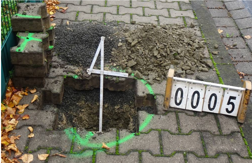
Bild 15: Entnahmestelle 5, Schurf S2 – GW Umstrukturierung Trinkwasserleitung Thallwitz – Lossatal 1. BA, Bereich Gehweg Material der einzelnen Schichten ausgebaut
