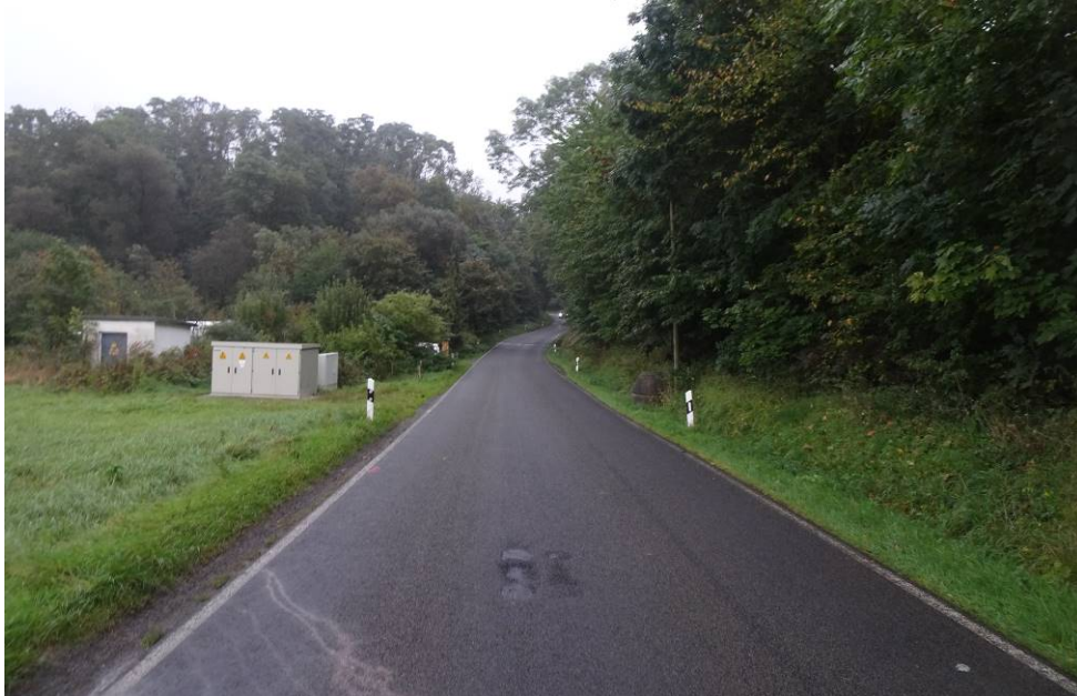
Bild 67: Entnahmestelle 21, Schurf S9 – FB Umstrukturierung Trinkwasserleitung Thallwitz – Lossatal 2. BA, Bereich Fahrbahn Übersicht
