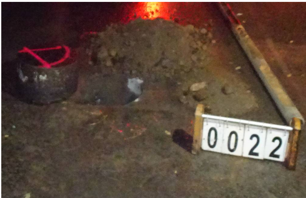
Bild 72: Entnahmestelle 22, Schurf S10 – FB / Rammkernsondierung RKS 16 Umstrukturierung Trinkwasserleitung Thallwitz – Lossatal 2. BA, Bereich Fahrbahn Material der einzelnen Schichten ausgebaut
