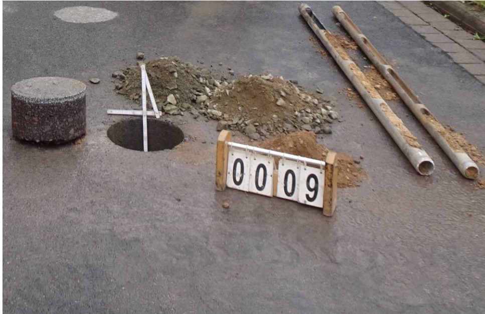
Bild 29: Entnahmestelle 9, Schurf S6 – FB / Rammkernsondierung RKS 5 Umstrukturierung Trinkwasserleitung Thallwitz – Lossatal 1. BA, Bereich Fahrbahn Material der einzelnen Schichten ausgebaut
