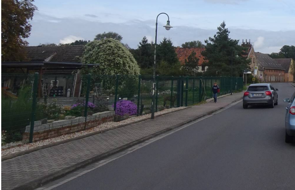
Bild 17: Entnahmestelle 6, Schurf S3 – FB Umstrukturierung Trinkwasserleitung Thallwitz – Lossatal 1. BA, Bereich Fahrbahn Übersicht
