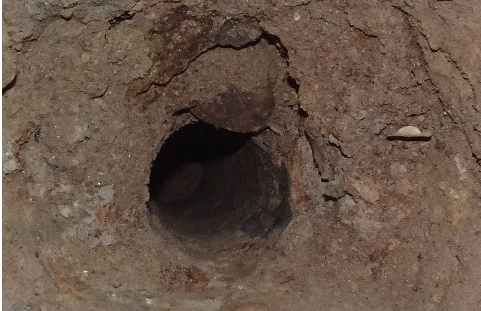
Bild 73: Entnahmestelle 22, Schurf S10 – FB / Rammkernsondierung RKS 16 Umstrukturierung Trinkwasserleitung Thallwitz – Lossatal 2. BA, Bereich Fahrbahn Blick in Sondierstelle
