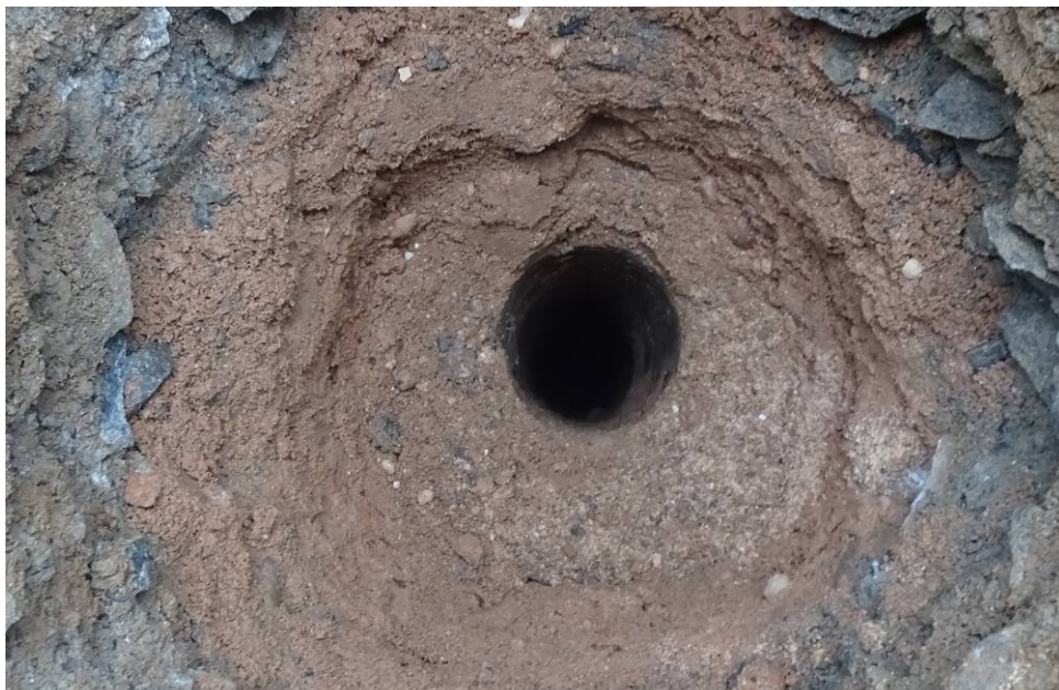
Bild 30: Entnahmestelle 9, Schurf S6 – FB / Rammkernsondierung RKS 5 Umstrukturierung Trinkwasserleitung Thallwitz – Lossatal 1. BA, Bereich Fahrbahn Blick in Sondierstelle
