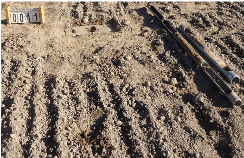
Bild 36: Entnahmestelle 11, Rammkernsondierung RKS 7 Umstrukturierung Trinkwasserleitung Thallwitz – Lossatal 1. BA, Bereich Feld Material der einzelnen Schichten ausgebaut
