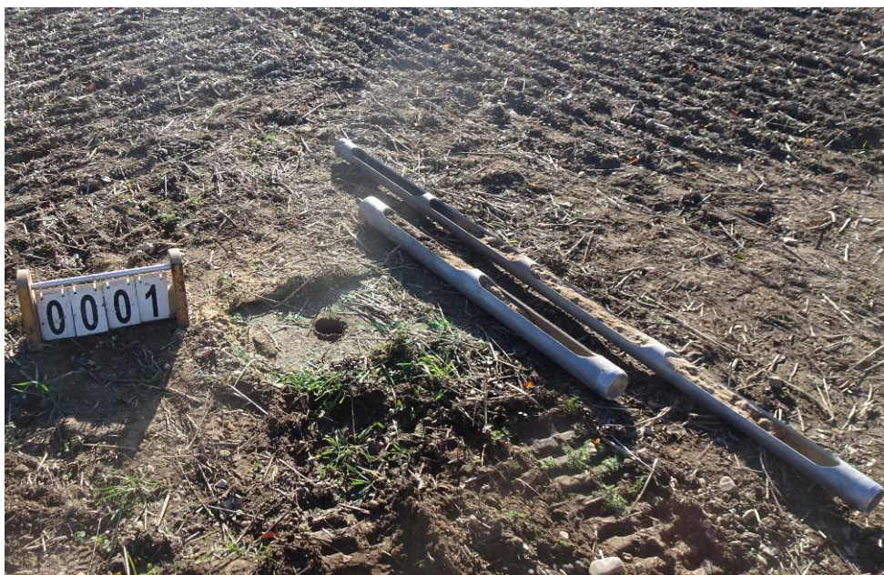
Bild 2: Entnahmestelle 1, Rammkernsondierung RKS 1 Umstrukturierung Trinkwasserleitung Thallwitz – Lossatal 1. BA, Bereich Feld Material der einzelnen Schichten ausgebaut
