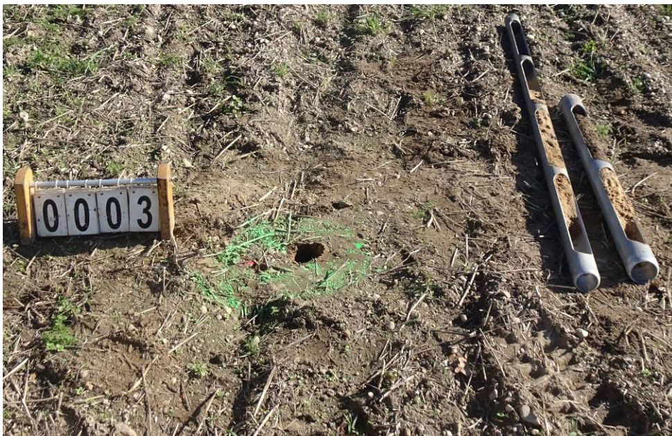
Bild 8: Entnahmestelle 3, Rammkernsondierung RKS 3 Umstrukturierung Trinkwasserleitung Thallwitz – Lossatal 1. BA, Bereich Feld Material der einzelnen Schichten ausgebaut
