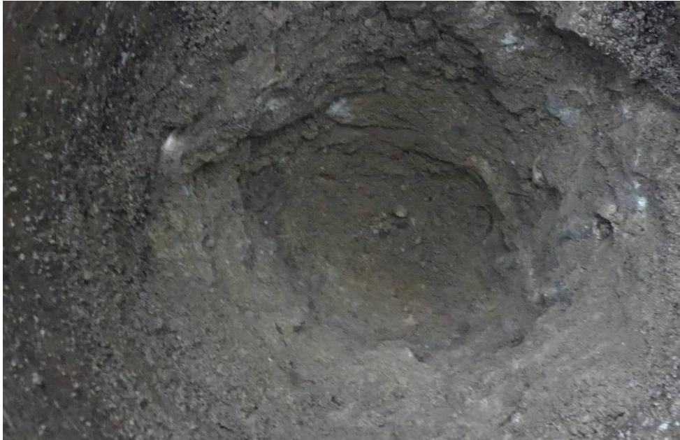
Bild 69: Entnahmestelle 21, Schurf S9 – FB Umstrukturierung Trinkwasserleitung Thallwitz – Lossatal 2. BA, Bereich Fahrbahn Blick in Schurf
