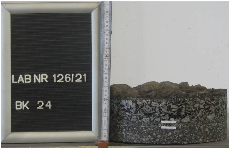
Bild 82: Entnahmestelle 24 Umstrukturierung Trinkwasserleitung Thallwitz – Lossatal 2. BA, Bereich Fahrbahn Detail Bohrkern Entnahmestelle 24, Ø 300 mm
