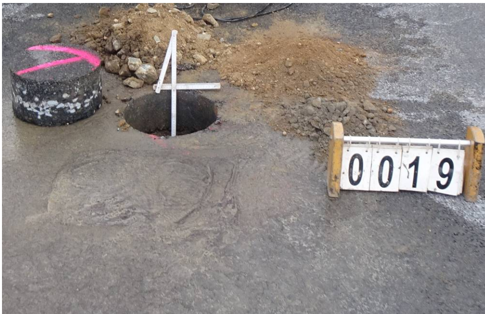
Bild 60: Entnahmestelle 19, Schurf S7 – FB Umstrukturierung Trinkwasserleitung Thallwitz – Lossatal 1. BA, Bereich Fahrbahn Material der einzelnen Schichten ausgebaut
