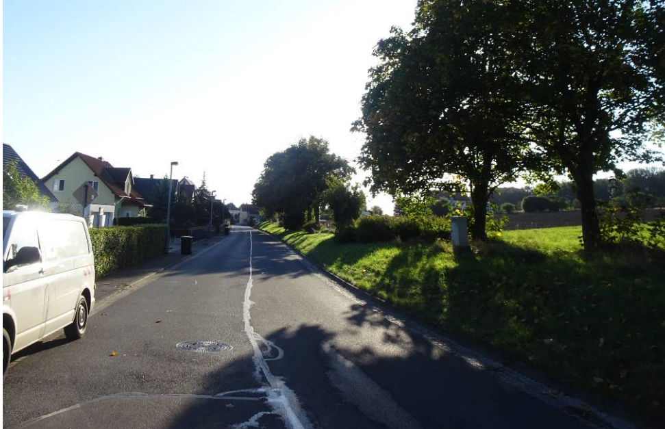
Bild 79: Entnahmestelle 24, Schurf S12 – FB / Rammkernsondierung RKS 17 Umstrukturierung Trinkwasserleitung Thallwitz – Lossatal 2. BA, Bereich Fahrbahn Übersicht
