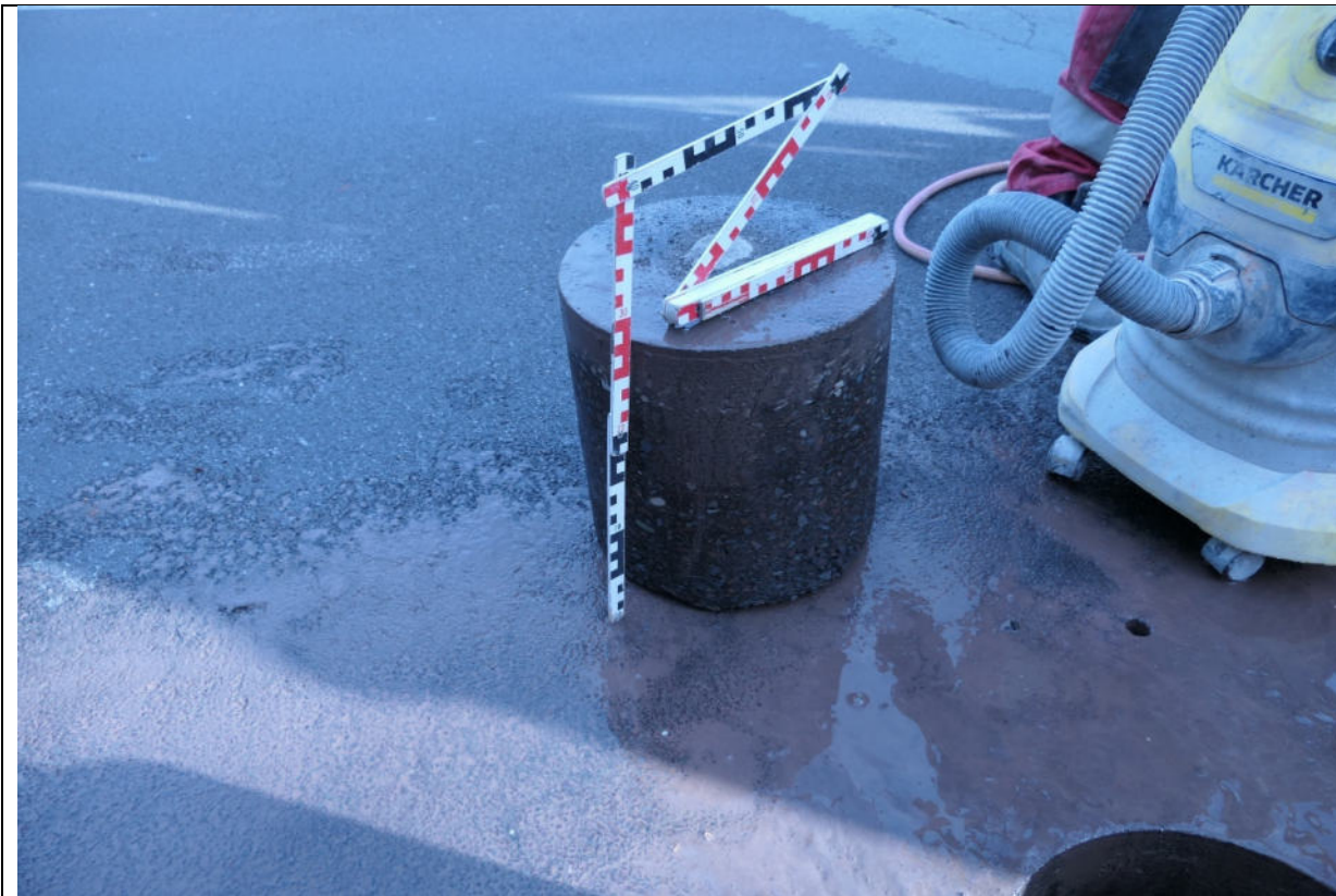
Kernbohrung 1, Brückendamm, Durchmesser 0,30 m, 0,38 m Asphalt
