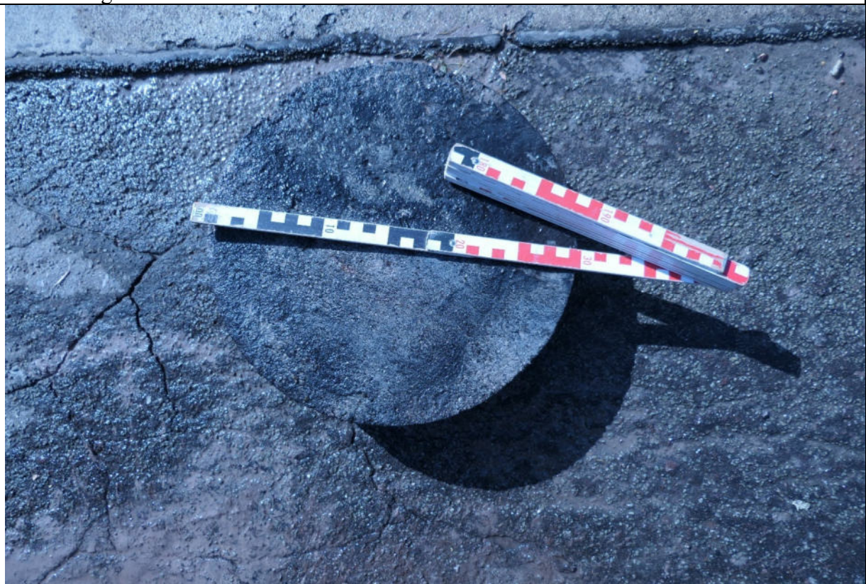
Kernbohrung 3 Abdichtung an Asphalt anhaftend
