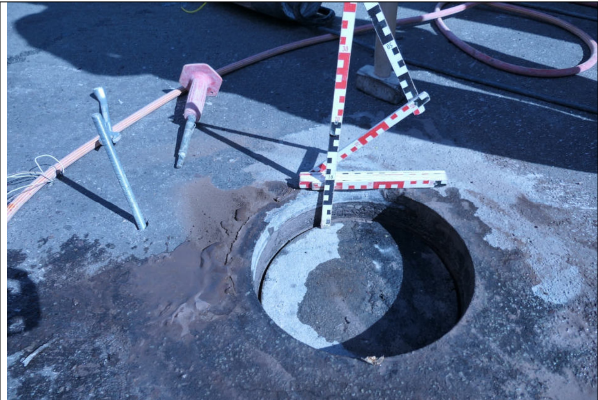
Kernbohrung 3, auf der Brücke, Durchmesser 30 cm, Asphaltstärke 7 cm, im Anschluss Abdichtung
