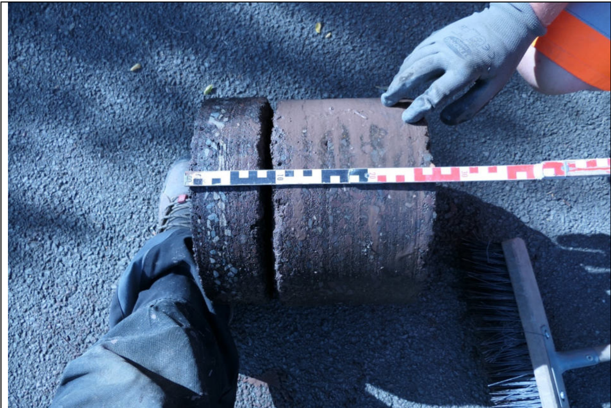
Kernbohrung 2, Brückendamm, Durchmesser 30 cm, 0,38 m Asphalt
