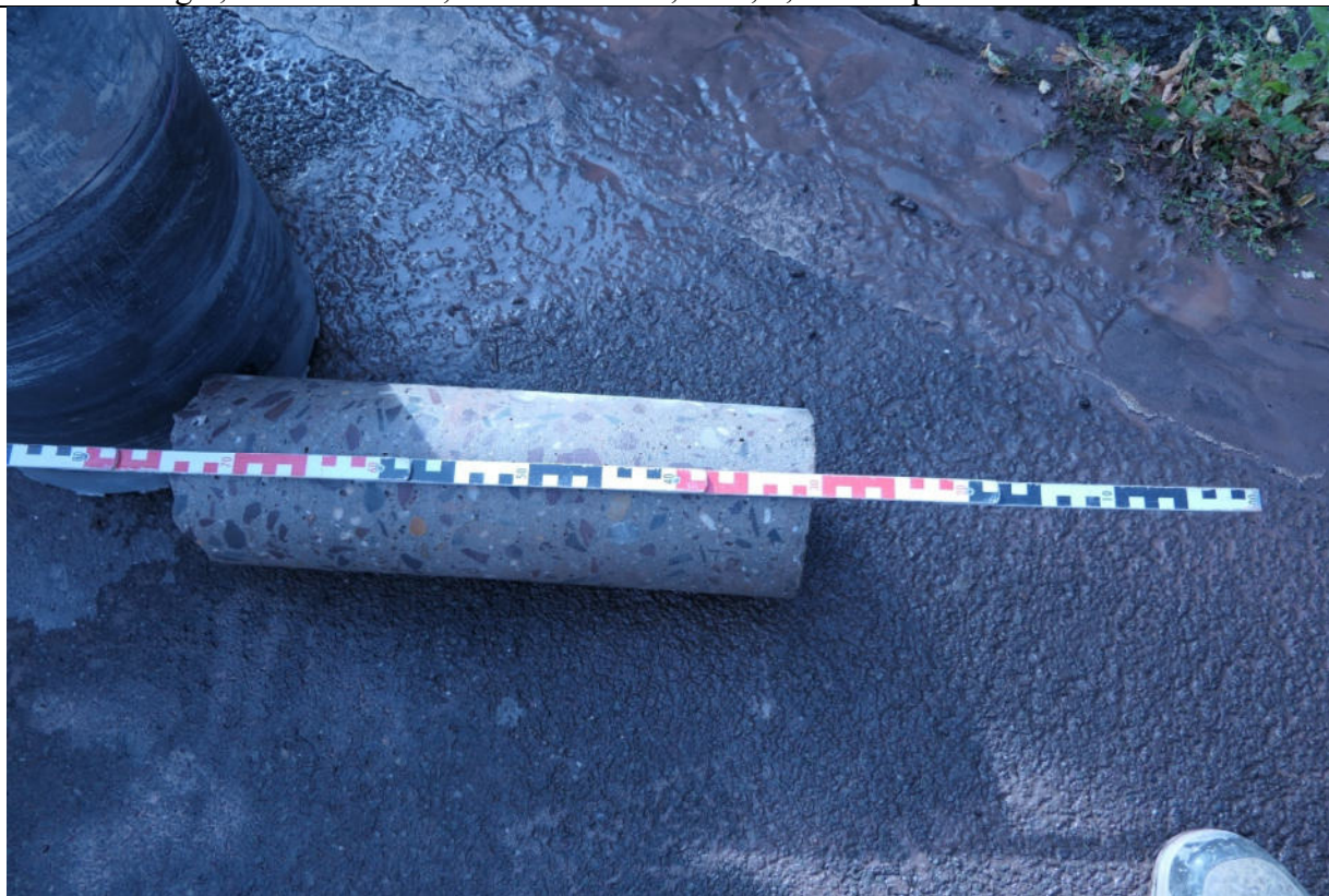
Kernbohrung 1, Brückendamm, Beton ohne Bewehrung, von 0,38 m – 0,75 m, Abbruch
