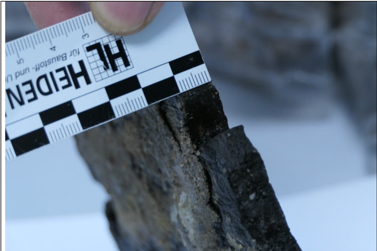
Kernbohrung 4, Abdichtung (Schichtstärke 1 cm, 1 Lage)
