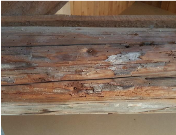
Abb. 03: Detail eines Balkens im Rittersaalboden mit weißlich kristallinen Ausblühungen
