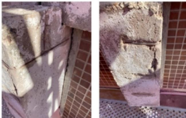
Betonabplatzungen an Auflagerkonsolen infolge mangelhafter Betondeckung
