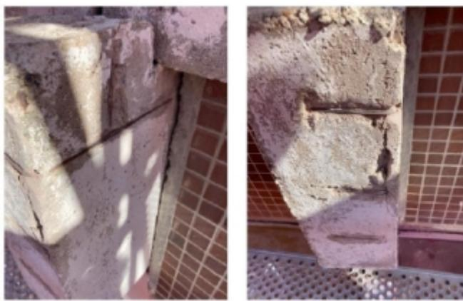
Betonabplatzungen an Auflagerkonsolen infolge mangelhafter Betondeckung
