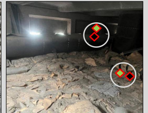
Untersuchung Trennpappe u. Dämmwolle (unterer Bildbereich) sowie Rohrisolierung u. Rohrummantelung (oberer Bildbereich) im Drempel.
