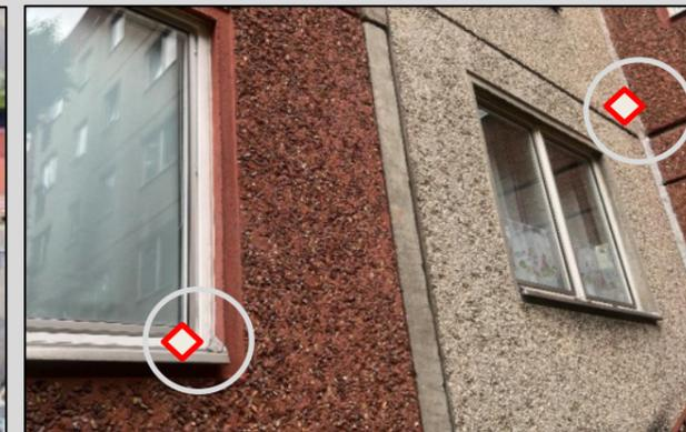
Untersuchung der Fugen im Haustürbereich (rechts eingekreist) sowie des Fugenkitts im Bereich der Fenster (links eingekreist).
