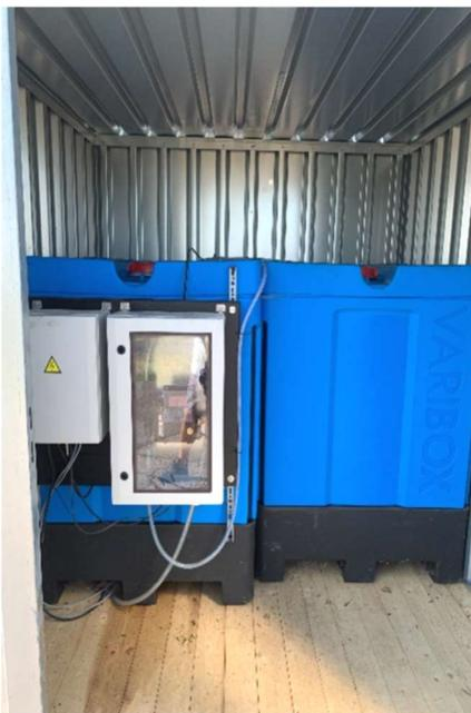
Abb. Doppelwandige IBC mit Dosierpumpe
