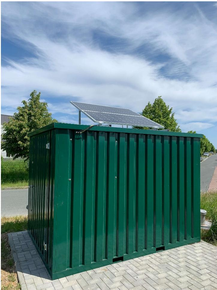
Abb. Dosiercontainer mit Solar
