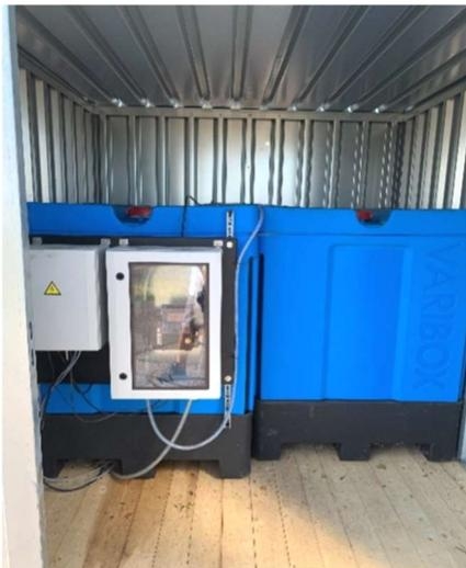
**Abb.** Doppelwandige IBC mit Dosierpumpe
