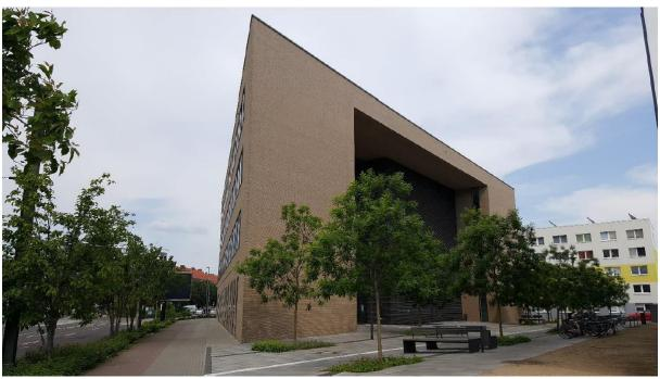
Der 4-geschossige Forschungsneubau "Systembiologie", der 2013 fertiggestellt wurde, ist teilunterkellert, das Tragsystem besteht aus einem Stahlbetonskelettbau mit Stahlbetondecken, Unter- und Überzügen sowie tragenden Stahlbetonstützen und Treppenhäusern.
