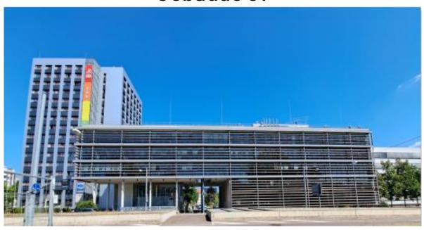
Das Gebäude wurde 1998 neu erbaut. Es beherbergt die Fakultät für Elektrotechnik und Informationstechnik. Charakteristisch für das Bauwerk sind das Flachdach und die Glasfassade sowie der fest installierte horizontale Sonnenschutz an der Südfassade.
