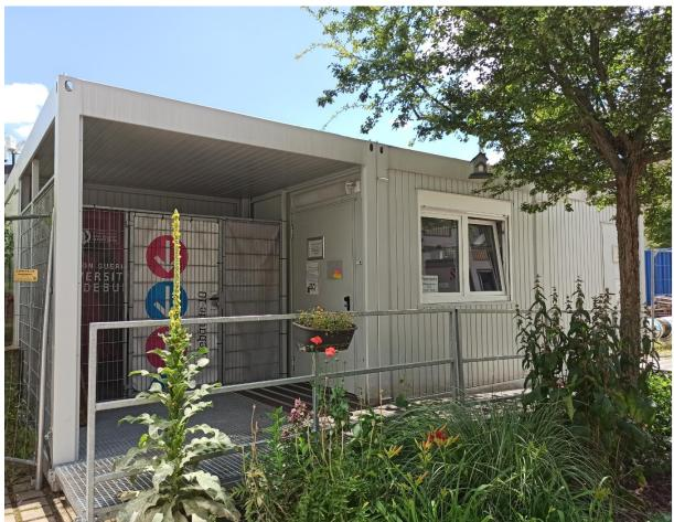
Das Gebäude 19.1 ist ein Flachbau in Modulbauweise, welcher vorrangig aus Lagerräumen und Büros besteht.
