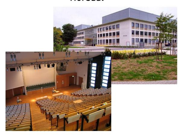
Das 1963 als Institutsgebäude errichtete Gebäude 16 umschließt einen Innenhof in rechteckiger Form, in welchen das trapezförmige Hörsaalgebäude eingebaut ist. Drei Flügel sind einbündig mit hofseitigem Flur, der vierte Flügel ist als Zweibünder mit größerer Bautiefe ausgeführt.
