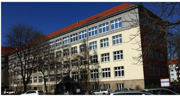
Das Gebäude 3 wurde 1958 als Hochschulgebäude in Massivbauweise mit zweibündigem Grundriss errichtet. Das Gebäude grenzt in Winkelform an das Gebäude 2 und ist mit diesem verbunden.
