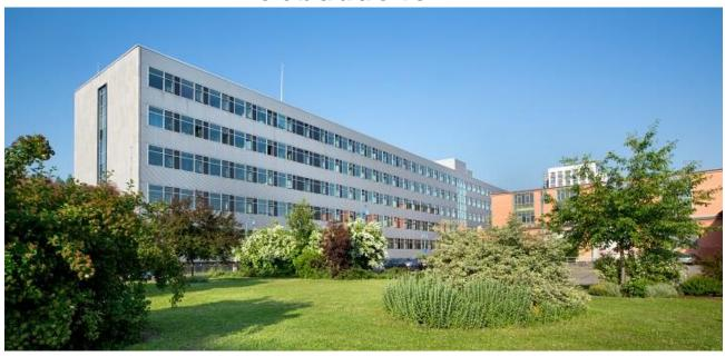
Das Gebäude 10 mit großflächigen Fensterelementen ist ein langgezogener Flachdachriegel in Stahlbetonskelettbauweise im typischen Stil der 60er und 70er Jahre. Es wurde 1967 erbaut und liegt an der Walther-Rathenau-Straße.
