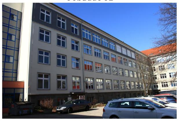
Das Gebäude wurde 1961 als Hochschulgebäude in Massivbauweise mit zweibündigem Grundriss errichtet. Es liegt an der Gareisstraße und bildet mit dem benachbarten Gebäude 3 einen größeren Komplex in Winkelform.
