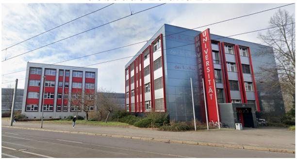
Die Gebäude auf dem Eckgrundstück Hohenstaufenring / Pfälzer Straße wurden 1990 / 1991 als Institutsgebäude errichtet. Bei den in Würfelform konzipierten Gebäuden handelt es sich um eine für den Schulbau entwickelte Typenbauweise mit Fertigteilelementen.
