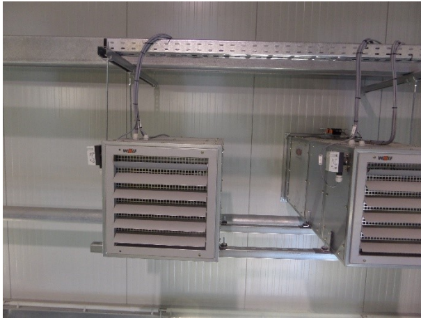
Abbildung 1 Lüfterhitzer mit Umluftkasten (rechts)
