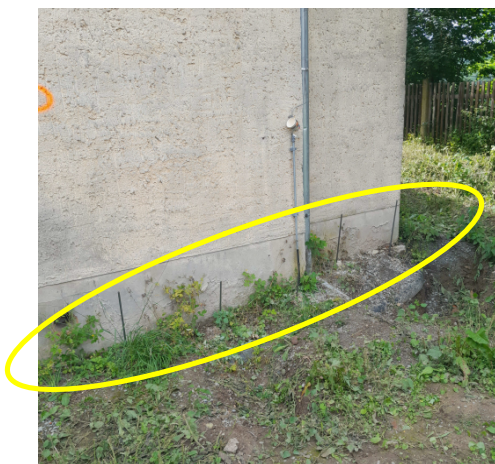
Abb. 6 + 7: Eingebaute Injektionslanzen entlang der vorgegebenen Fundamente, bis in Tiefen von 2,0 m bzw. 3,0 m unter Bohransatzpunkt und einem Abstand von ca. 0,8 m.
