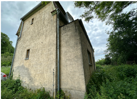
Abb. 1: Blick auf das zu bearbeitende Gebäude.
