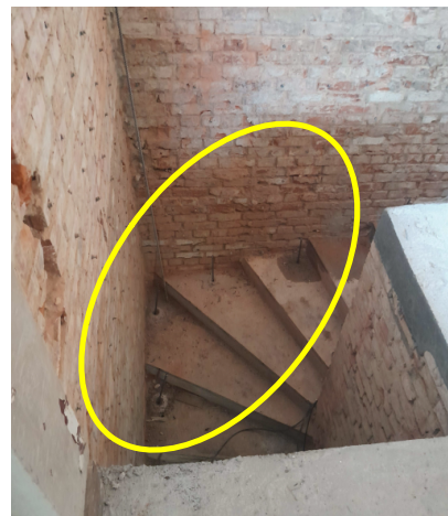
Abb. 6 + 7: Eingebaute Injektionslanzen entlang der vorgegebenen Fundamente, bis in Tiefen von 2,0 m bzw. 3,0 m unter Bohransatzpunkt und einem Abstand von ca. 0,8 m.
