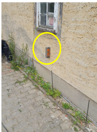
Abb. 9+10: Während der Injektionsarbeiten wurden die Ausweichsbewegung des Fußbodens über digitale Schlauchwaagen überwacht
