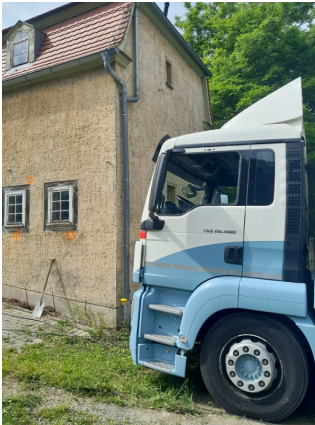
Abb. 5: Baustelleneinrichtung der Firma URETEK. Diese ist vollkommen autark, der benötigte Strom für die Ausführung der Injektionen wird direkt auf dem LKW produziert.
