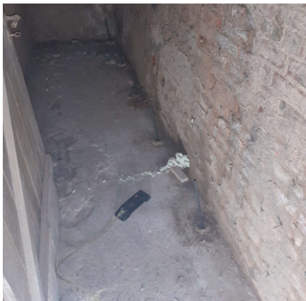
Abb. 9+10: Während der Injektionsarbeiten wurden die Ausweichsbewegung des Fußbodens über digitale Schlauchwaagen überwacht
