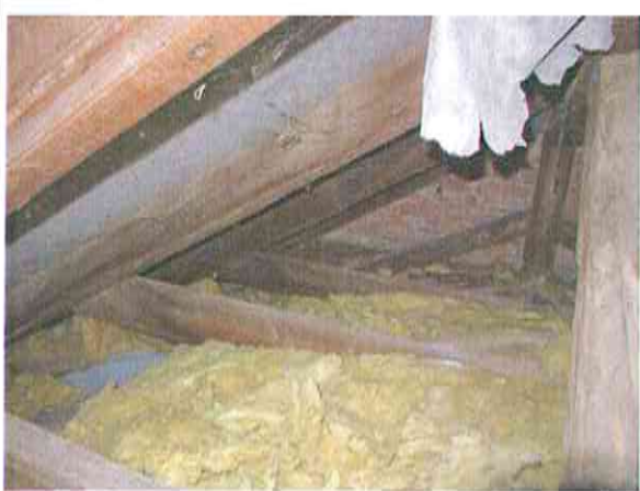
Dachgeschoss Gebäudeteil Mitte über dem Treppenhaus, Dachstuhl und Sparren ohne Schäden
