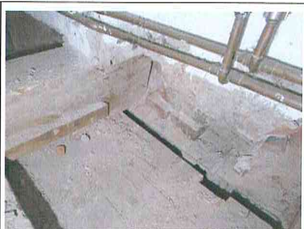
Freilegung Balkenauflager Gebäudeteil Ost Raum 4, Deckenbalkenauflager ohne Schäden
