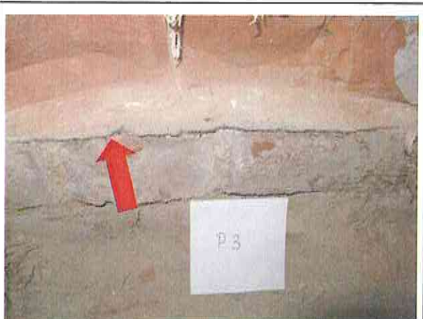
Horizontalsperre als Dachpappe im Erdgeschoss (beispielhaft)
