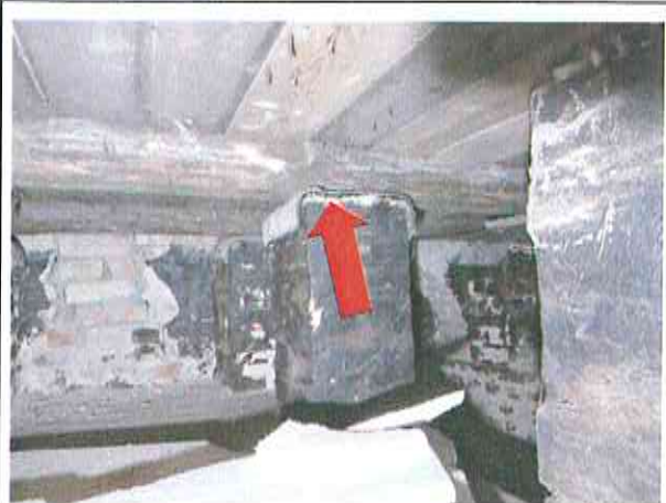
Dachpappe im Auflagerbereich der Lagerhölzer Fußbodenaufbau Gebäudeteil Ost (beispielhaft)
