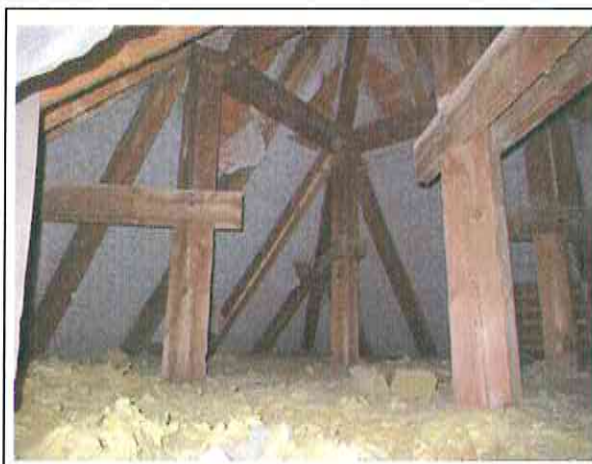
Dämmung der Geschossdecke zum Obergeschoss mit KMF Gebäude West
