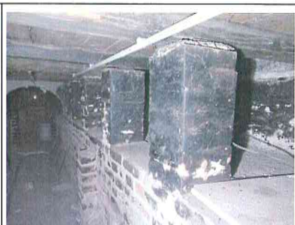
Kellergeschoss/Kriechkeller im östlichen Gebäudeteil, Mauerwerk mit einem Teeranstrich
