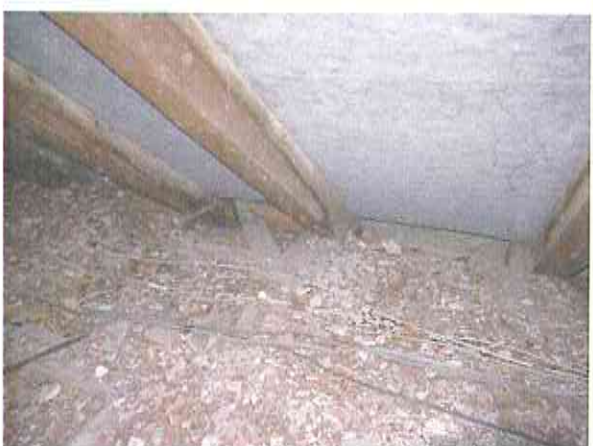
Dachgeschoss Gebäudeteil Ost ohne erkennbare Schäden
