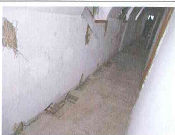
Freilegung Balkenauflager Gebäudeteil Ost Flur, Deckenbalkenauflager ohne Schäden
