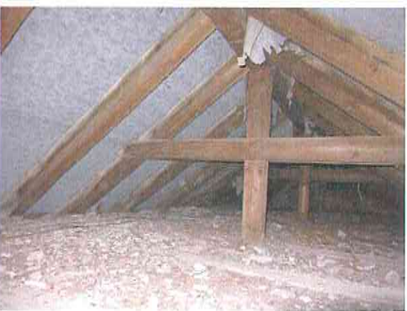
Dachgeschoss Gebäudeteil Ost ohne erkennbare Schäden
