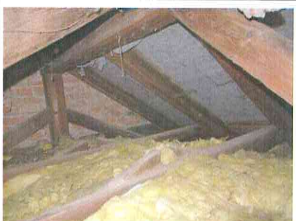
Dachgeschoss Gebäudeteil Mitte über dem Treppenhaus, Dachstuhl und Sparren ohne Schäden
