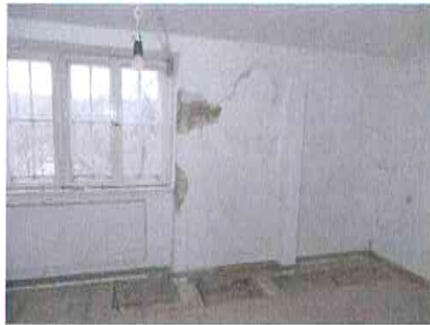
Deckenöffnung Holzbalkendecke Decke zwischen EG und DG Gebäudeteil Ost
