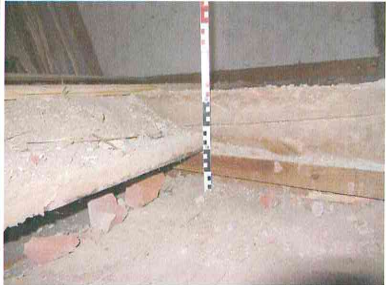
Aufbau Holzbalkendecke zwischen EG und DG Gebäudeteil Ost
