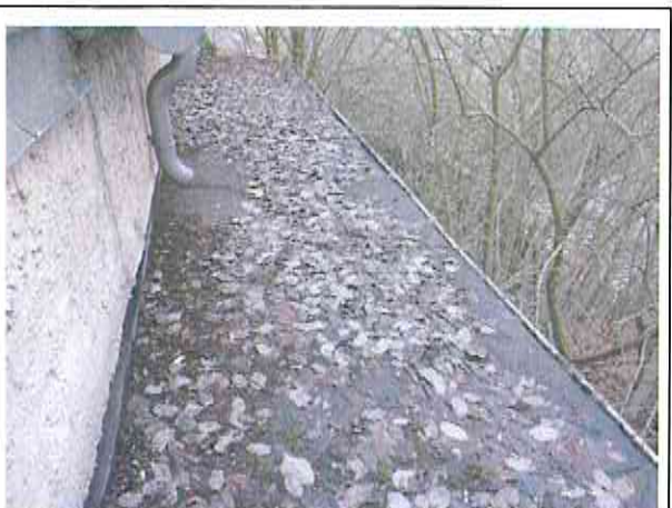
Flachdachabdichtung Dachpappe Gebäudeteil Ost - Freisitz
