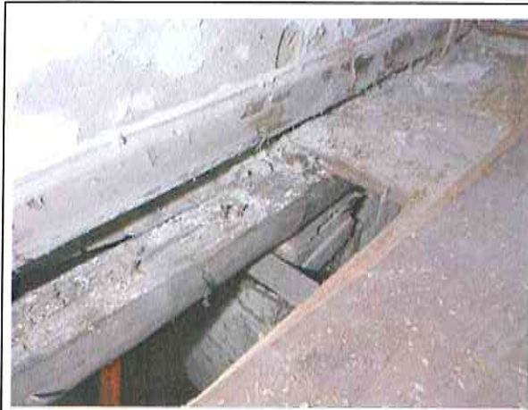
Gebäudeteil Ost Fußbodenaufbau Dielung auf Lagerhölzern
