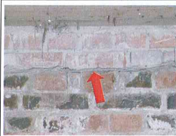
Horizontalsperre als Dachpappe im Kellergeschoss Gebäudeteil Ost (beispielhaft)
