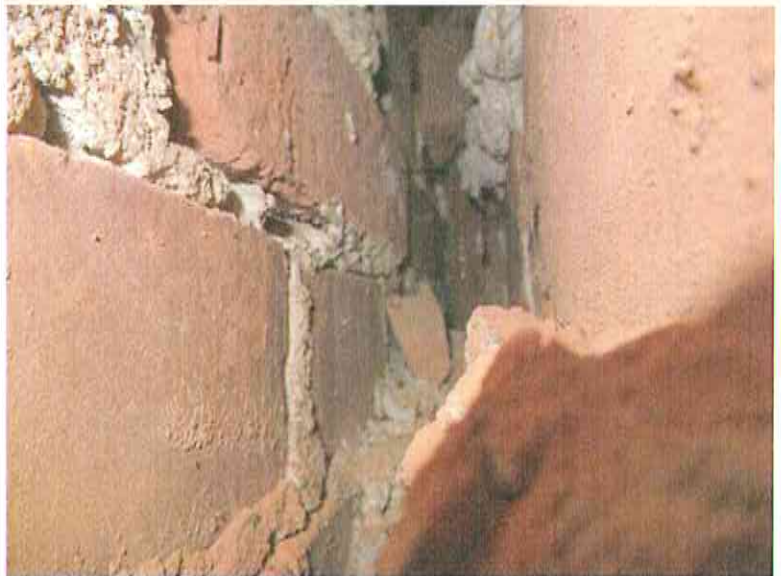
Hohlraum zwischen den Mauerwerksschalen
