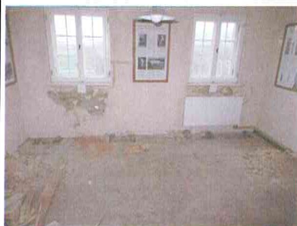
Freilegung Balkenaufleger Gebäudeteil West Außenwand Westseite
