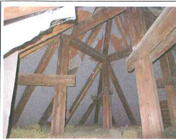
Dachgeschoss Gebäudeteil West Dachstuhl und Sparren ohne Schäden
