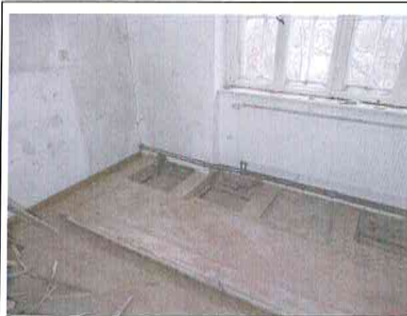
Freilegung Balkenauflager Gebäudeteil Ost Raum 4, Deckenbalkenauflager ohne Schäden
