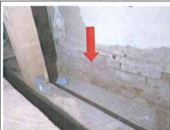
Bauwerksabdichtung gegen kapillar aufsteigende Feuchte als Dachbahn in einer Lagerfuge Gebäude West unterhalb Fußbodenniveau
