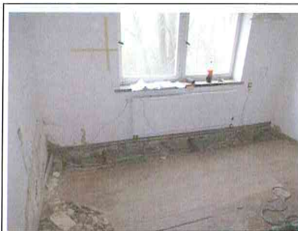
Gebäudeteil Mitte Raum 3 Nordseite Freilegung Balkenaufleger
