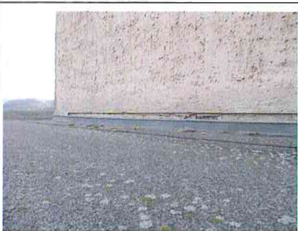
Flachdachabdichtung Dachpappe Gebäudeteil West - Freisitz
