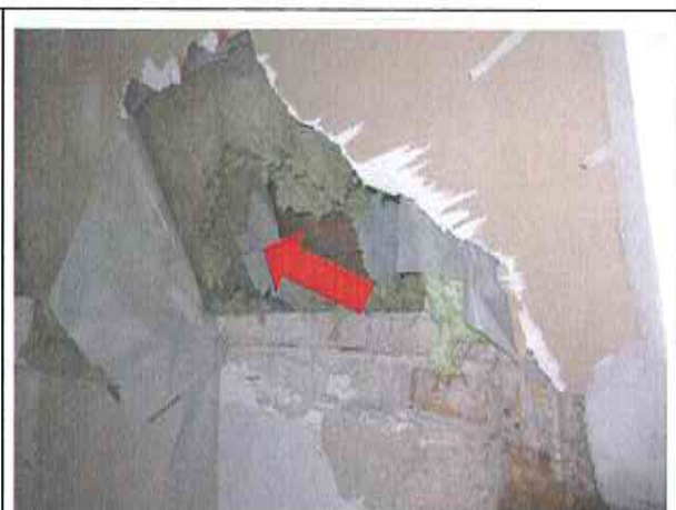
Dämmung der Dachschräge im Obergeschoss mit KMF Gebäude Mitte und Ost
