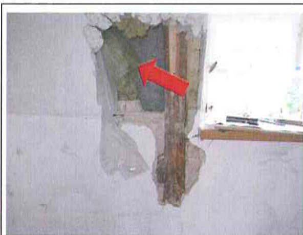
Dämmung der Dachschräge im Obergeschoss mit KMF Gebäude Mitte und Ost
