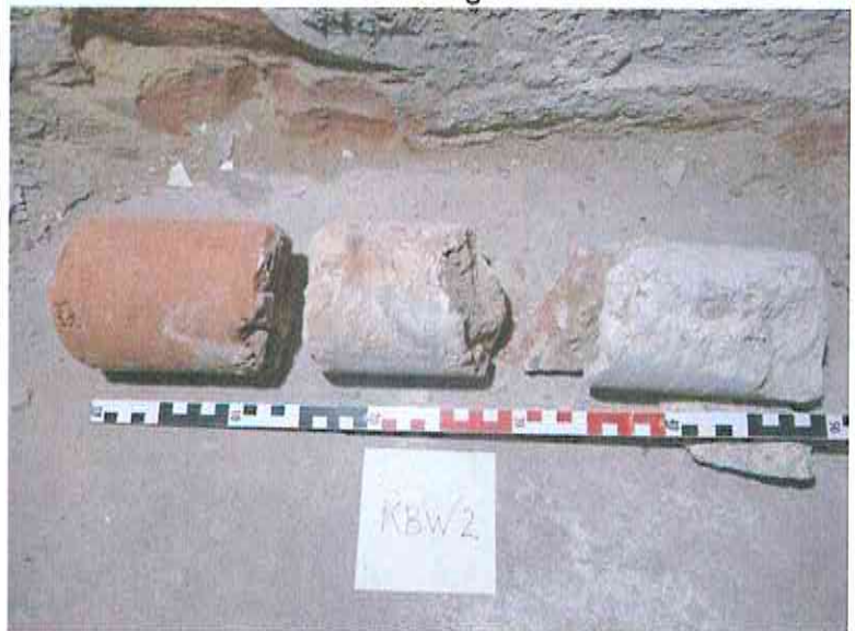
Kernbohrung KB 4, Bohrkern zerfallen
