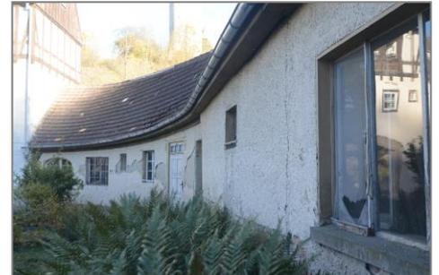
Abb. 34 Hoffassade der ehem. Werkstatt und des ehem. (offenen) Hühnerstalles mit starken bis mittleren Putzschäden
