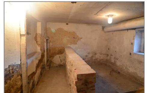
Abb. 36 bauzeitlicher Lehmputz mit starken bis mittleren Schäden (ehem. Hühnerstall)
