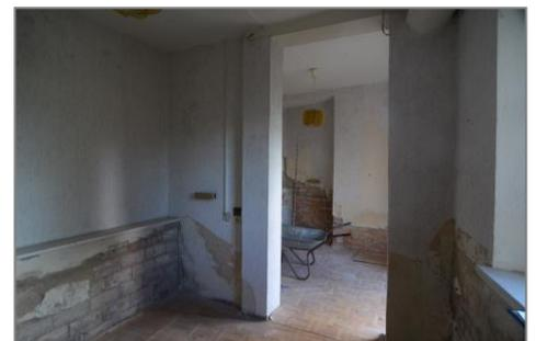
Abb. 37 entfernter Sockelputz an der Außenwand vom ehem. Hühnerstall
