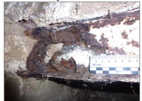
Abb. 40 Korrodiertes Stahlträger im Kellergeschoß
