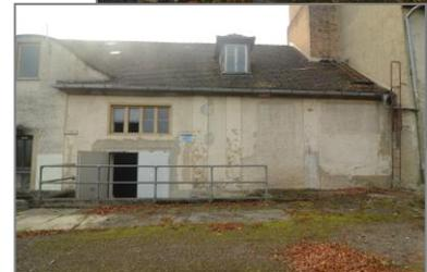
Abb. 28 erkennbare Schäden an der Dach- und Schieferdeckung sowie am Putz. Störender Schornstein. aktuelle Eingangssituation mit Metalltor zum Heizraum
