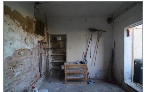
Abb. 35 starke Putzschäden an der Außenwand der ehem. Werkstatt
