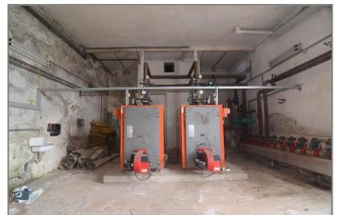
Abb. 29 nicht mehr funktionierende ehem. zentrale Heizungsanlage auf der tiefergelegten Erdgeschoßebene
