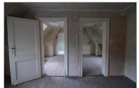
Abb. 32 Das ausgebaute Obergeschoß der Garage und der Remise. Wann der Ausbau genau erfolgte ist noch ungeklärt. Treppenaufgang sowie die Bodenbeläge lassen jedoch einen bauzeitlichen Ausbau vermuten.
