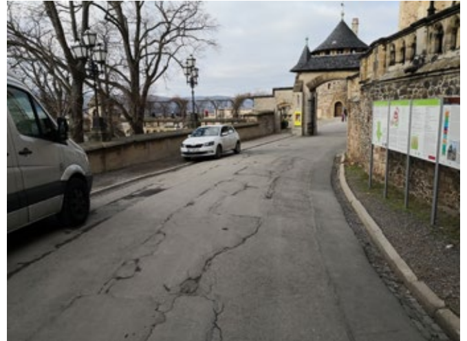
BT 1 - Schlosstraße / oberer Teil mit Blick zur Großen Terrasse
