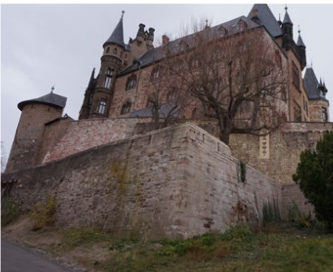
BT 2 - Bäckerhof / Stützmauer zur Schlosstraße
