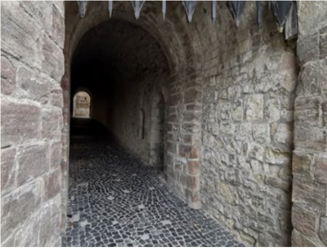
Tunnel - Abkürzung für Besucher unter Großen Terrasse
