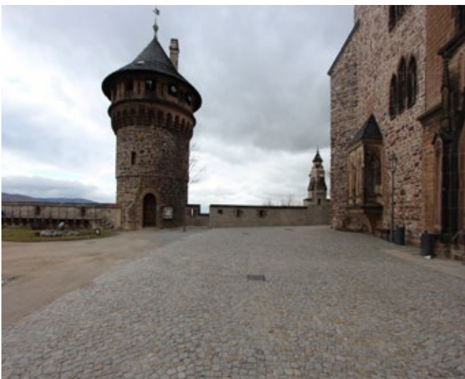
BT 7 - Große Terrasse / Blick zu Hausmannsturm und Knicktor
