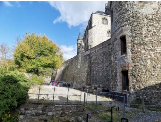
BT 2 - Bäckerhof / Zufahrt- Blick vom Tunnelausgang
