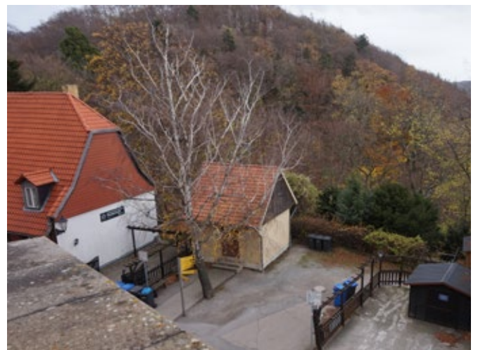
BT 1a - WC an Schlosstraße / im Bestand Trafohaus
