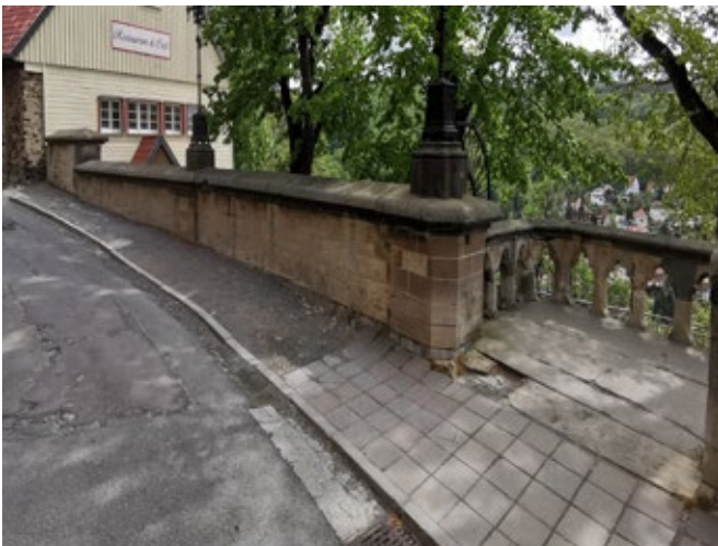
BT 16 - Stützmauer an Terrasse
