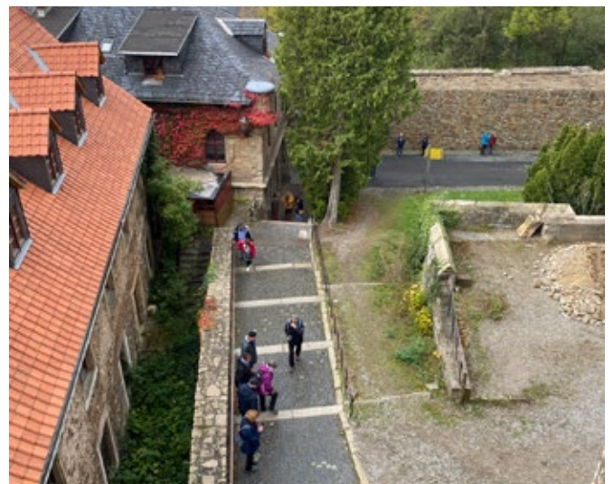
BT 2 - Bäckerhof / Aufgang Schlosstraße zum Tunnel zur Gr.Terrasse
