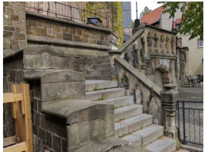
BT 17 - Treppe vom Fußgängertunnel zur oberen Schloßstraße (Andere Maßnahme)
