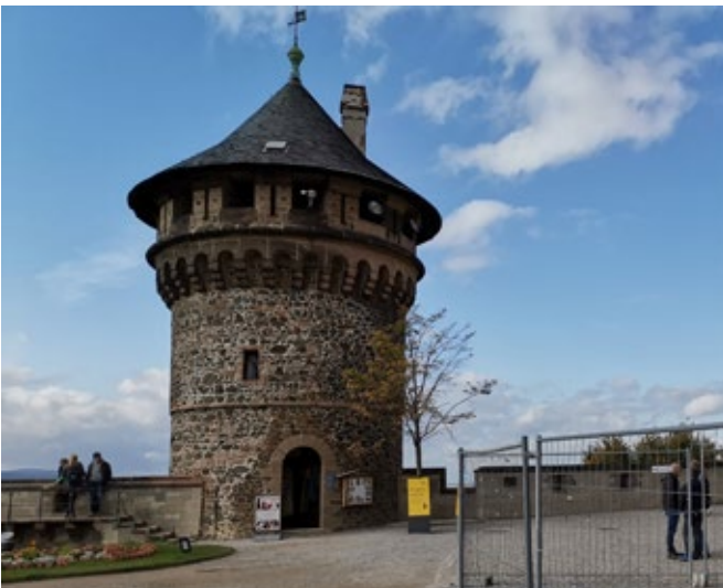
BT 2 - Bäckerhof / Stützmauer zur Schlosstraße
