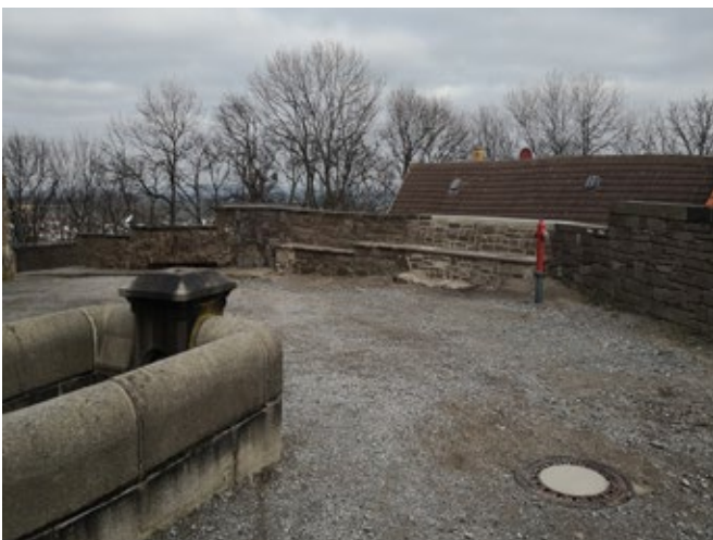
BT 8 - Innenring / oberhalb an Frühlingsbau und Kirchengang
