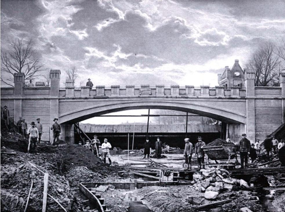
**Abb. 7:** historisches Foto (Ostansicht), Digitale Bibliothek Braunschweig, Originalbeschriftung: „Chausseebrücke und Wehr in Neugattersleben, Boderegulierung. Betonbogen, Spannweite 17.5 m, Ausgeführt 1906 von Drenckhahn & Sudhop, Braunschweig.“, Abbildung aus dem originalen Referenz-Katalog der Firma
