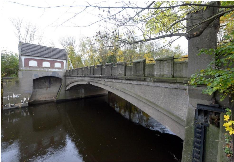
**Abb. 1:** Chausseebrücke mit Windenhaus von Süd-West, Richtung Schlosspark, an den Wiederlagern der gegenüberliegenden Uferböschungen war das Wehr gelagert
