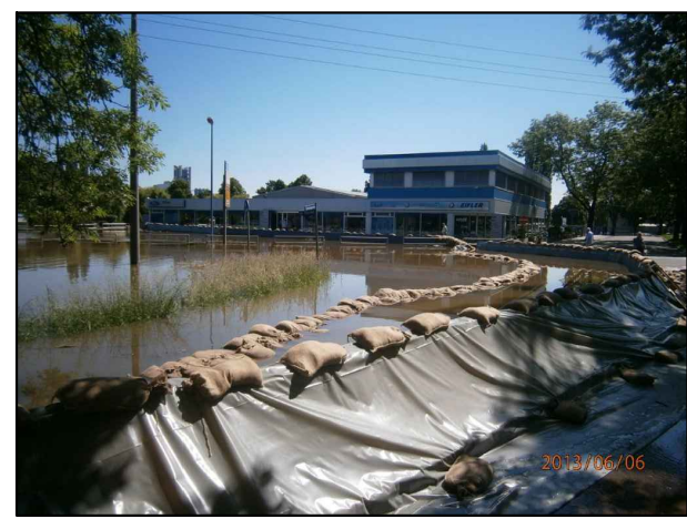
Station 0+760 Rückblick Bereich Autohaus während des Hochwassers 2013, 4. BA nicht Bestandteil der Planung
