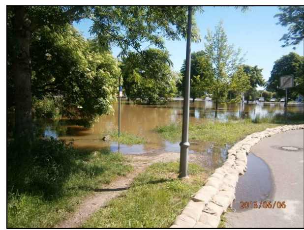
Station 0+810 Rückblick von Gutenbergstraße Richtung Autohaus während des Hochwassers 2013, Beginn gepl. HWSA, 2. BA, Ende 4. BA
