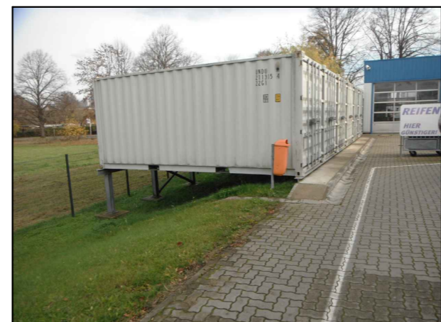
Station 0+590: Gelände Autohaus, Rückblick auf Container im Böschungsbereich, gepl. HWSA entlang Grundstücksgrenze (im Böschungsbereich), Neuanordnung der Einfriedung
