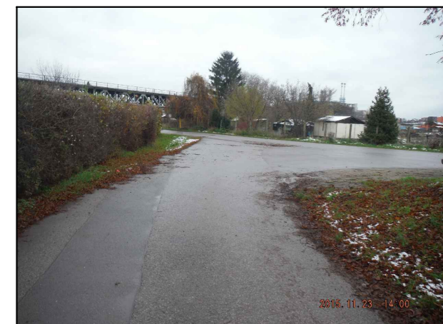
Station 0+340 Kreuzungsbereich Mittelstraße, Rückblick Richtung Am Werder (Saale)
