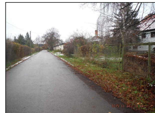
Station 0+410 Mittelstraße, Rückblick Richtung, linksseitig gepl. HWSA
