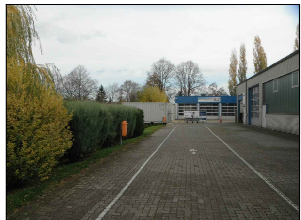
Station 0+610: Gelände Autohaus, Rückblick Richtung Am Platz der Jugend, gepl. HWSA entlang Grundstücksgrenze, Rodung Böschungsbereich und Neuanordnung der Einfriedung
