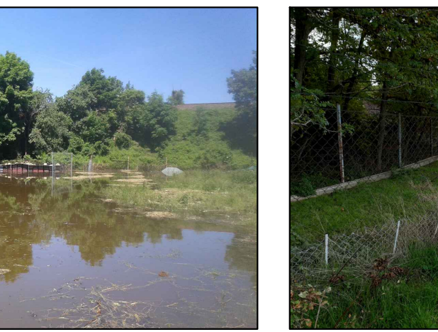
Station 0+130: 05.06.2013 Privatgrundstück, Blick Richtung Bahndamm
