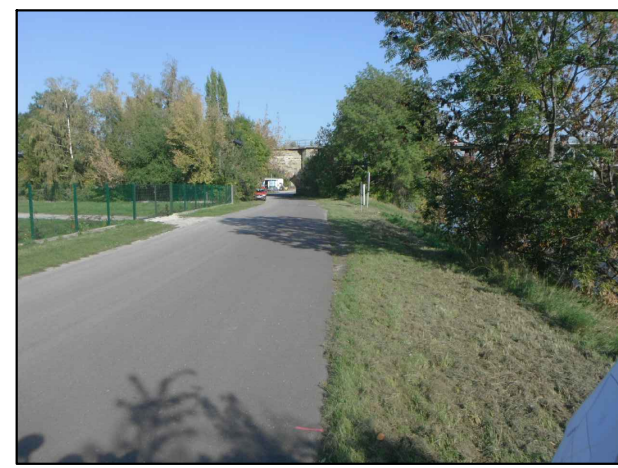
Station 0+000: Am Werder, Blick Richtung Bahndamm
