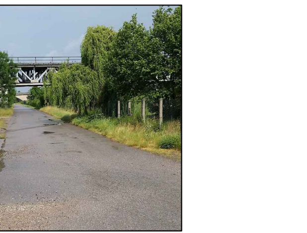
Station 0+300: Mittelstraße, Rückblick Richtung Bahndamm
