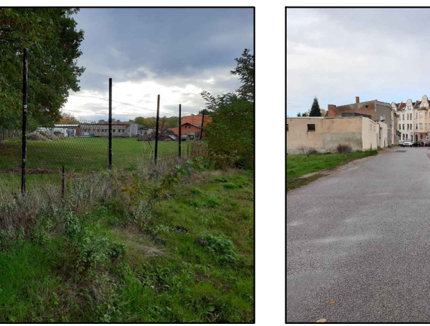
Station 0+210: ehem. Gartenverein Eintracht, Rückblick Richtung Privatgrundstück
