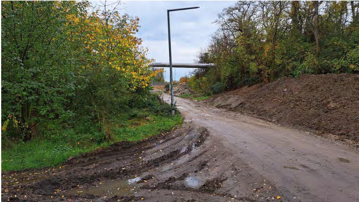
Abbildung 13 Südliches UG, Bereich KRB 24/KRB 25, Blickrichtung Süd
