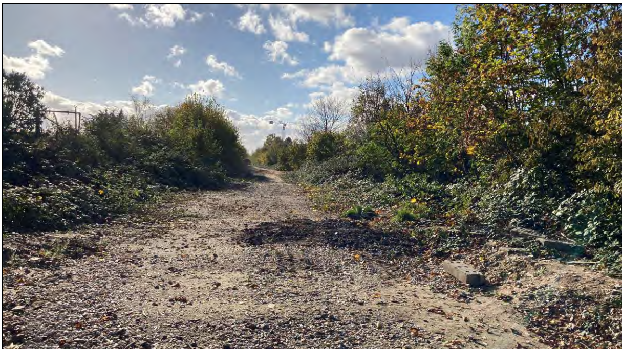
Abbildung 6 Zentrales UG, Bahndamm, Bereich KRB 12, Blickrichtung Nord
