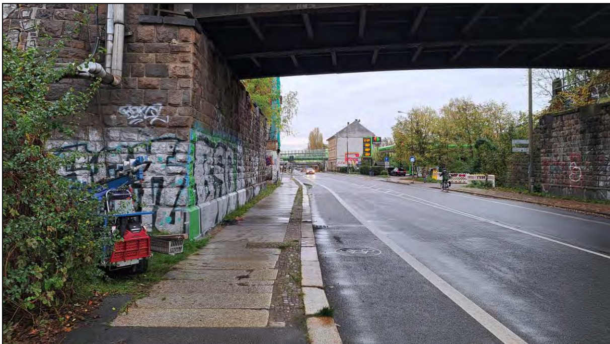
Abbildung 12 Südliches UG, Bereich KRB 22/KRB 23, Blickrichtung Ost
