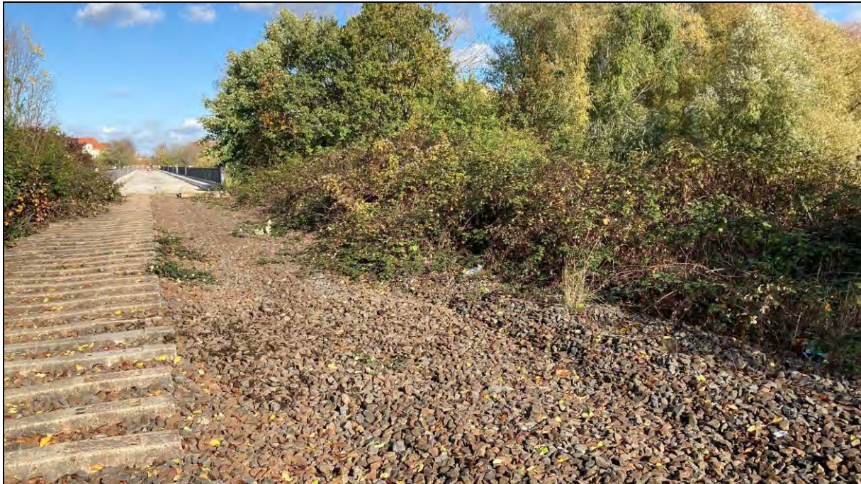
Abbildung 7 Zentrales UG, Bahndamm, Bereich KRB 13, Blickrichtung Nord
