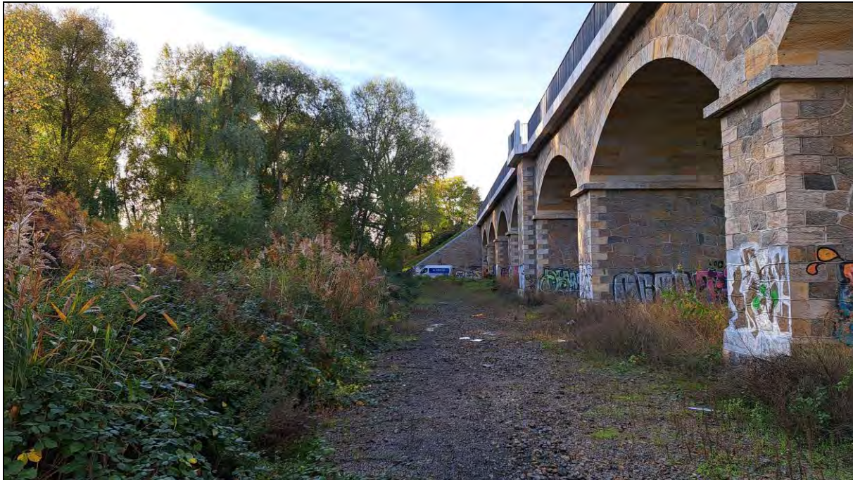
Abbildung 9 Zentrales UG, Viadukt Sellerhausen, Bereich KRB 16, Blickrichtung Süd
