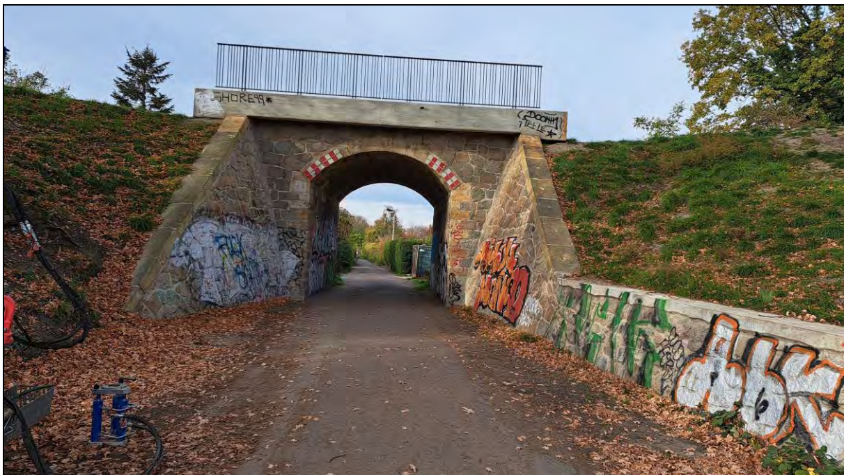
Abbildung 10 Zentrales UG, Bereich KRB 18, Blickrichtung Süd
