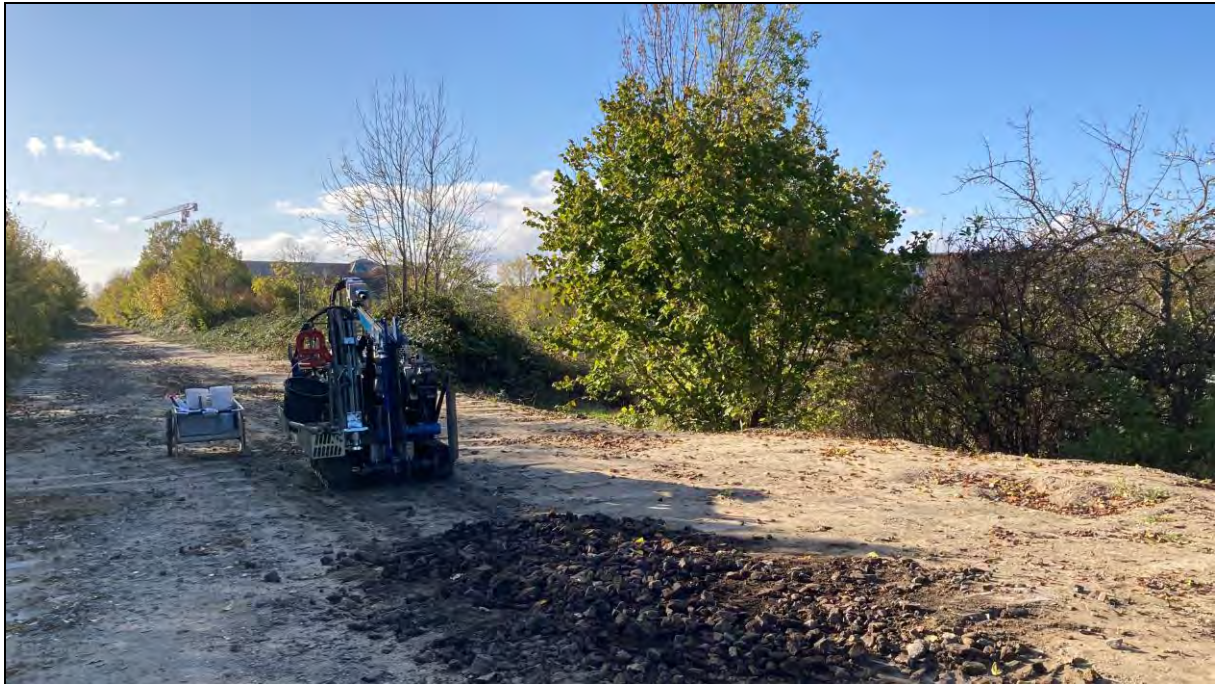
Abbildung 5 Zentrales UG, Bahndamm, Bereich KRB 11, Blickrichtung Süd
