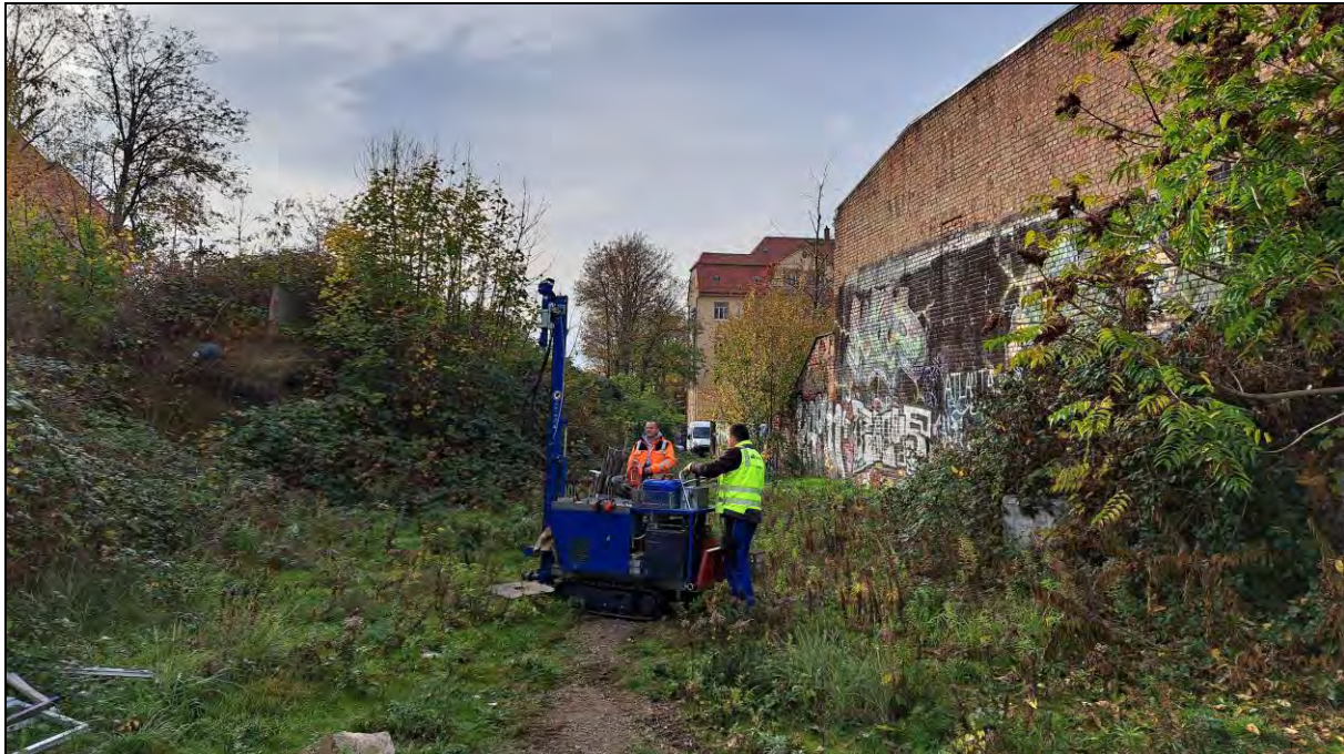
Abbildung 1 Nördliches UG, Bereich KRB 1, Blickrichtung Süd
