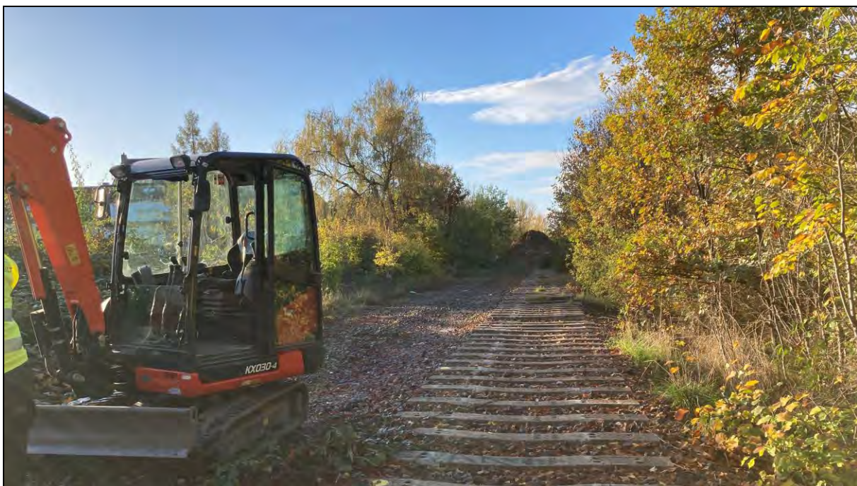
Abbildung 2 Zentrales UG, Bahndamm, Bereich KRB 8, Blickrichtung Süd
