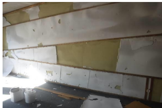
Abbildung 4: li. P10 KG Haus 3 unbelastetes Styropor, re. P15 Nachweispflichtiges Styropor Kirche 1.OG
