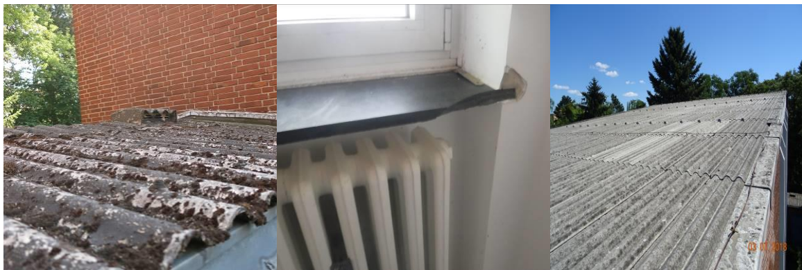
Abbildung 2: asbesthaltige Faserzement li P1. Dach vor Turm, mi.P2 asbesthaltige Fensterbank BZ, re. P12/12.1 Dach Kirche nicht asbesthaltig
