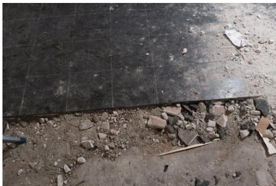
Abbildung 3: P16 PAK-haltiger Gussasphalt Empore Kirche
