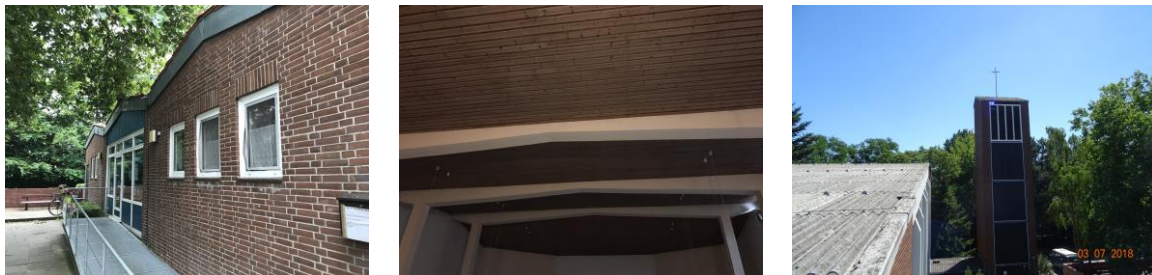
Abbildung 5: li. P7 BZ Holz im Dachbelastet, mi. P17 Deckenlamellen Kirche unbelastet, re. P21 Verkleidung Holz Turm belastet
