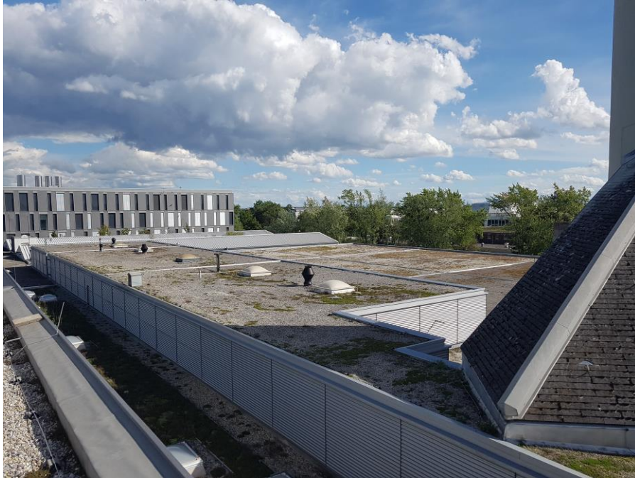
Abb. 22: Blick (nach Süd-Osten) auf den erhöhten Dachbereich mit Sammelkanal und zweigeschossiger Technikhalle Sammelkanal und Technikhalle haben ein gemeinsames Dach. In der statischen Machbarkeitsstudie wurde diese Dachfläche als Aufstellbereich „A“ mit den Unterbereichen „A.1“ über dem Sammelkanal (vorne, bis zum Übergangsbauwerk zum Fortluftkamin) und „A.2“ über der Technikhalle (hinter dem Kanal zurückspringend). Der Bereich A.2 verlangt nach statischen Ertüchtigungen.
