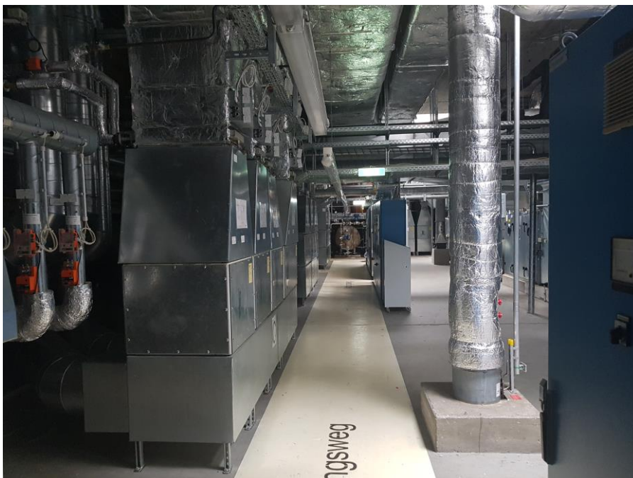
Abb. 27: Blick aus Raummitte in die westliche Technikhalle Auf der linken Bildseite schließt oberhalb der sog. Tierstreifen (unterhalb der regulären Dachfläche) ein Kriechgeschoss an. Rechts neben dem Erschließungsgang erstreckt sich die zweigeschossige Technikhalle; ganz rechts oben ist der Sammelkanal erkennbar.
