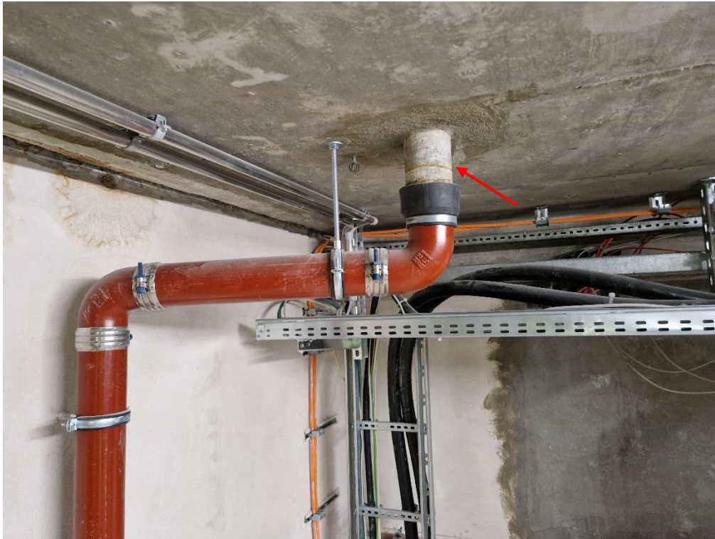
Abbildung 5: Asbestzementrohr Lüftungsauslass Dachunterseite
