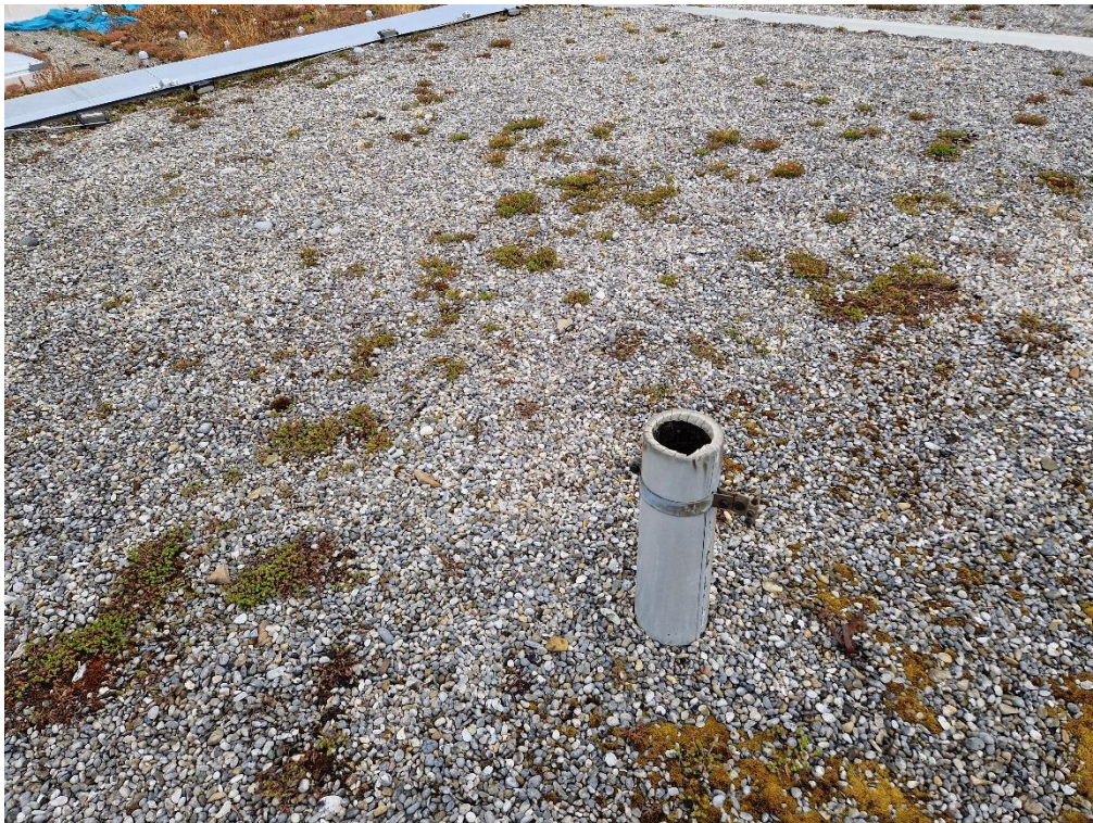
Abbildung 6: Asbestzementrohr Lüftungsauslass Dachoberseite
