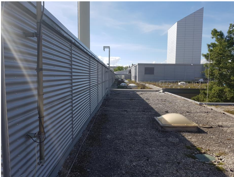
Abb. 23: Blick (nach Westen) entlang der Nordfassade des erhöhten Dachbereichs Erkennbar ist der Sammelkanal über seine gesamte Länge mit dem dahinterliegenden Sammelkanal (vorne rechts) und, im Hintergrund, die Oströhre des doppelzügigen Fortluftkamins. In der statischen Machbarkeitsstudie wurde die in Bildmitte liegenden Dachfläche über dem Südkorridor von G3500 als Aufstellbereich „B“ untersucht. Der Baum auf der rechten Seite befindet sich in dem G3511 gegenüberliegenden Innenhof.
