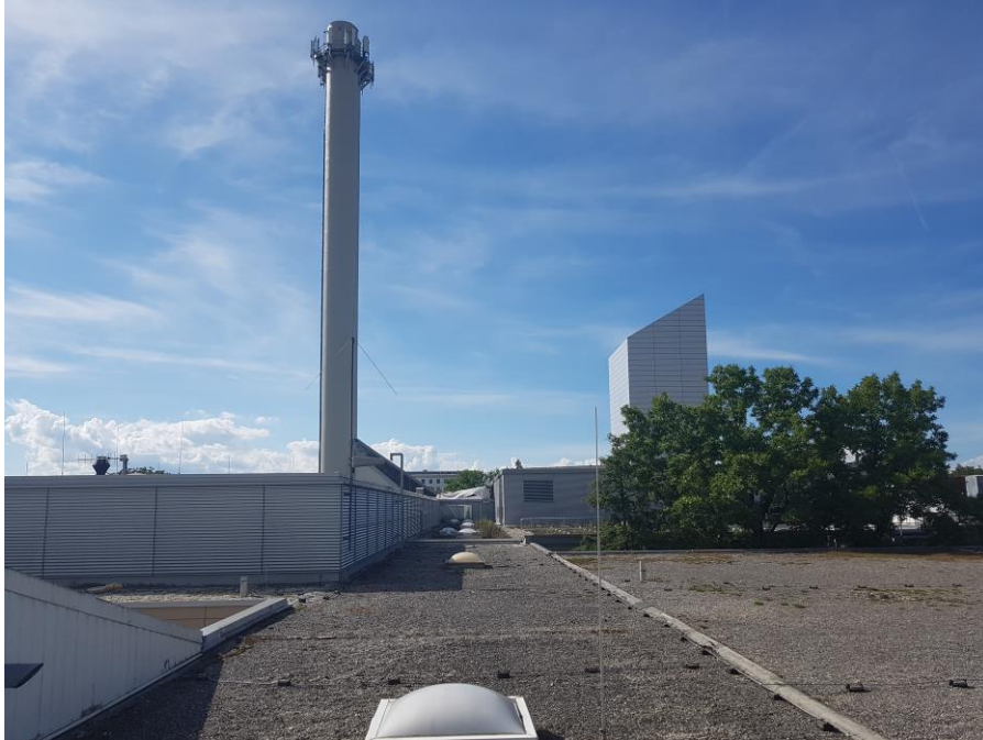
Abb. 32: Blick (nach Westen) vom Dach des Nachbargebäudes G3512 auf G3511 und den dahinterliegenden Fortluftkamin In G3512 befindet sich auch eine Tierhaltung, deren Abluft im Obergeschoss des Südkorridors von G3500 geführt und ebenfalls in den Sammelkanal über G3511 eingebracht wird. Rechts im Bild ist der Baum im Innenhof gegenüber von G3511 erkennbar.
