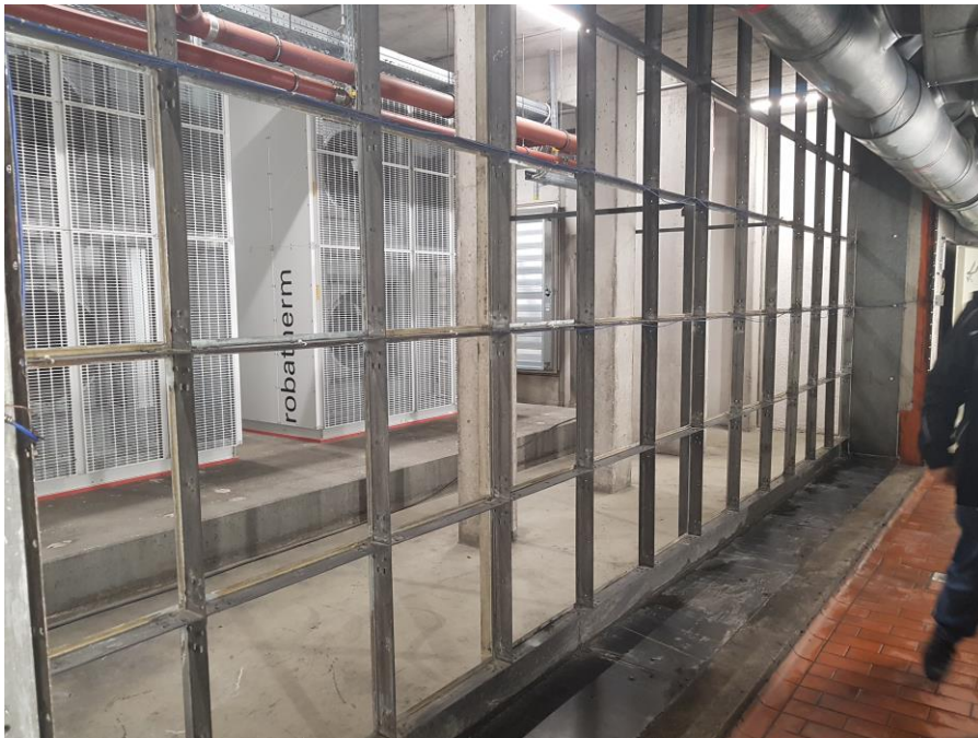
Abb. 21: Blick (nach Nord-Osten) aus dem Ansaugkanal auf die Tragraster für die Heizregister (hier demontiert)
