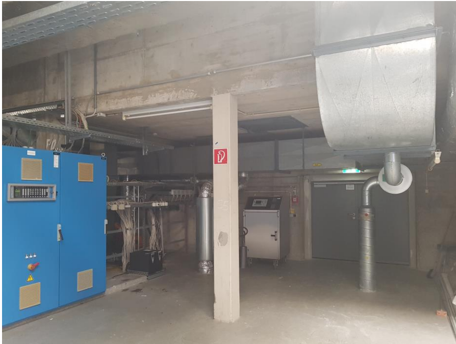
Abb. 26: Blick (nach Norden) aus der Technikhalle in den Zugangsbereich mit dem darüberliegenden Sammelkanal Vor der zweigeschossigen Technikhalle schließen über seinen Verlauf hinweg mehrere Abluftkanäle an den Sammelkanal aus Stahlbeton an (rechts beispielhaft erkennbar). In der Decke hinter der Stütze befindet sich die Zugangsklappe in den Sammelkanal.
