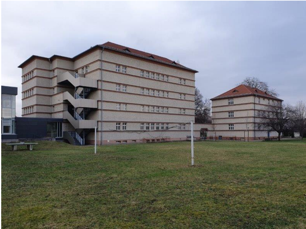
Bestandsgebäude Altbau Ansicht Süd
