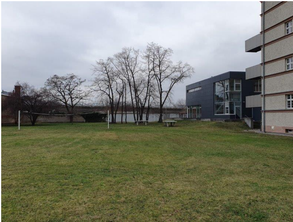
Baufeld Blick nach Westen
