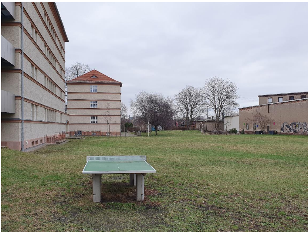
Baufeld Blick nach Osten
