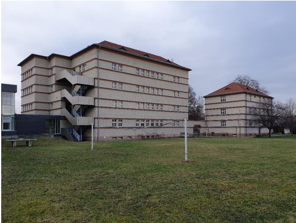
Bestandsgebäude Altbau Ansicht Süd
