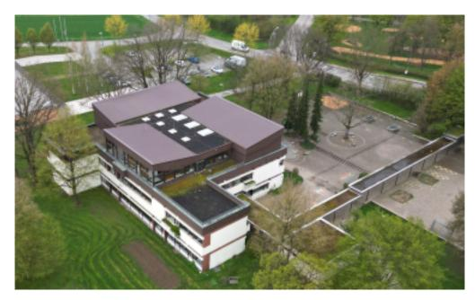
Im Zuge der Baumaßnahme wird das bestehende Gebäude weitgehend entkernt und anschließend energetisch saniert. Das aufgesetzte zweite Obergeschoß wird komplett abgebrochen und durch ein neues, größeres Geschoß in Holzbauweise (Holzständer- und Massivholzwände, CLT Decken) mit drei aufgesetzten Sheddächern ersetzt.
