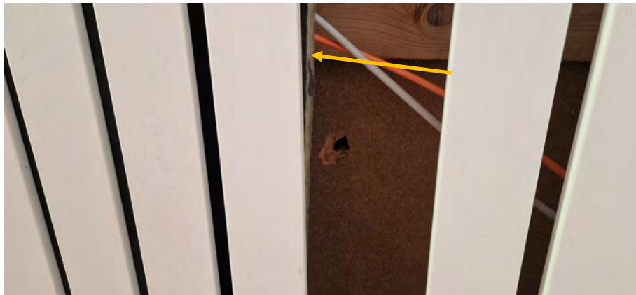
2. OG Decke Flur: Blechpaneel, KMF (Pfeil), Presspappe, KMF
