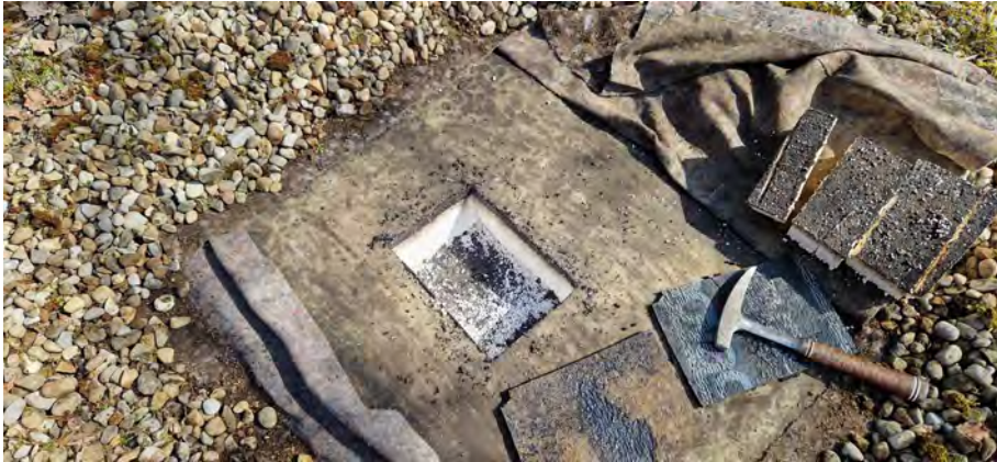
Dach über 1.OG Ost: Kies/Vlies/Bitumenbahn/Styropor/Bitumenbahn
