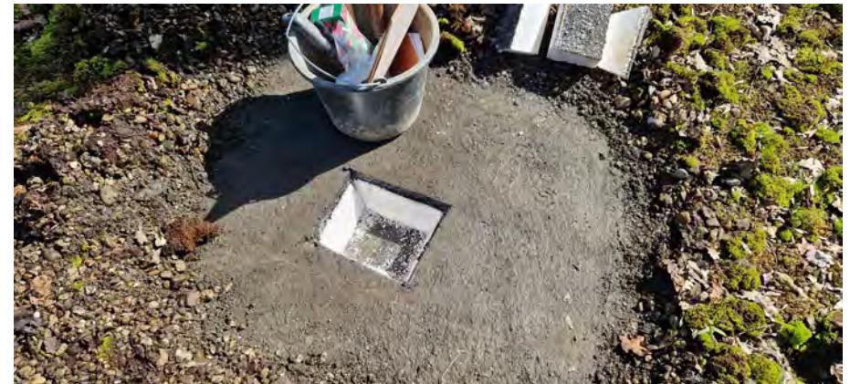
Dach über 1.OG W: Kies/Vlies/Bitumenbahn/Styropor/Bitumenbahn
