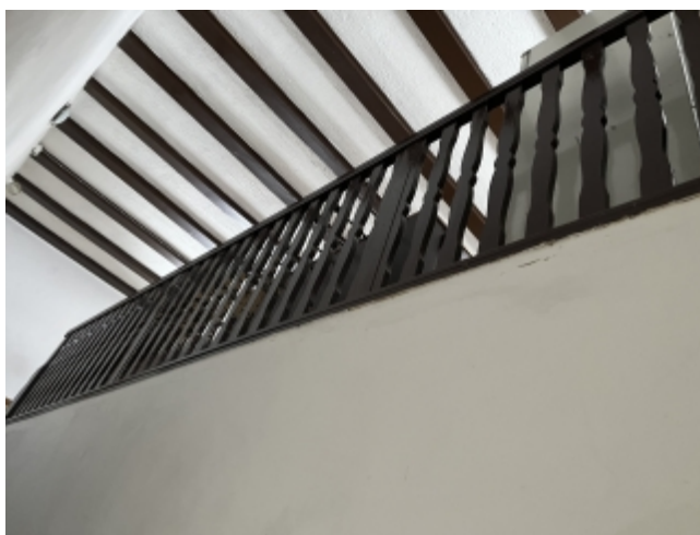
Geländer im OG Bürgerhaus
