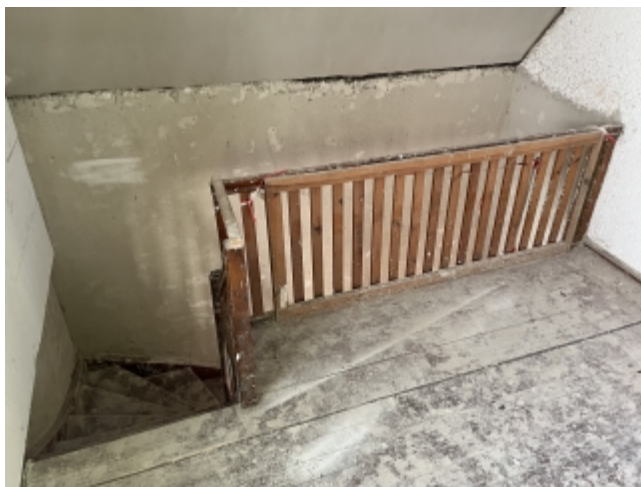
vorh. Geländer wird abgebrochen
