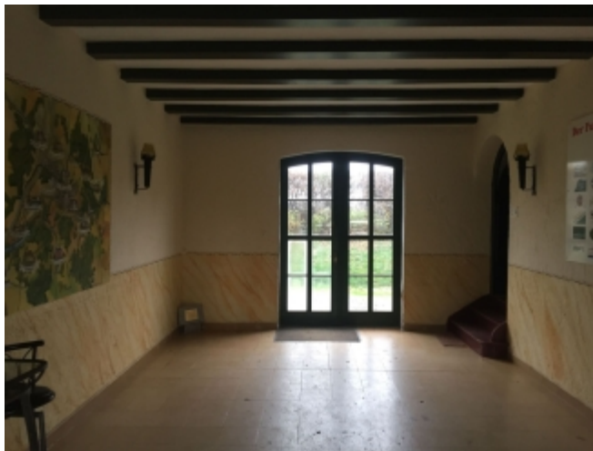
Beispiel der Deckenbalken im historischen Flur
