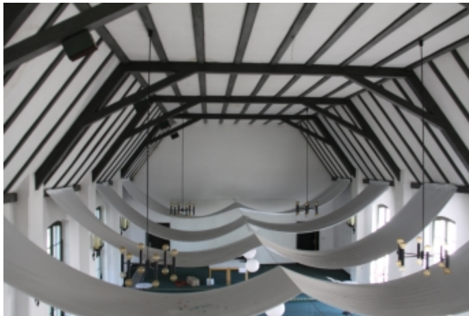
Zierbalken in der Goethehalle
