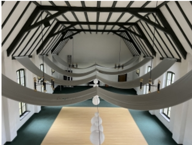
Große Tragbalken in der Goethehalle
