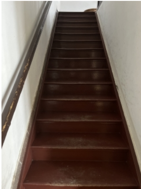
Treppe mit Handlauf im Bürgerhaus
