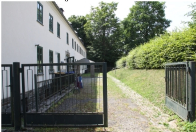
Blick zum Baufeld des Neubaus, oberhalb befindet sich die Laufbahn mit dem Stadion
