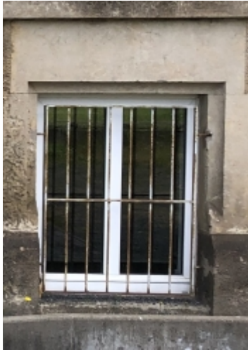
Beispielfenster UG: Außenansicht mit Fenstervergitterung
