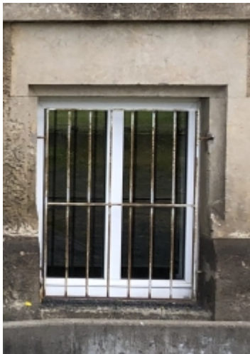
Beispielfenster UG: Außenansicht mit Fenstervergitterung
