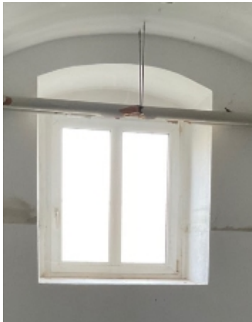
Beispielfenster UG: Innenansicht- betreffende Fenster ohne Rohrleitung im Ausbaubereich
