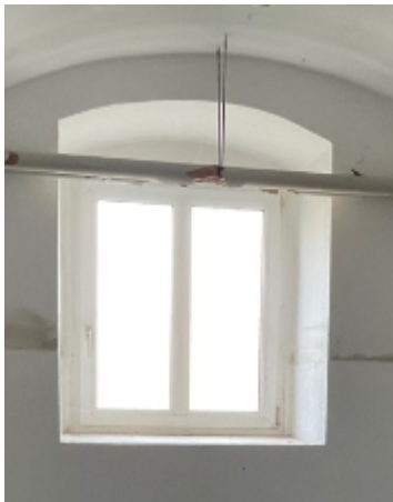
Beispielfenster UG: Innenansicht- betreffende Fenster ohne Rohrleitung im Einbaubereich
