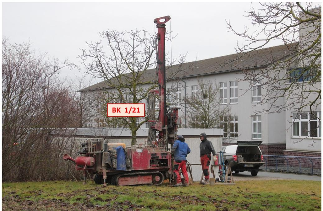
Foto 2: Bereich der Zufahrt und des Parkplatzes an der Südwestseite des geplanten Erweiterungsneubaus – Bohrgerät am Ansatzpunkt der Bohrung BK 1/21/ Blick in Richtung Südosten (14.12.2021)
