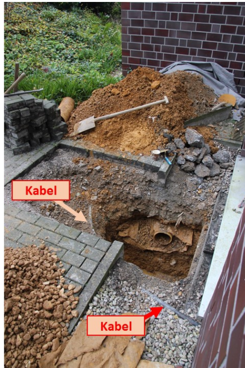
Foto 36: Schurf 1/21 – Kabel im Bereich des Schurfes/ Blick in Richtung Osten (17.01.2022)
