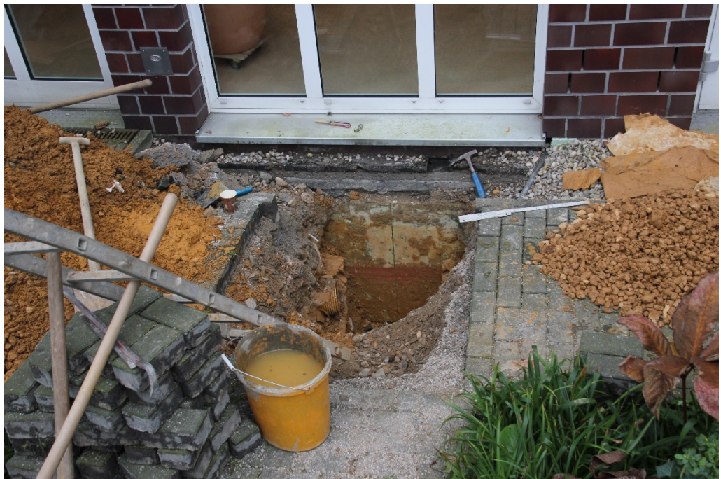
Foto 34: Schurf 1/21 – Ansicht/ Blick in Richtung Süden
