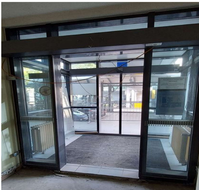
Ansicht von innen (1) - Innen- und Außenanlage
