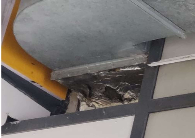
Ansicht Bestand - noch mit Lüftungskanal (jetzt demontiert)
