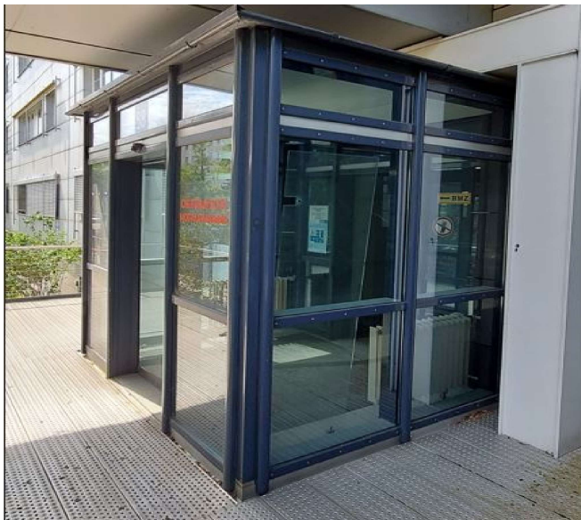
Ansicht von außen
