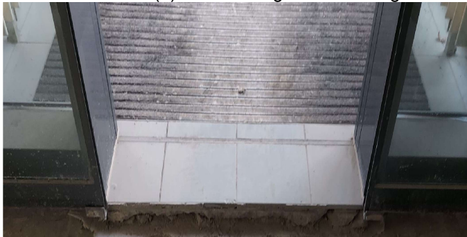
Ansicht von innen (6) - Bodendetail an Innenanlage
