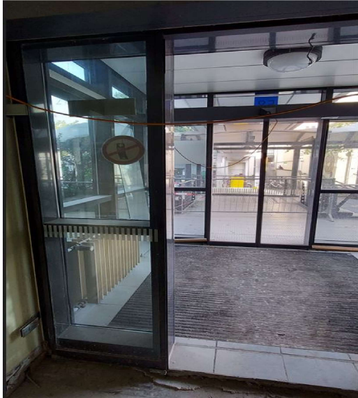
Ansicht von innen (2) - Innen- und Außenanlage
