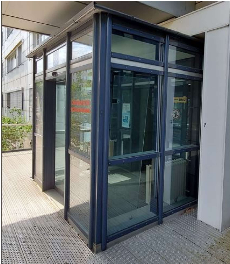
Ansicht von außen
