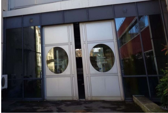
Ansicht von außen - Krankenwagen-Einfahrt
