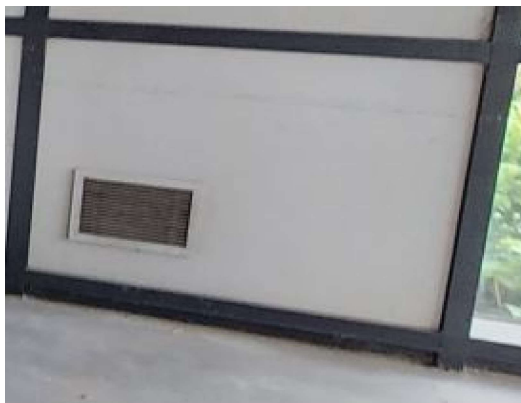
Ansicht demontierter Lüftungsauslass (- neu mit Glattblech)
