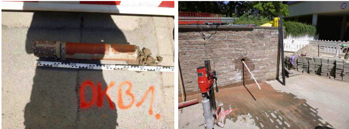
Abb. 10 a,b: Bohrkern der HB 1 (Bereich Stützwand)
