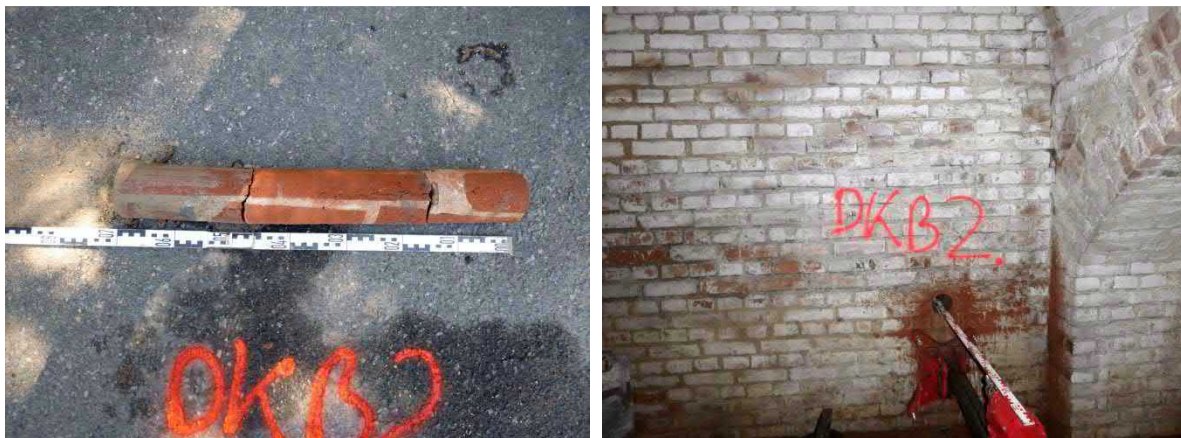
Abb. 11a,b: Bohrkern der HB 2 (Bereich Gewölbekeller)
