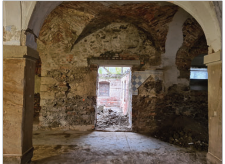
Neuer Durchgang von Restaurant zur Küche
