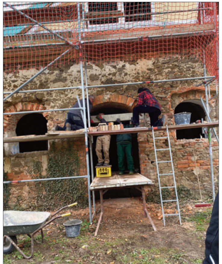
Setzen Sturz Eingang zum Restaurant
