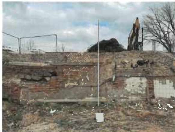
Abbildung 17 Blick auf Betonkanal
