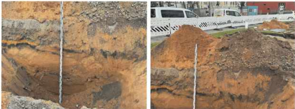
Abbildung 14 Aushubtiefe Schurf 4 beträgt 0 - 2,60 m. Blick auf Aushubmaterial
