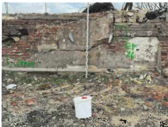
Abbildung 18 Entnahmestelle EP 15 Putz mit Ziegel linke Mauerseite und EP 16 Putz mit Ziegel rechte Mauerseite
