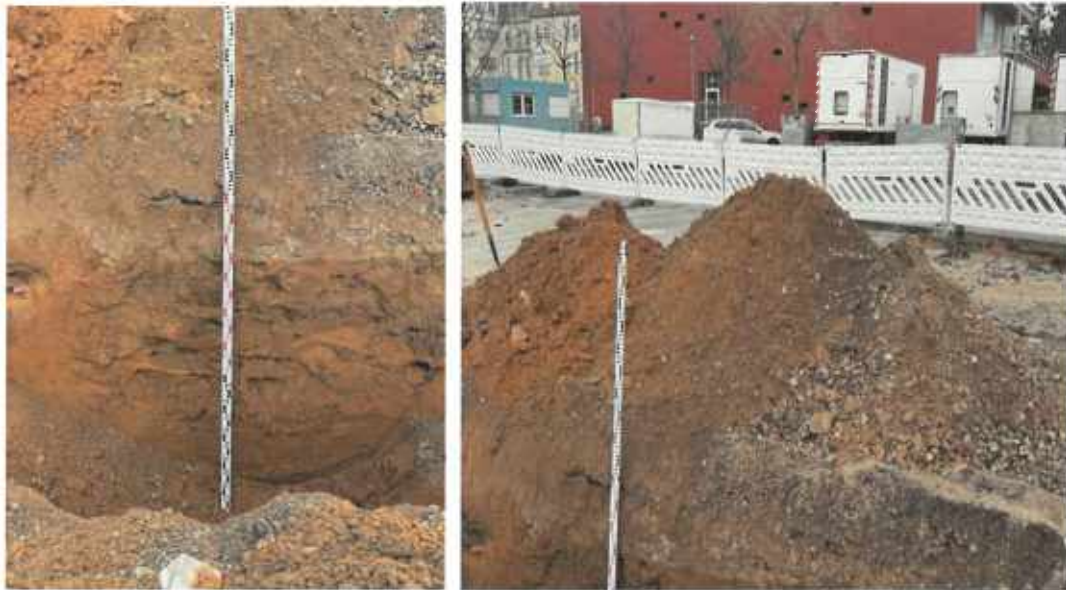
Abbildung 8 Aushubtiefe Schurf 2 beträgt 0 - 2,10 m. Blick auf Aushubmaterial
