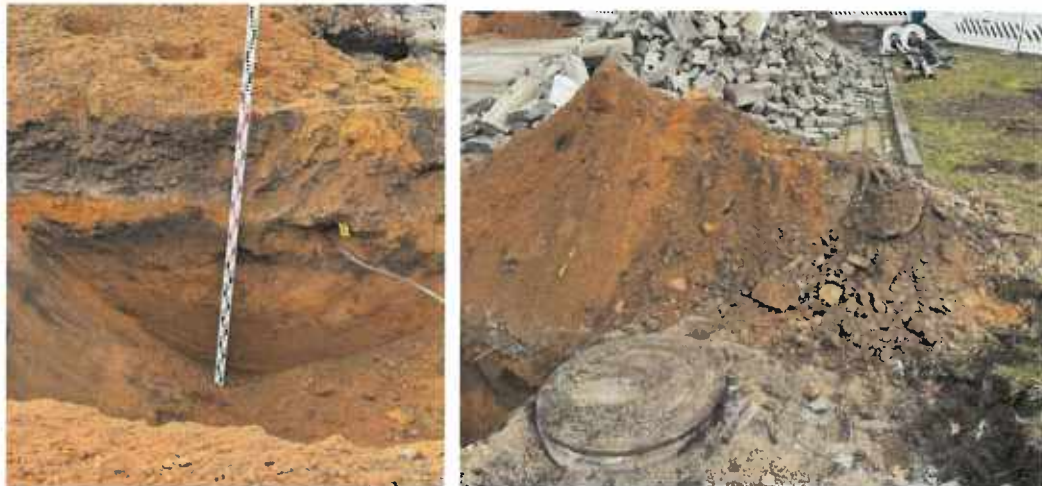
Abbildung 11 Aushubtiefe Schurf 3 beträgt 08 - 1,90 m. Blick auf Aushubmaterial
