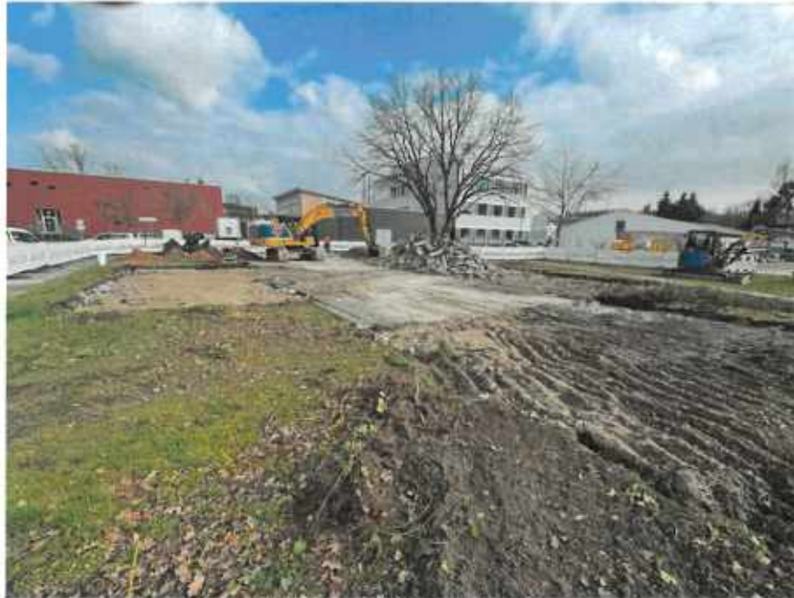
Abbildung 3 Blick auf Baufeld
