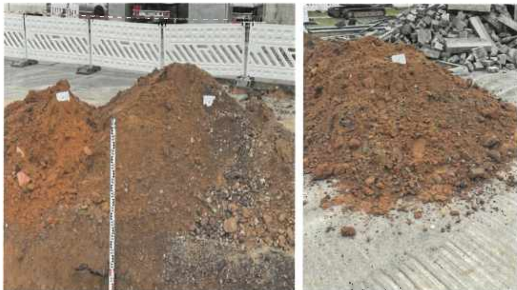
Abbildung 9 Entnahmestelle Einzelproben EP 4 (Sand) EP 5 (Auffüllung) EP 6 (lehmiger Boden)
