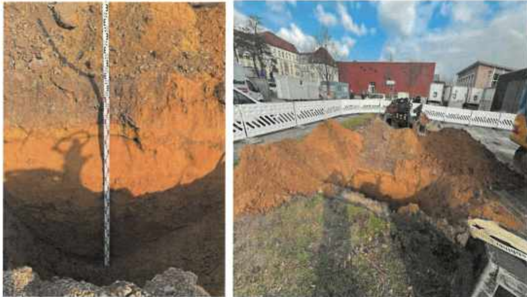
Abbildung 5 Aushubtiefe Schurf 1 beträgt 0 - 1,90 m. Blick auf Aushubmaterial
