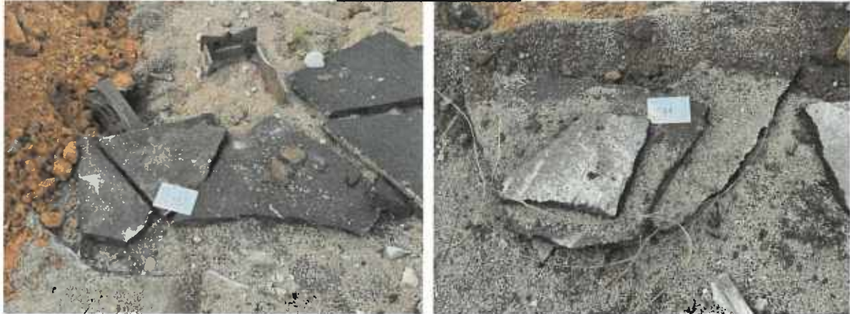
Abbildung 16 Entnahmestellen EP 13 Gussasphalt Schurf 1 und EP 14 Gussasphalt Schurf 4
