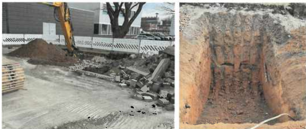
Abbildung 7 Blick auf freigelegten Schurf 2 im Feld 2
