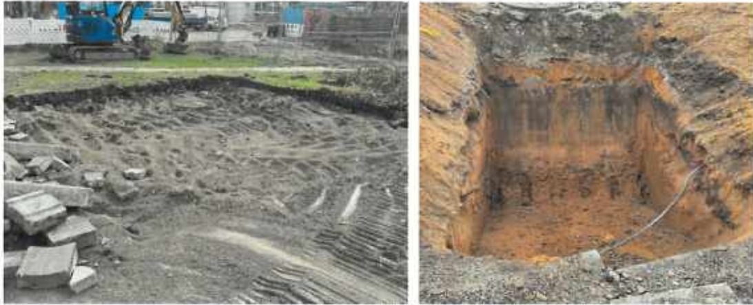
Abbildung 10 Blick auf freigelegten Schurf 3
