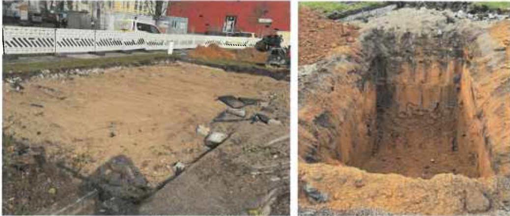
Abbildung 13 Blick auf freigelegten Schurf 4
