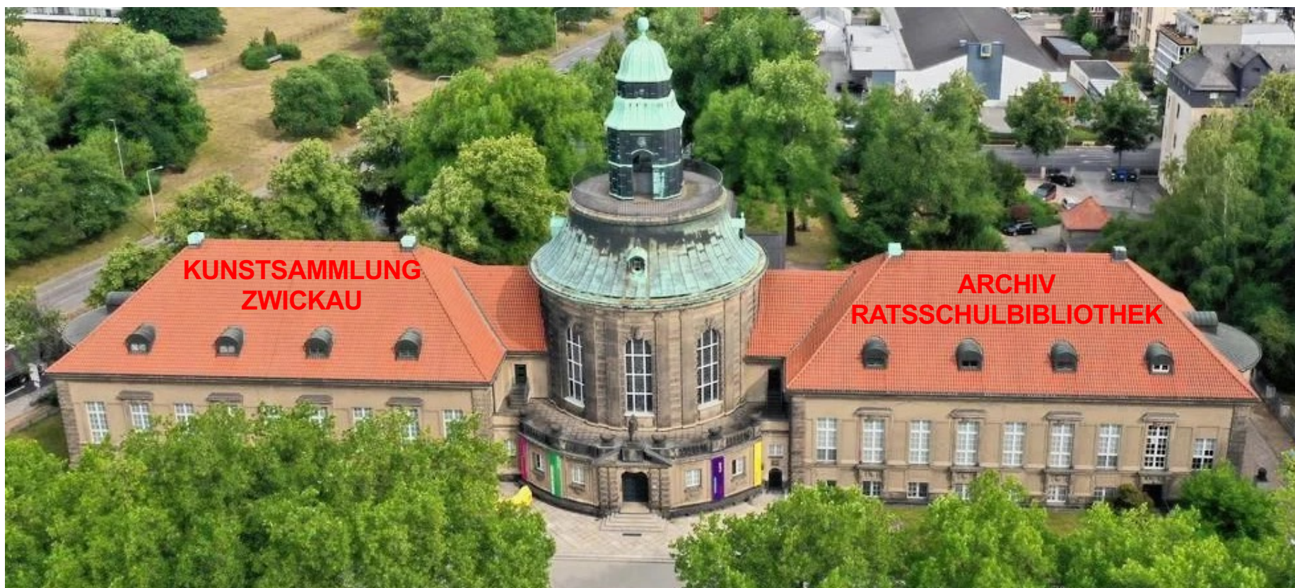
Ansicht Lessingstraße, Gebäude von 1914 für die Nutzer Kunstsammlungen, Ratsschulbibliothek und Stadtarchiv Zwickau
