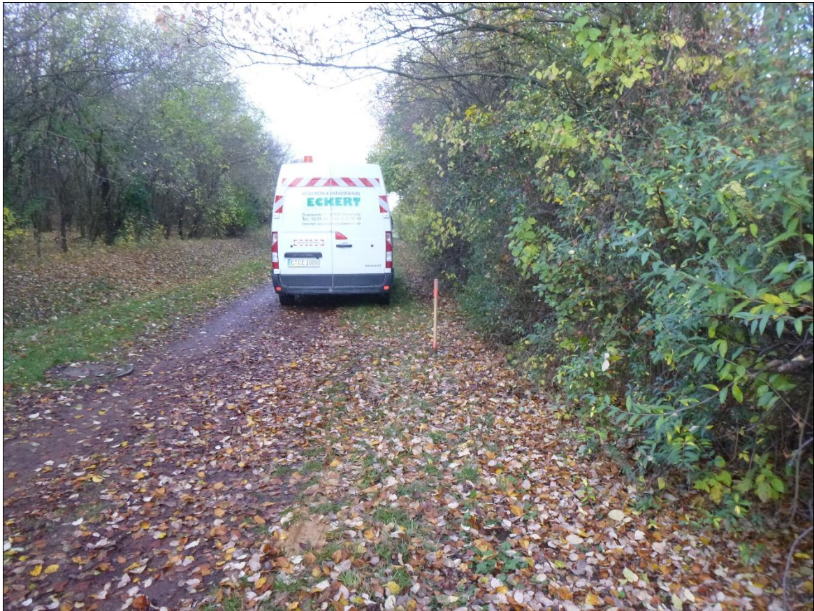
Rammkernsondierung (RKS) 8 – Ansatzpunkt
